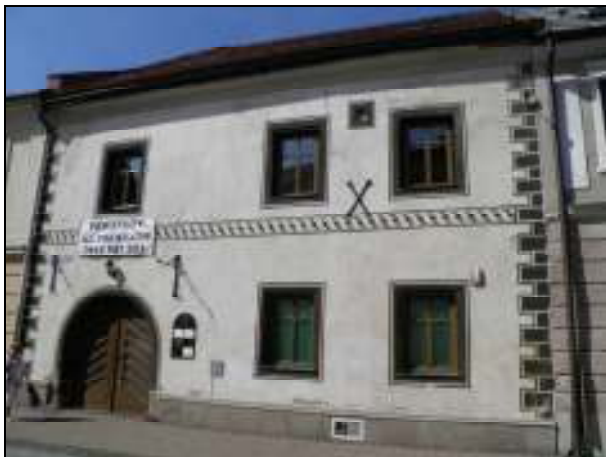
17. Lazovná 5. Rekonštrukcia neskororenesančnej maľovanej výzdoby z obdobia okolo roku 1630 s esovkovými motívmi.
