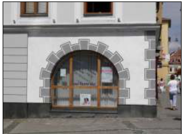
18. Námestie Štefana Moysesa 11. Rekonštrukcia neskororenesančnej výzdoby na otvore podlubia.
