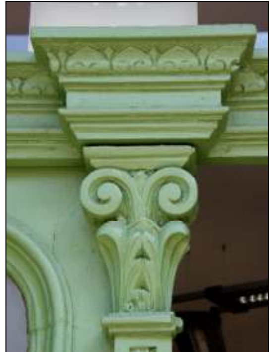
36. Detail vyrezávanej hlavice výkladu na krycej lište vstupných dverí.
