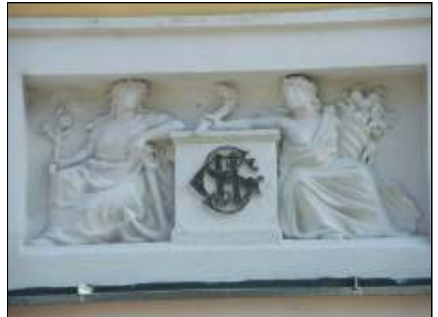
30. Podokenná výplň okna na 2.NP nad vstupom do prejazdu.
