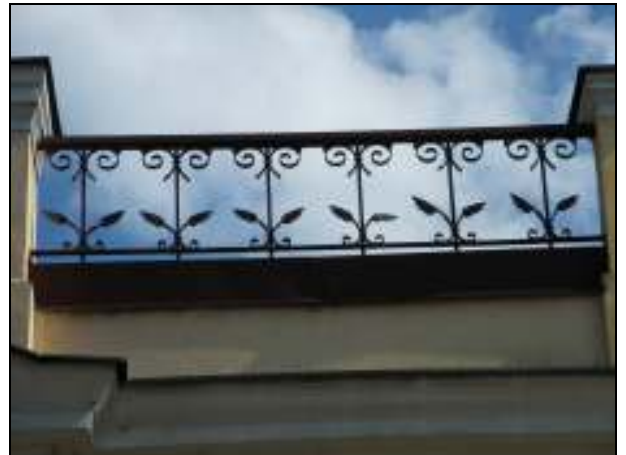
61. Dolná 7, meštiansky dom. Atikové ukončenie hlavnej fasády s kovanou výplňou, koniec 19. storočia.
