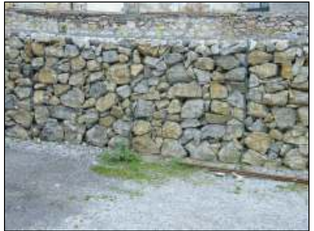
67. Náznaková rekonštrukcia parcelácie v tvare gabiónového muriva, júl 2014.
