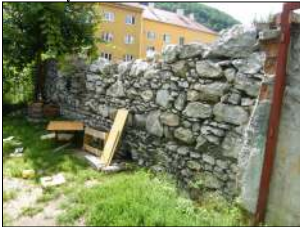
66. Parcelačný múr z riadkového muriva medzi meštianskymi domami na Dolnej 15 a 17.
