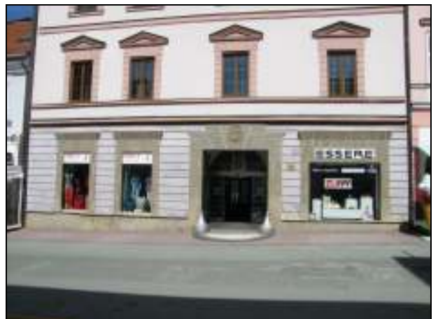
42. Dolná 18. Nevhodné obloženie otvorov kamenným obkladom, tvary obloženia s náznakom rímsy.
