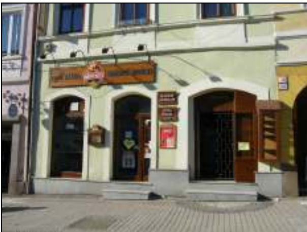
39. Dolná 20. Neprimeraná veľkosť otvorov v mieste pôvodných okien, nevhodný tvar výkladov so segmentovým záklenkom.
