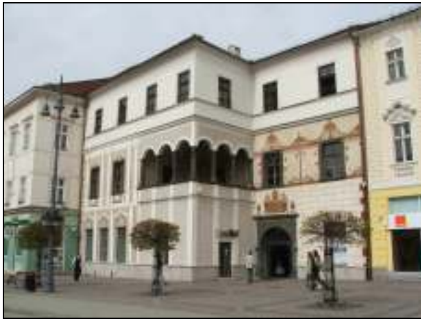
3. Maľovaná renesančná výzdoba na východnej strane fasády.
