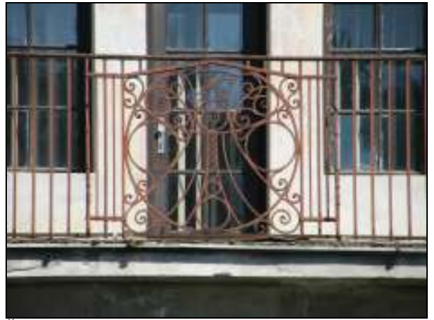
65. Štefánikovo nábrežie 4, mestská vila, detail mreže balkóna, po roku 1930.
