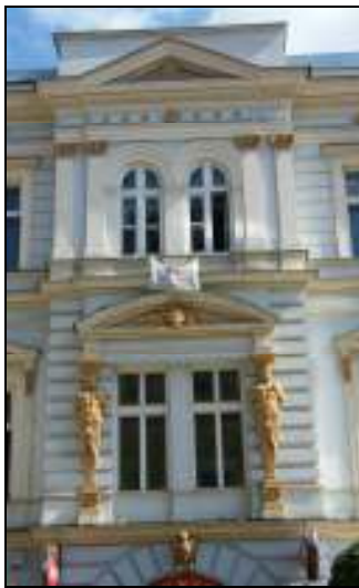
25. Dolná 13. Detail štukovej výzdoby na 2.NP hlavnej fasády, 19. storočie.
