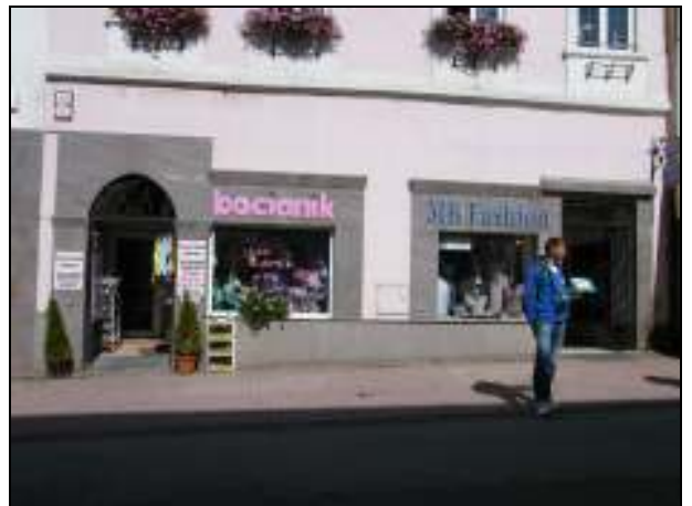
40. Dolná 22. Nevhodné obloženie otvorov kamenným obkladom, plošné obloženie vľavo, tvary obloženia s náznakom rímsy, zdôraznenie sekundárneho vstupu z ulice na úkor pôvodného vstupu.
