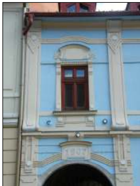
22. Dolná 21. Detail secesnej štukovej výzdoby, rok 1907.
