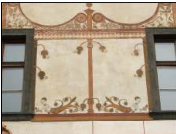
5. Maľovaná renesančná výzdoba na východnej strane fasády.
