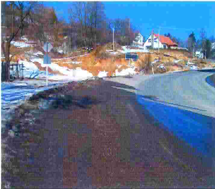
Vstup do mesta zoSV- nevhodné terénne zásahy
