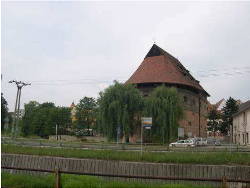
K – pohľad na juhovýchodnú časť mestského opevnenia s hrubou baštou
