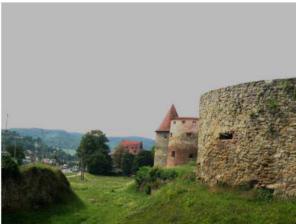
M – pohľad na východnú časť mestského opevnenia
