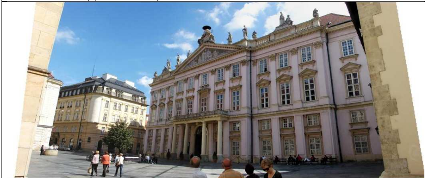
Chránený pohľad č. C-16 Pohľad na Primaciálny palác z Kostolnej ulice
