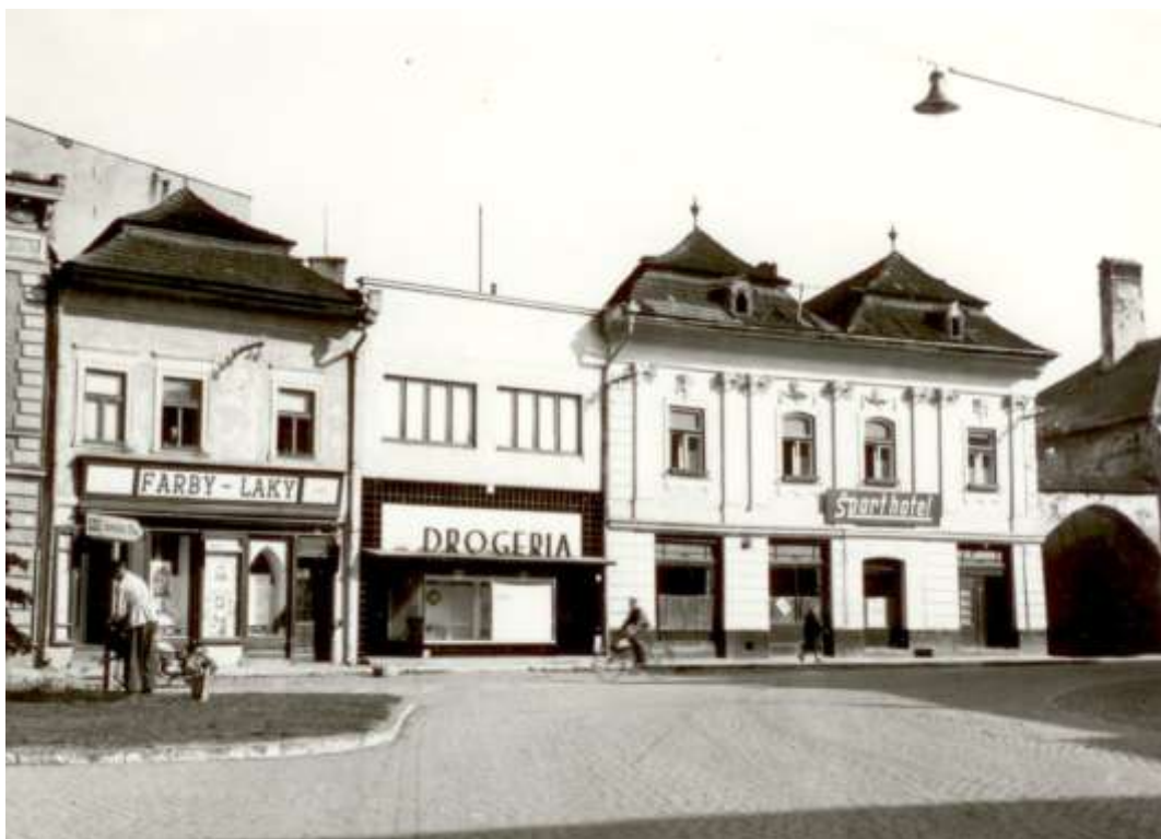
74. Hlavné námestie, sprava meštiansky dom č. 36, dom č. 38 a meštiansky dom č. 40, r. 1952, archív PÚ SR, č. neg. 1580/10
