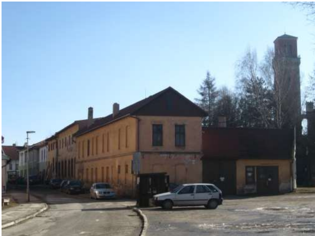
149. Baštová ulica, severozápadný pohľad na juhozápadnú časť zástavby
