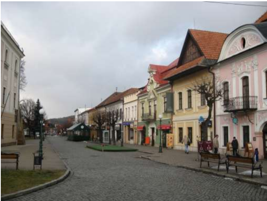
103. Hlavné námestie, juhovýchodná strana zástavby, sprava meštiansky dom č. 46 a vyššie
