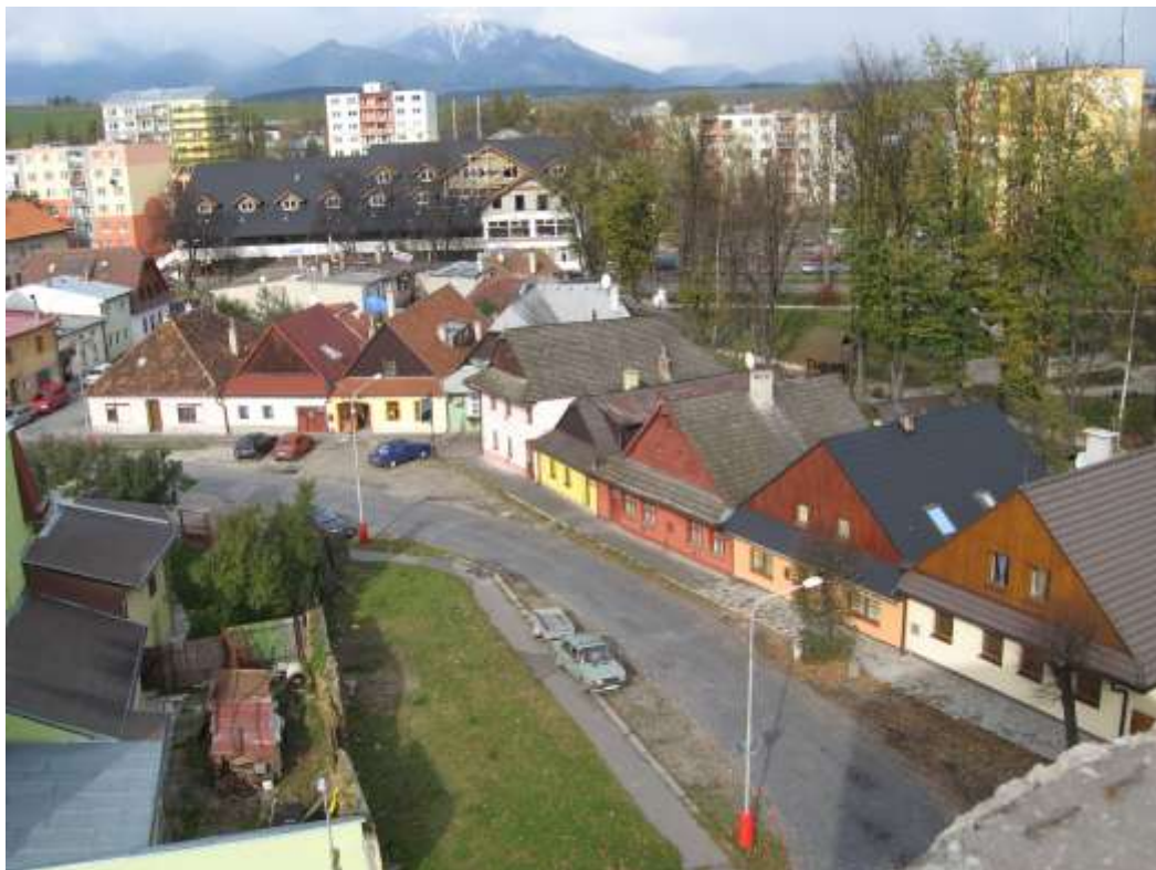
129. Pohľad na zástavbu severovýchodnej časti Starého trhu, v popredí plocha po asanácii (R 11)
