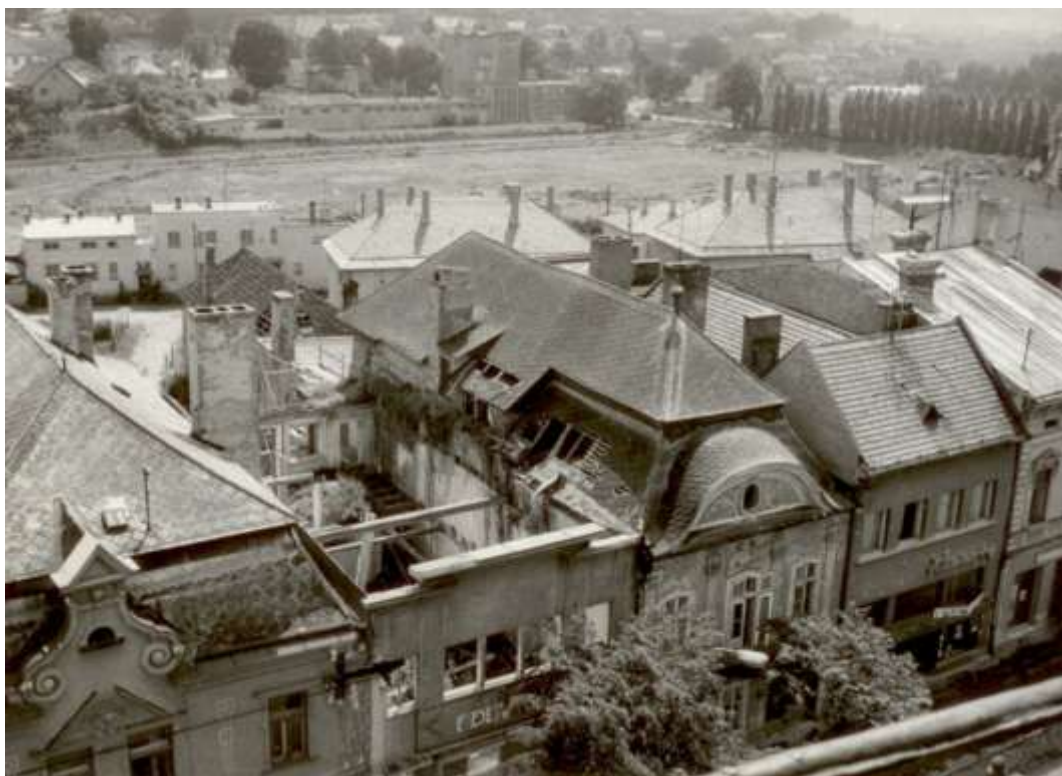
76. Hlavné námestie, zľava meštiansky dom č. 50, dom č. 48, meštiansky dom č. 46, dom č. 44 a meštiansky dom č. 42, r. 1985
