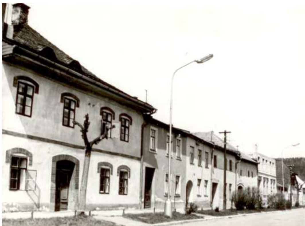
90. Starý trh, severná strana zástavby, zľava meštiansky dom č. 33 a vyššie, r. 1976, archív PÚ SR, č. neg. 75585
