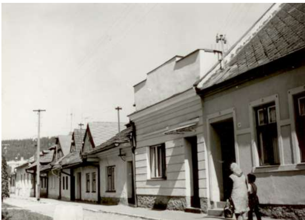
93. Starý trh, sprava meštiansky dom č. 10 a vyššie, r. 1976, archív PÚ SR, č. neg. 75596
