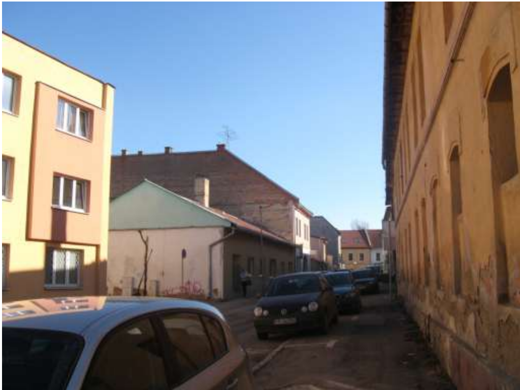
150. Baštová ulica, severozápadný pohľad na južnú časť uličnej zástavby
