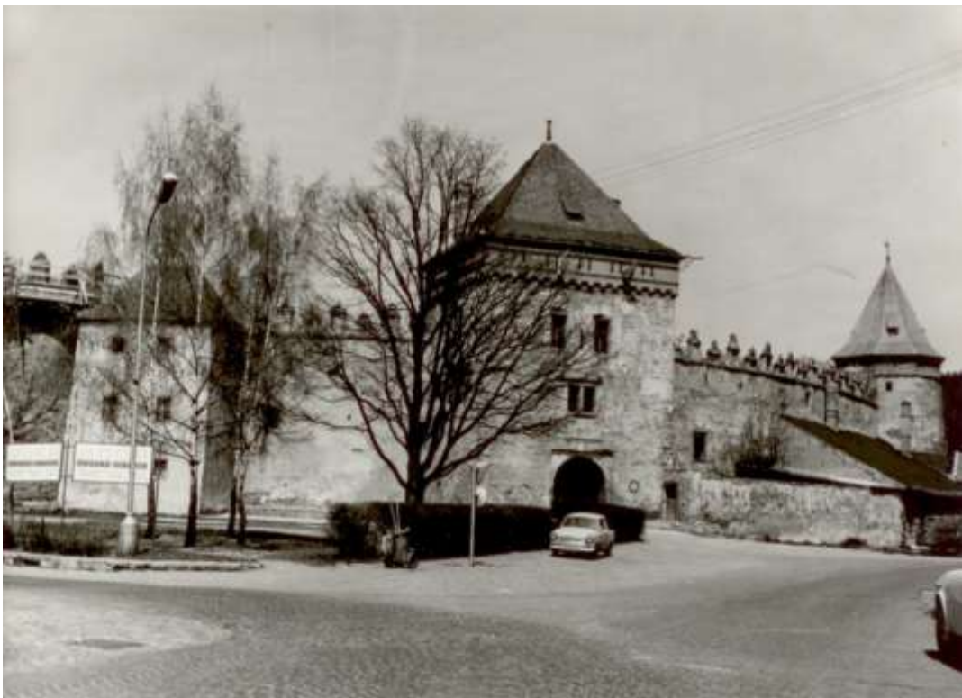
55. Juhovýchodný pohľad na hrad pred obnovou, r. 1976, archív PÚ SR, č. neg. 75372
