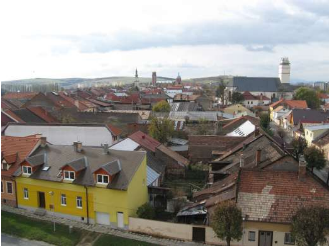
126. Severovýchodný pohľad na časť zástavby Hradného námestia v popredí a vpravo na zástavbu Novej ulice
