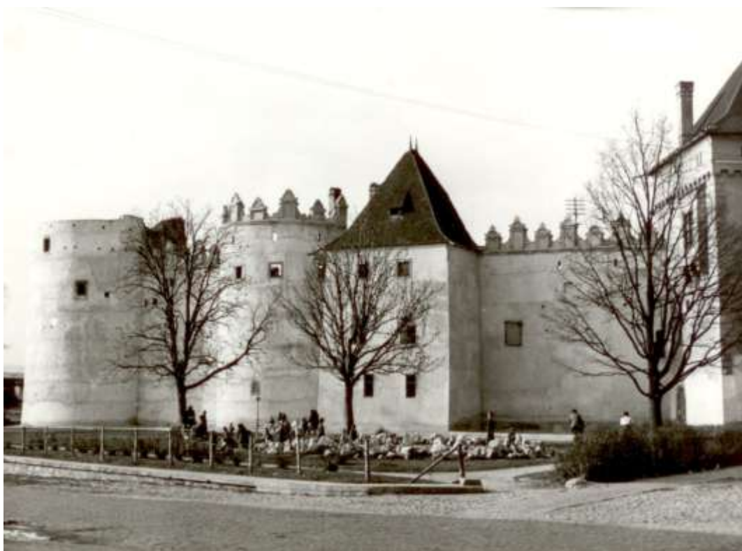
56. Južný pohľad na hrad, r. 1952, archív PÚ SR, č. neg. 1381/4
