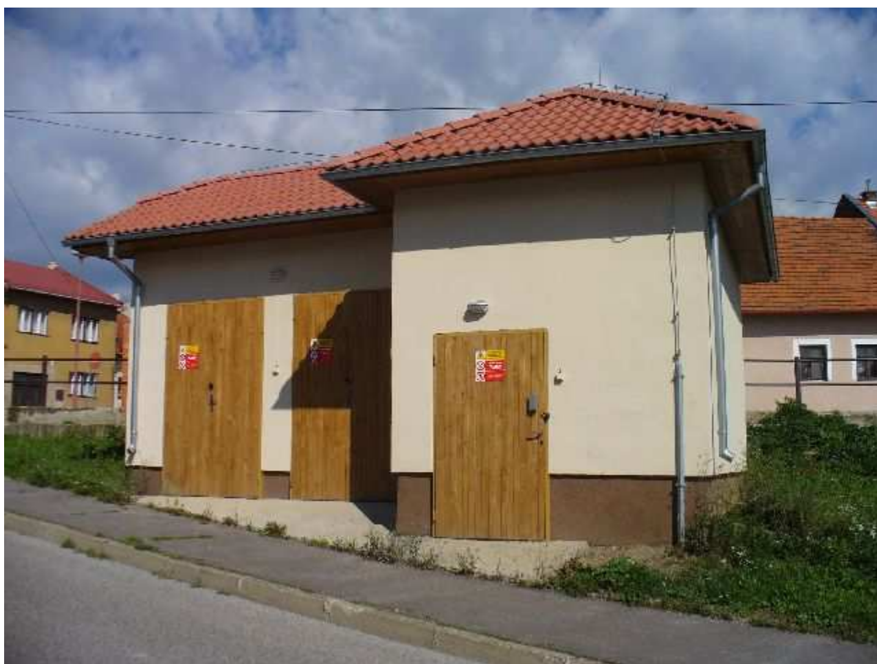
Bottova trafostanica v západnom ukončení ulice
