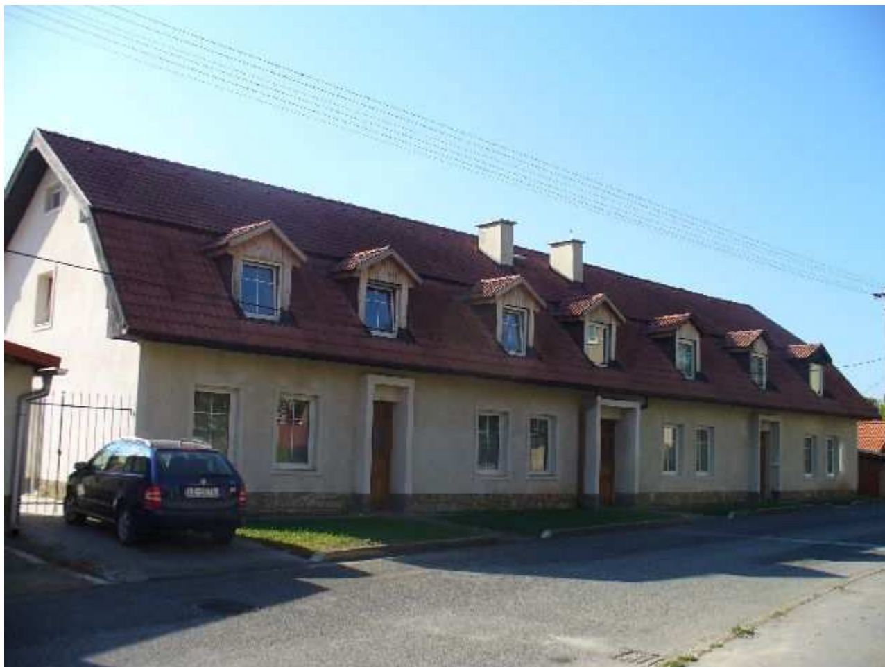
Bottova ul - JV časť - dom pri kasárňach
