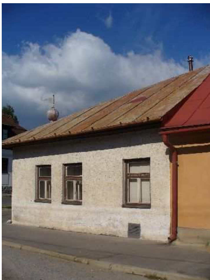
Bottova fasáda rohového domu do Žiackej ul.
