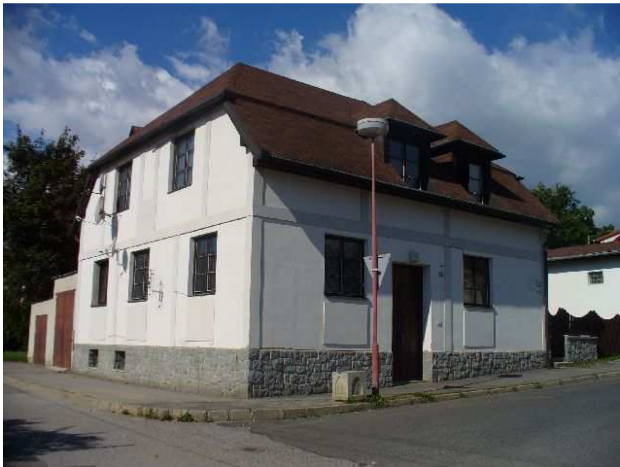
Bottova fasáda rohového domu južného na Žiackej ul.
