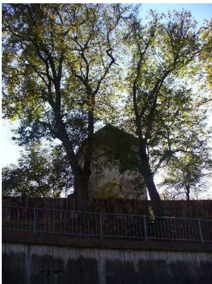
MPR SV časť opevnenia od S
