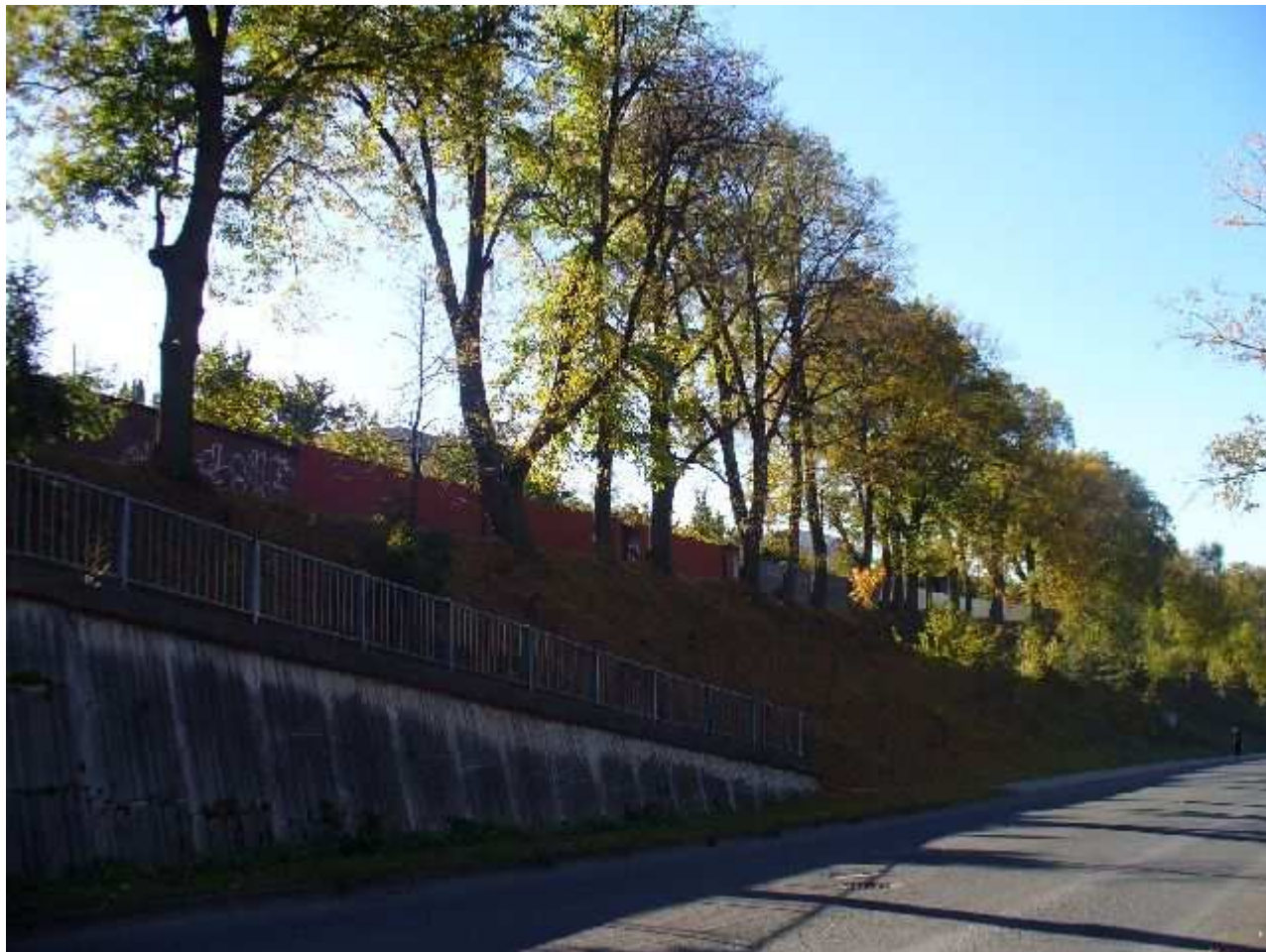
MPR SV časť opevnenia od S
