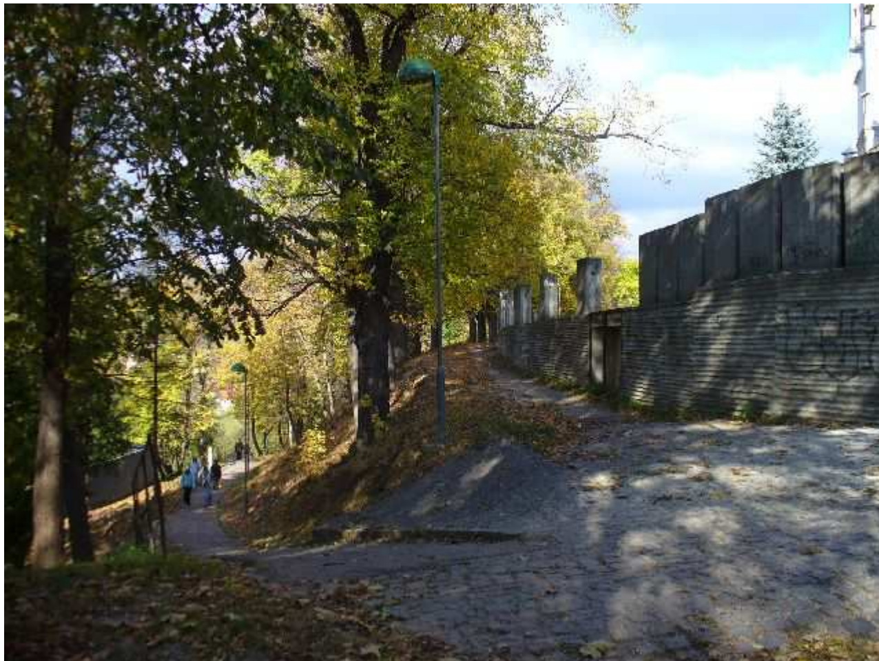
opevnenie mestské pohľad od juhu na západnú časť
