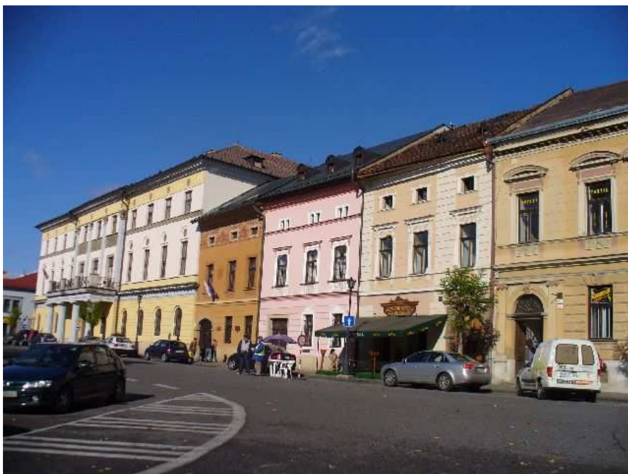
NMP pohľad od JV na S časť 2
