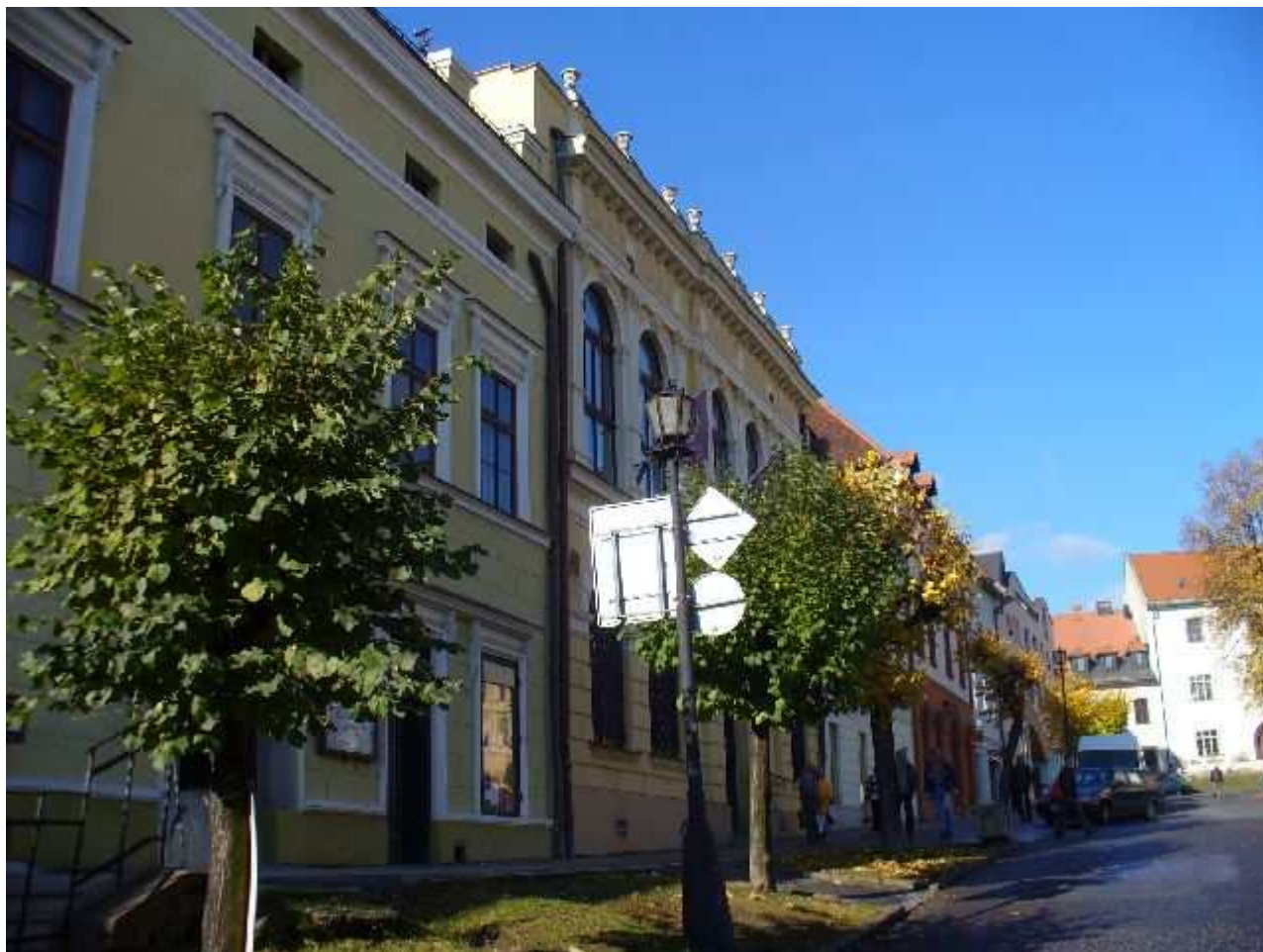
NMP pohľad od V na J časť
