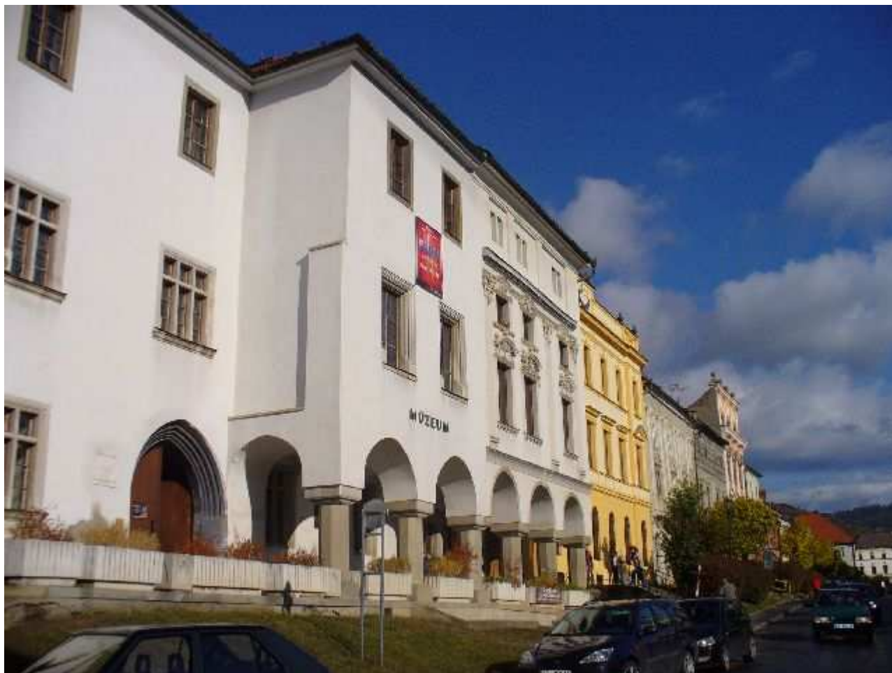
NMP pohľad od JV na JZ časť
