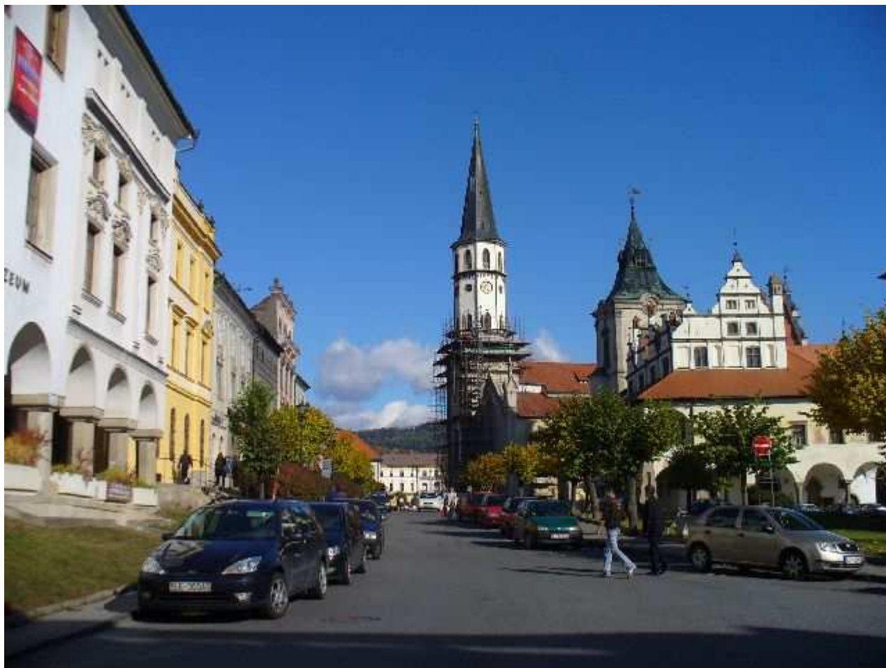
NMP JZ časť a NMP 2 od JZ
