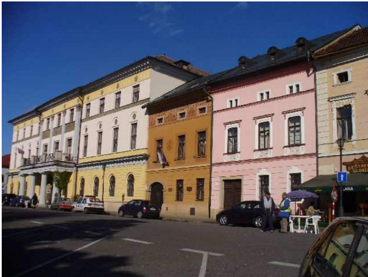
NMP pohľad od JV na S časť
