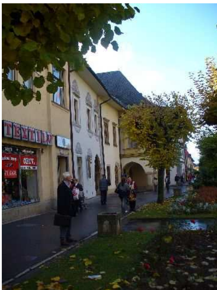
NMP pohľad od S na JV časť 3
