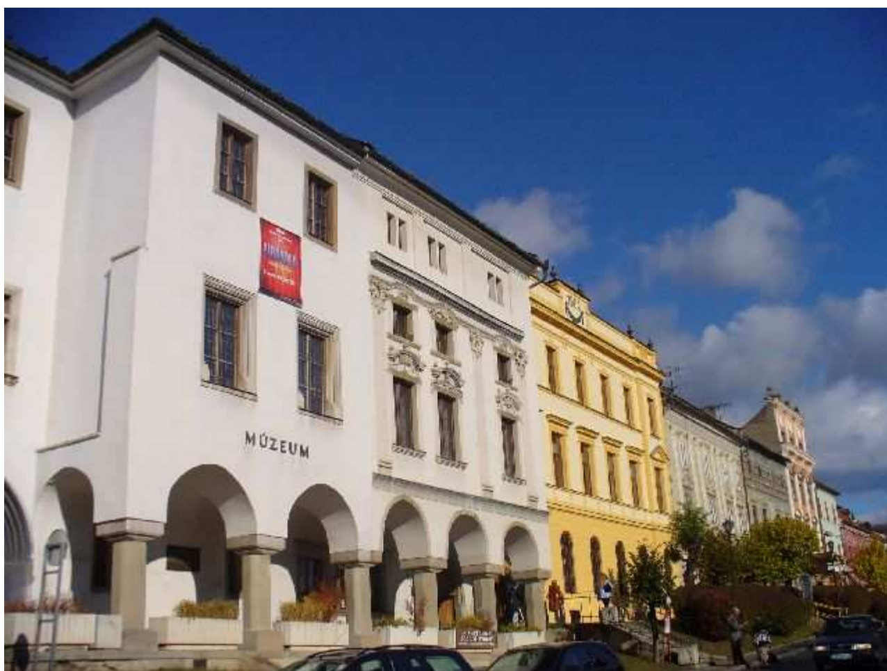
NMP pohľad od JV na JZ časť 2
