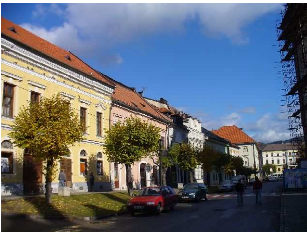
NMP pohľad od JV na SZ časť
