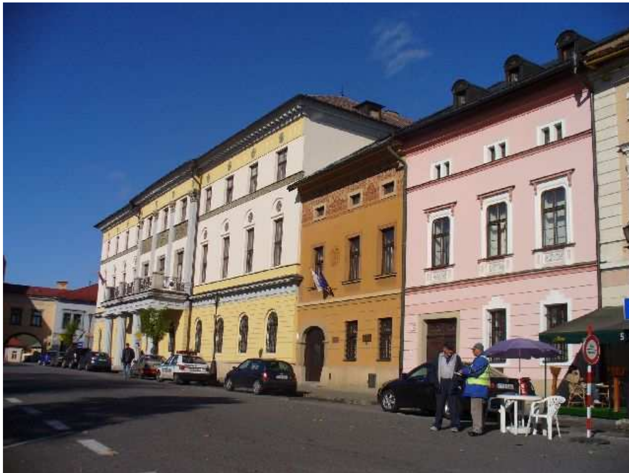
NMP pohľad od JV na S časť 3
