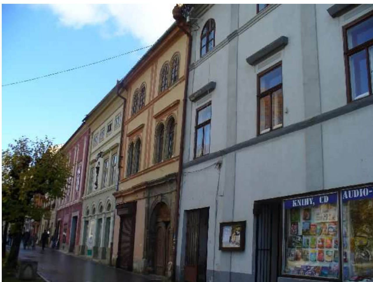
NMP pohľad od Z na strednú časť východnej strany
