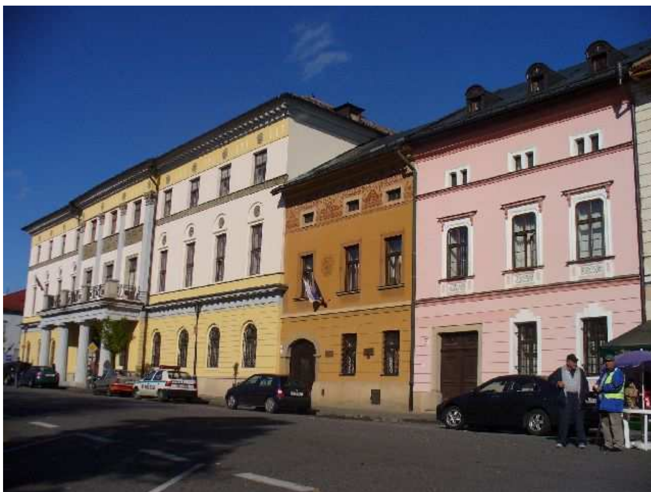
NMP pohľad od JV na S časť 4
