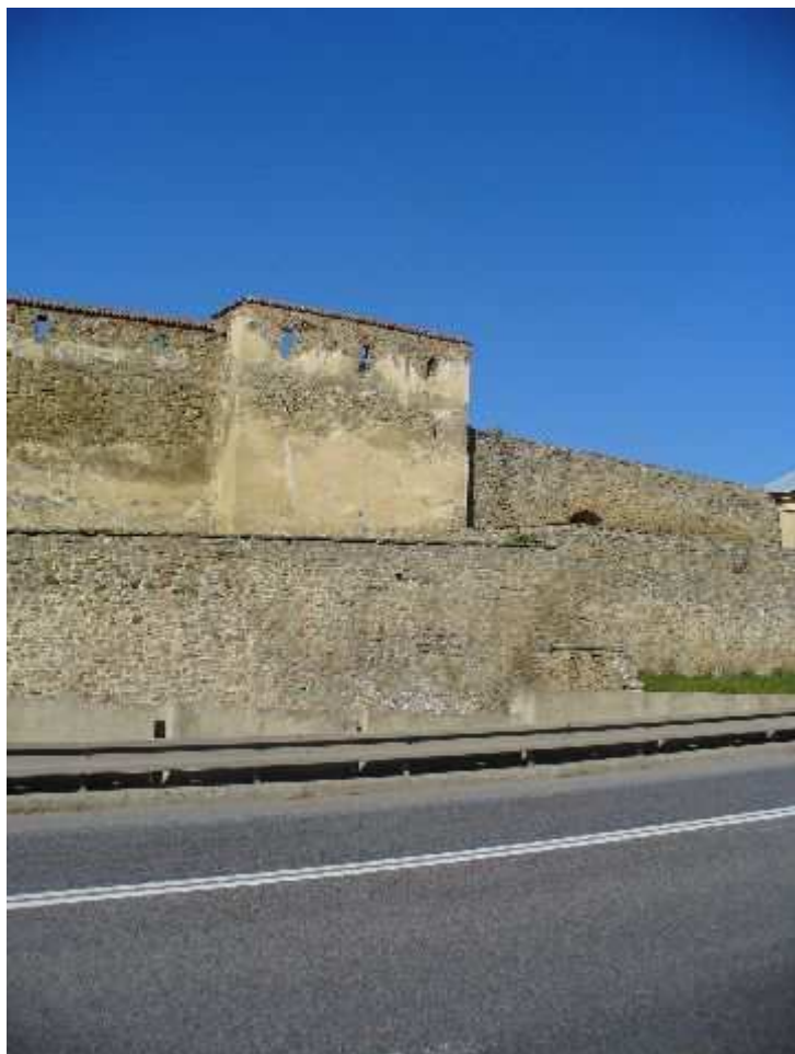
Probstnerova cesta opevnenie V hranolová bašta 2
