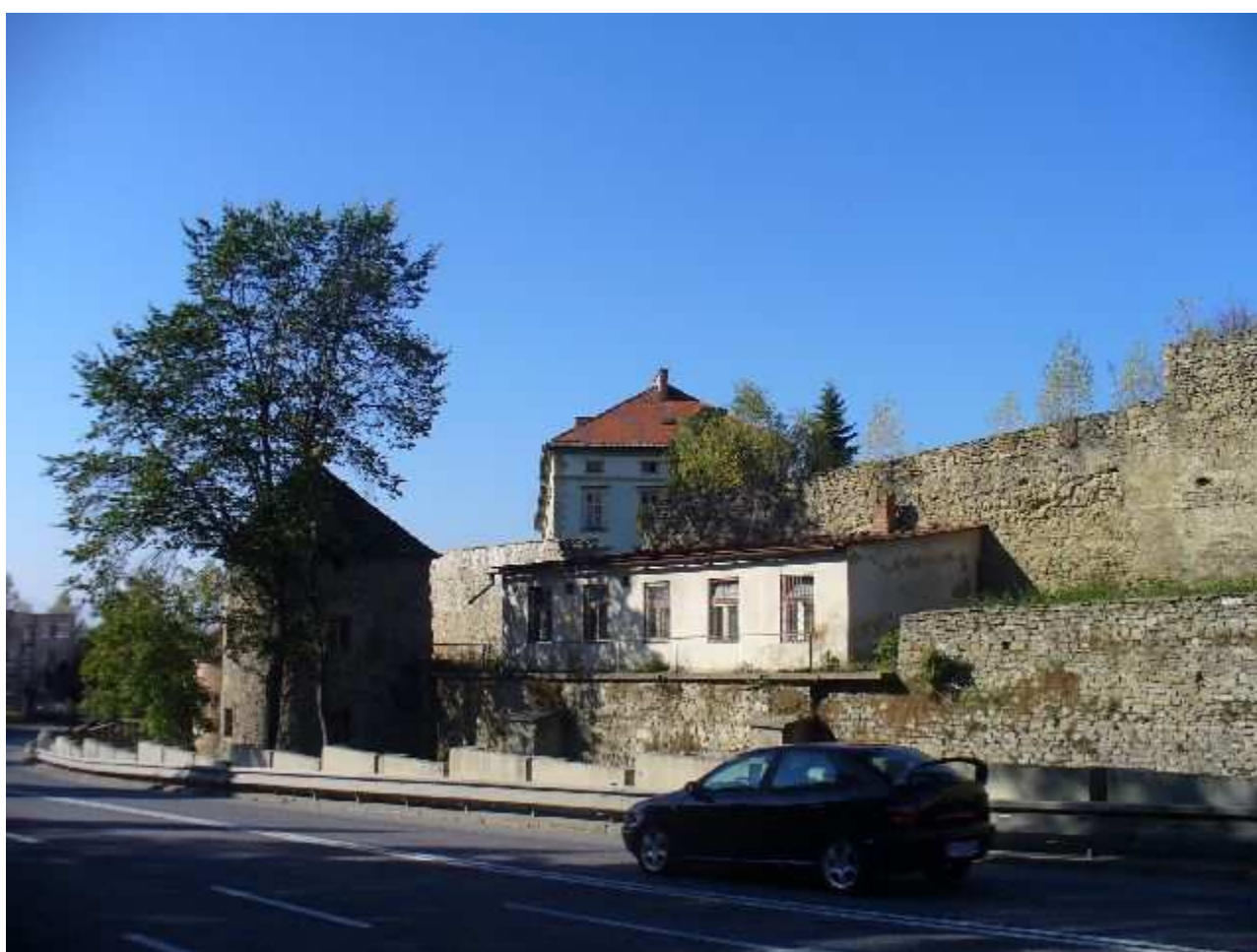
Probstnerova cesta opevnenie JV pohľad od severu
