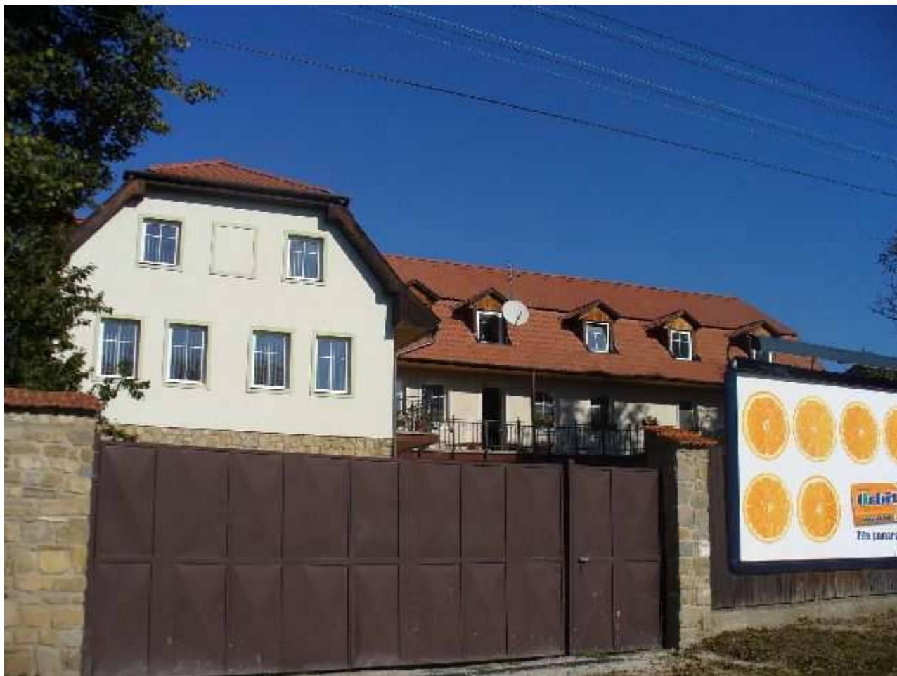
Probstnerova dom severne od č.8
