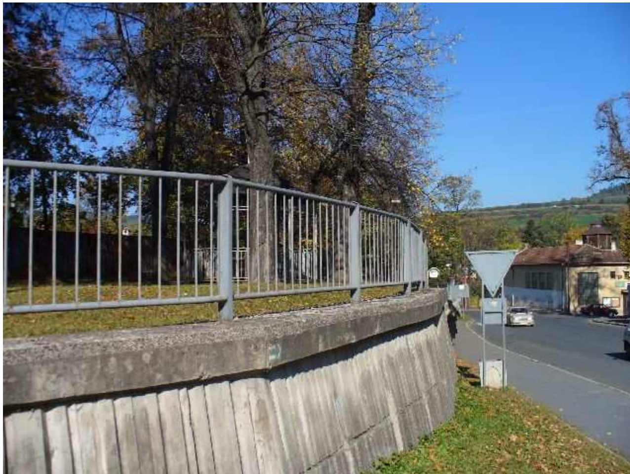
Probstnerova cesta opevnenie SV severne od Košickej brány
