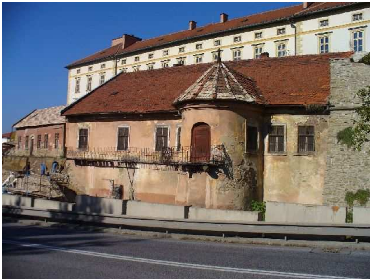
Probstnerova cesta opevnenie mestské JZ s baštou
