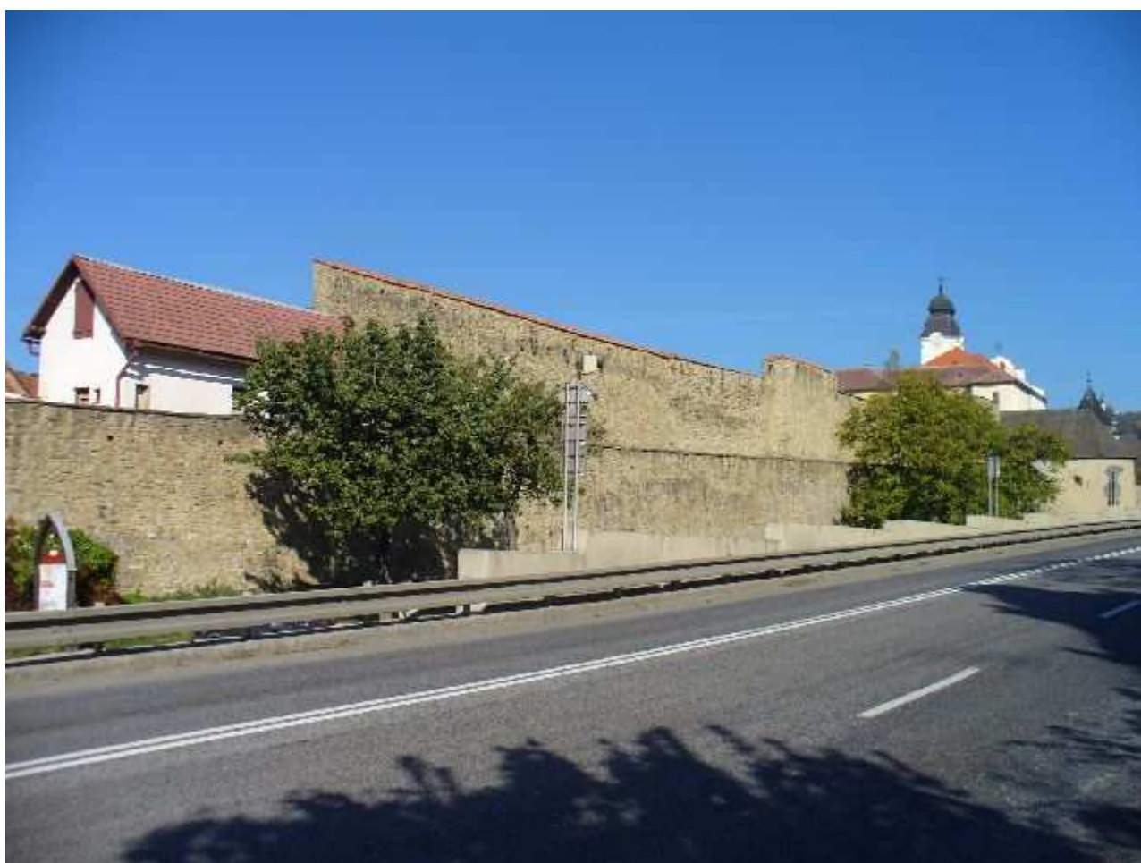
Probstnerova cesta opevnenie V od tlačiarne po Košickú bránu
