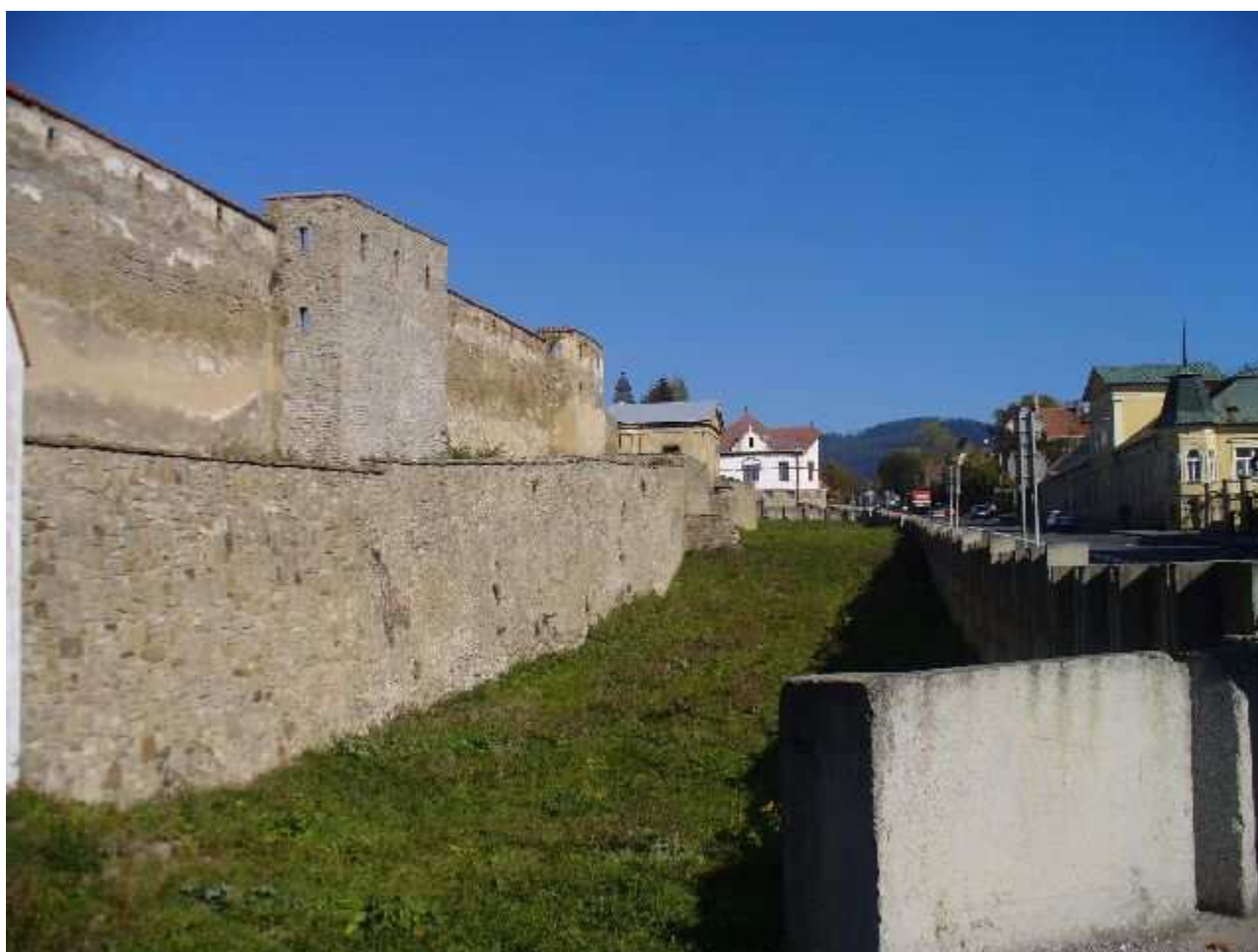
Probstnerova cesta opevnenie priekopa
