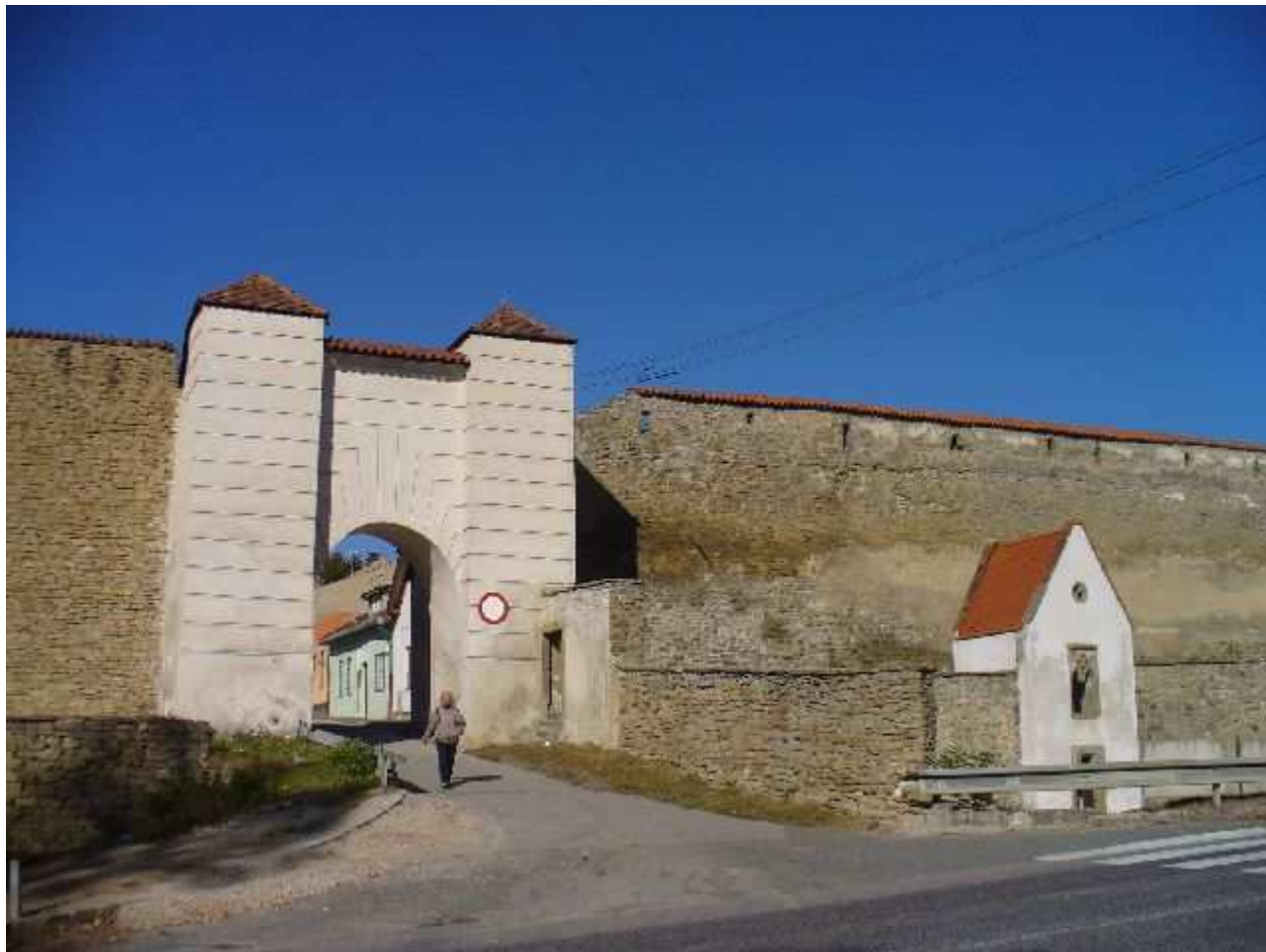
Probstnerova cesta opevnenie JV Menhardská brána od V
