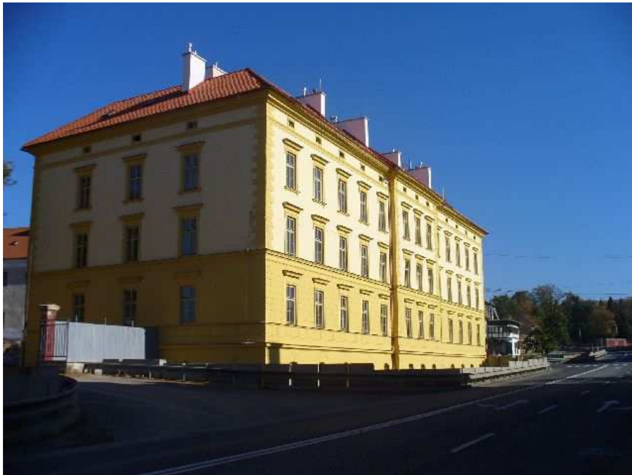
Probstnerova cesta kasárne severný objekt
