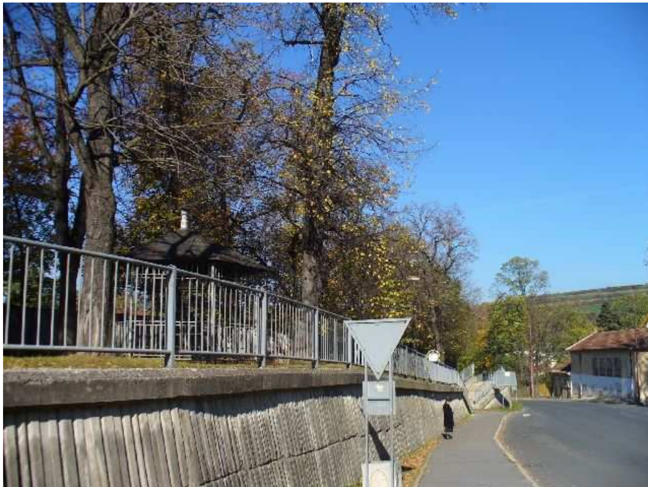
Probstnerova cesta opevnenie SV pohľad od juhu
