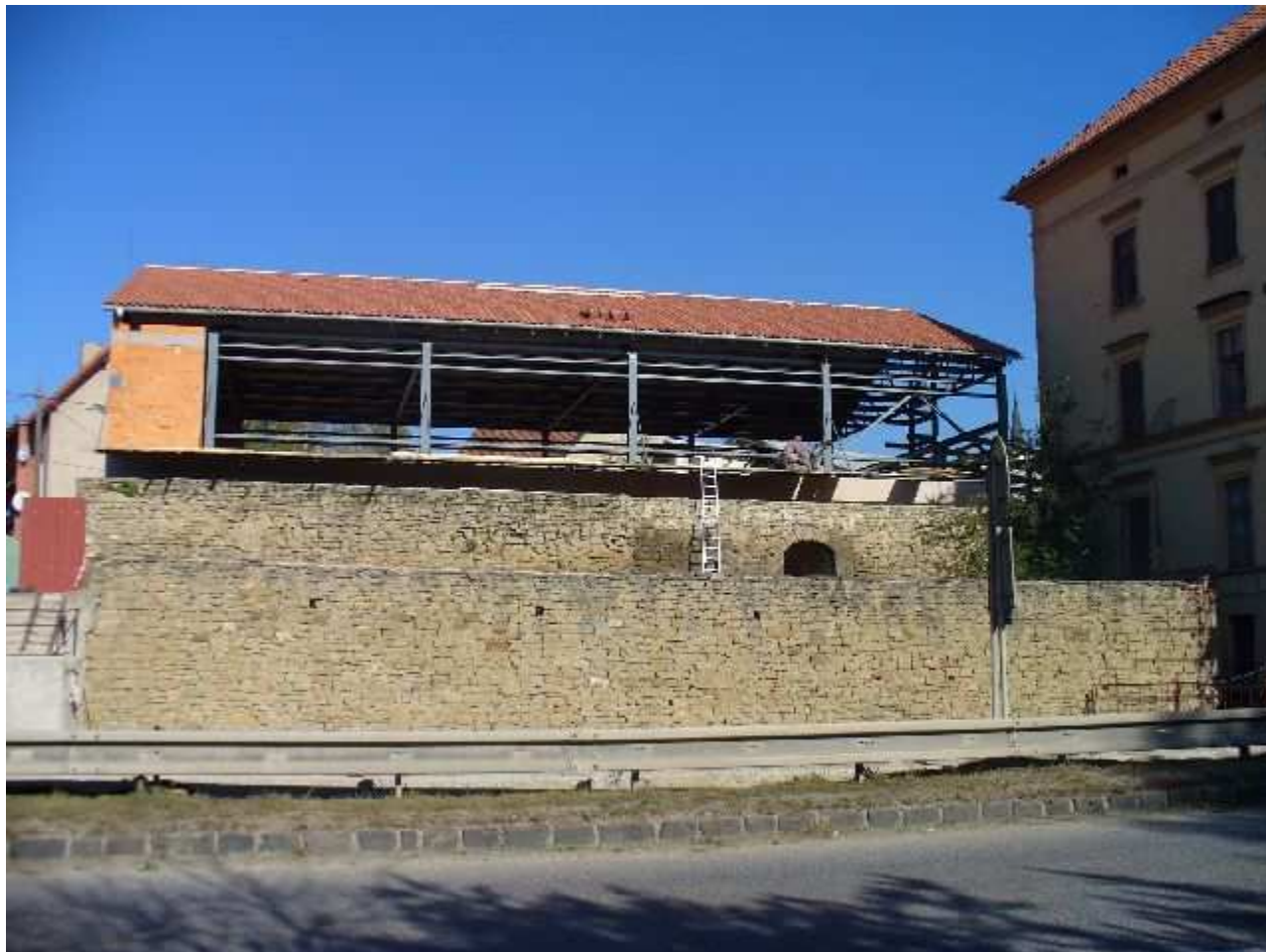
Probstnerova cesta novostavba telocvične
