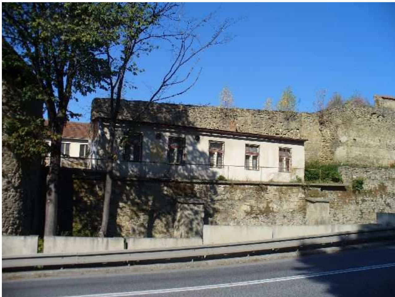
Probstnerova cesta opevnenie JV severne od bašty
