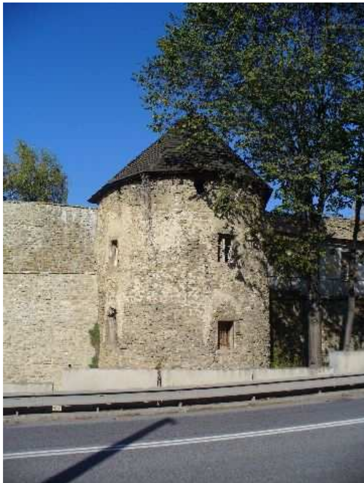
Probstnerova cesta opevnenie JV - bašta
