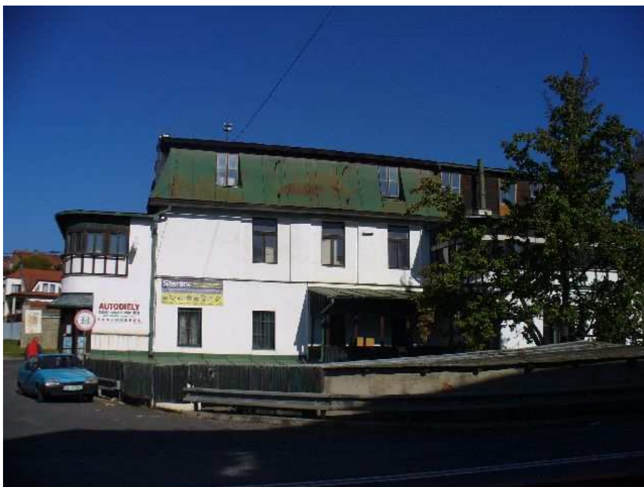
Probstnerova cesta objekt v S nároží s Kasárenskou
