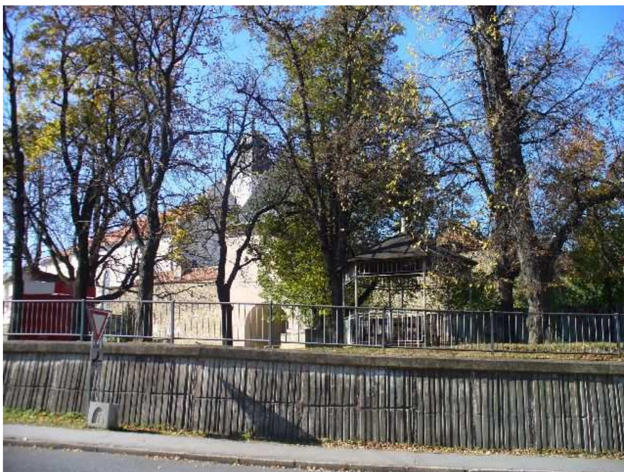
Probstnerova cesta opevnenie SV časť pri Košickej bráne od V
