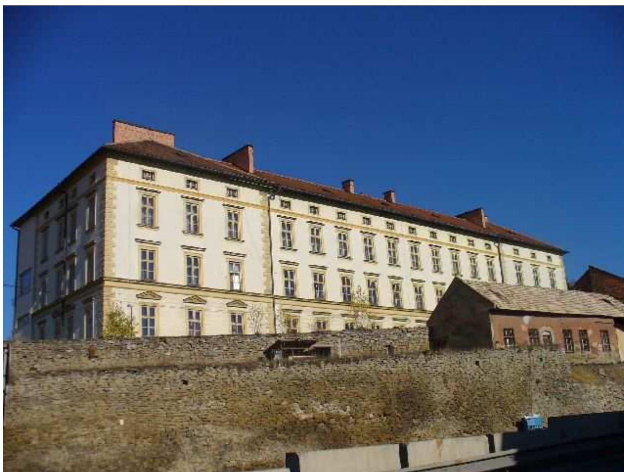
Probstnerova cesta opevnenie JV, škola
