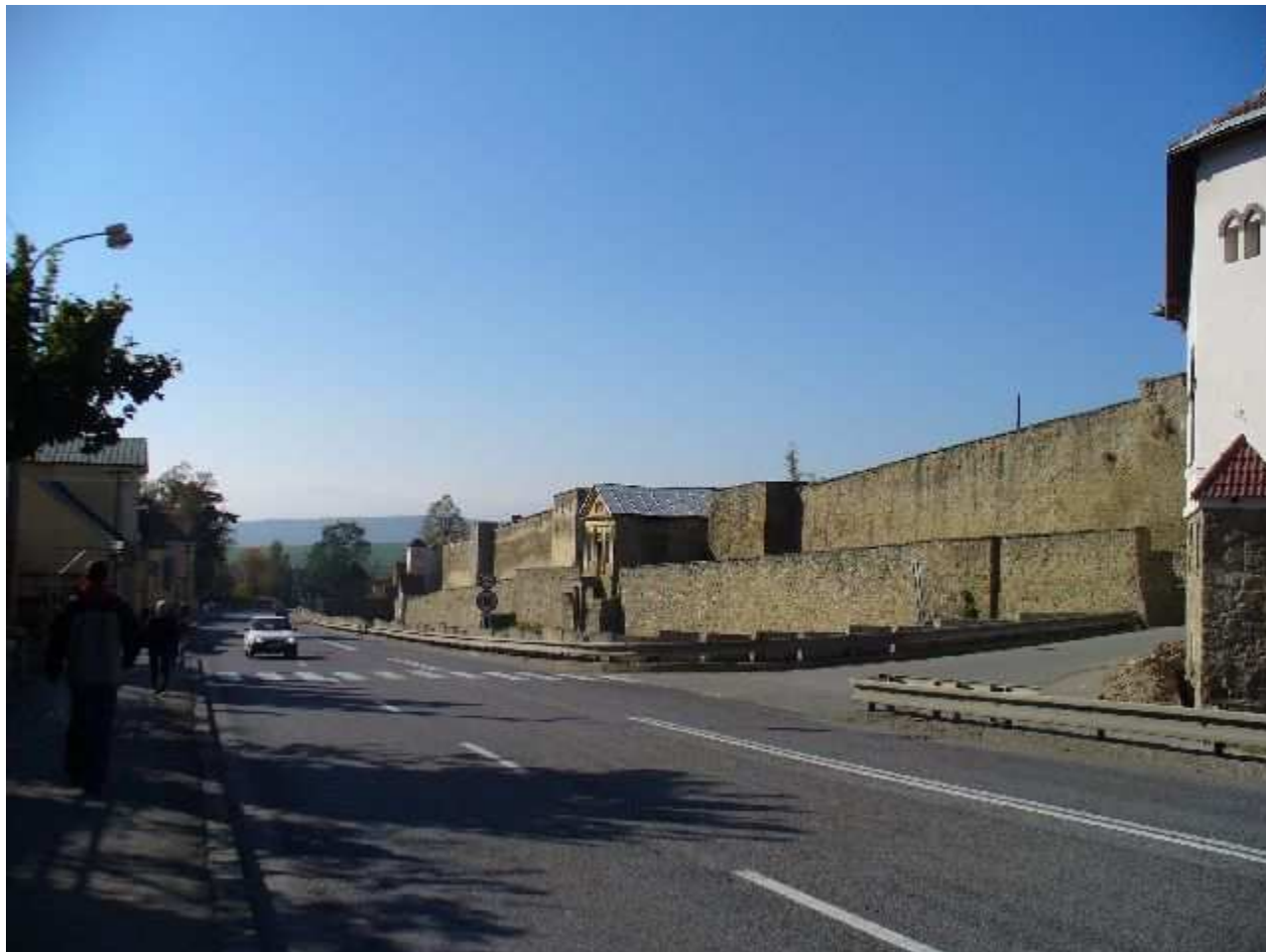
Probstnerova cesta pohľad od S na východnú časť opevnenia
