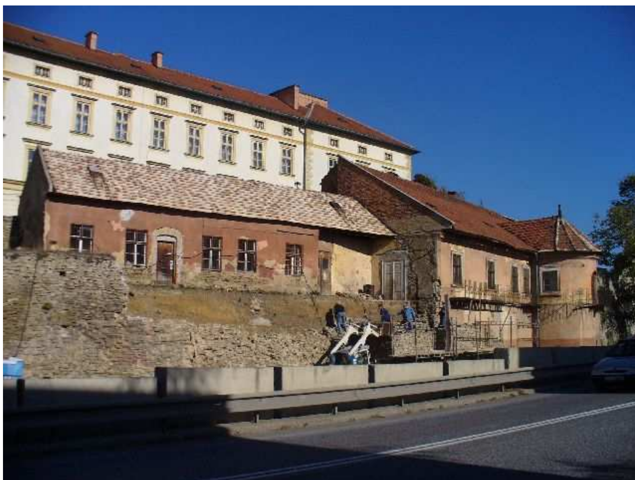
Probstnerova cesta opevnenie mestské JV hradobný múr, priekopa, bašta, v pozadí škola
