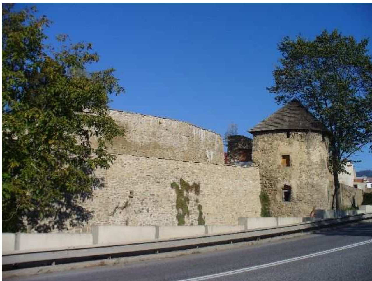
Probstnerova cesta opevnenie JV bašta 2
