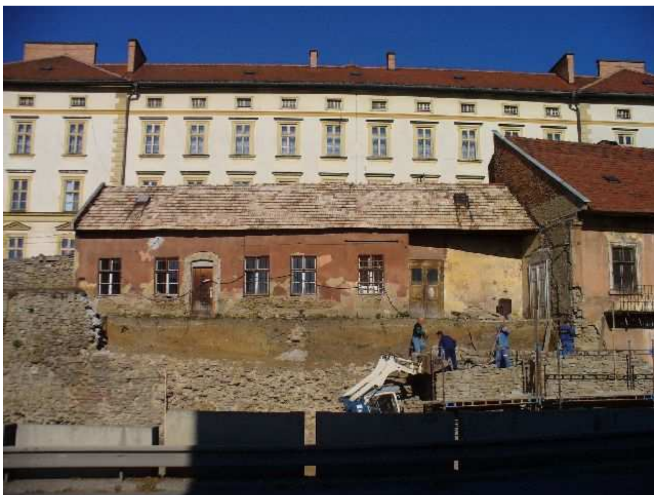
Probstnerova cesta opevnenie mestské JV
