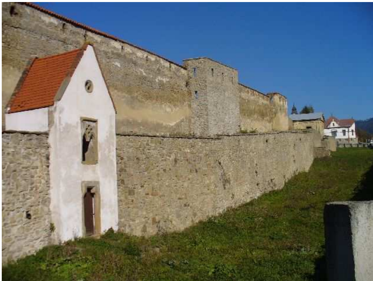
Probstnerova cesta - opevnenie V severne od Menhardskej brány
