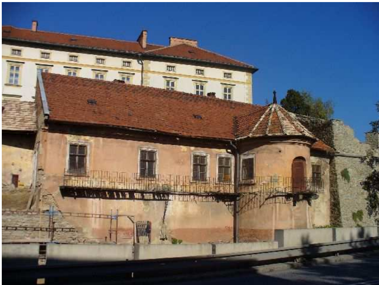
Probstnerova cesta opevnenie mestské JV 2
