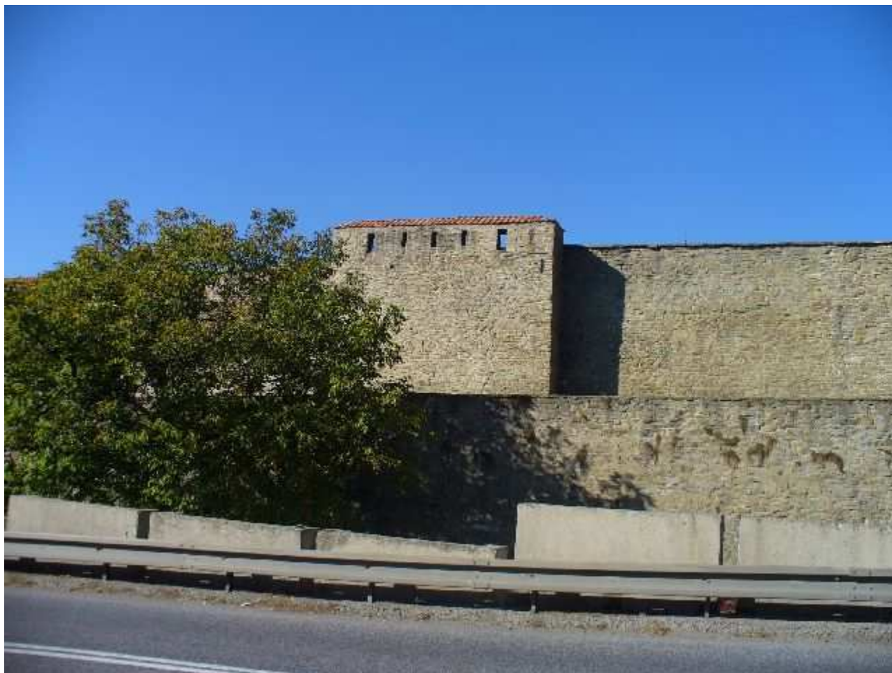
Probstnerova cesta opevnenie V hranolová bašta severne od tlačiarne
