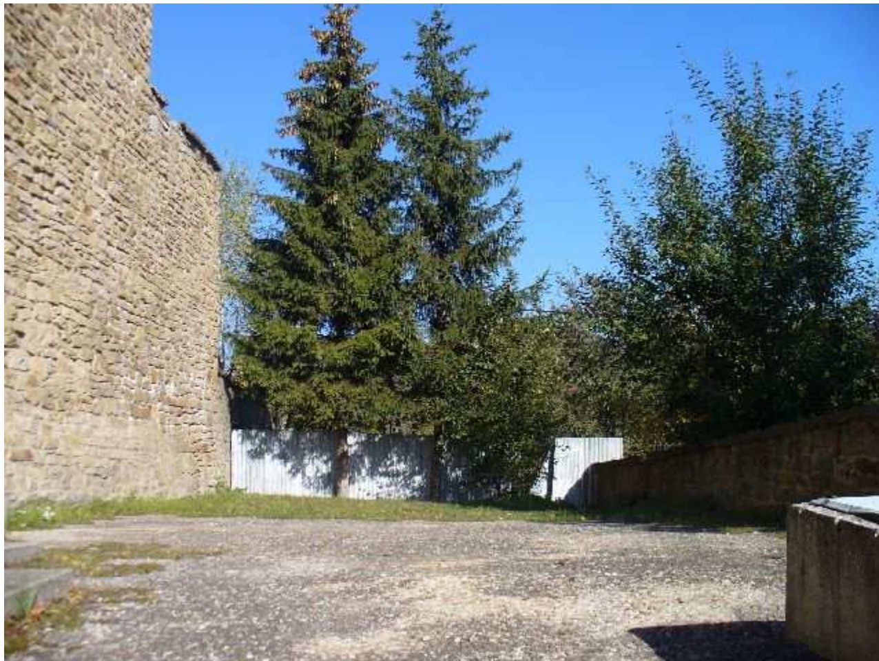
Probstnerova cesta opevnenie pohľad od J pri Košickej bráne
