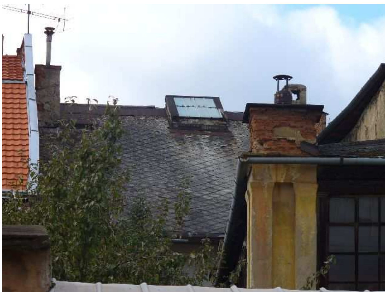
Špitálska - strecha domu Mäsiarska 3
