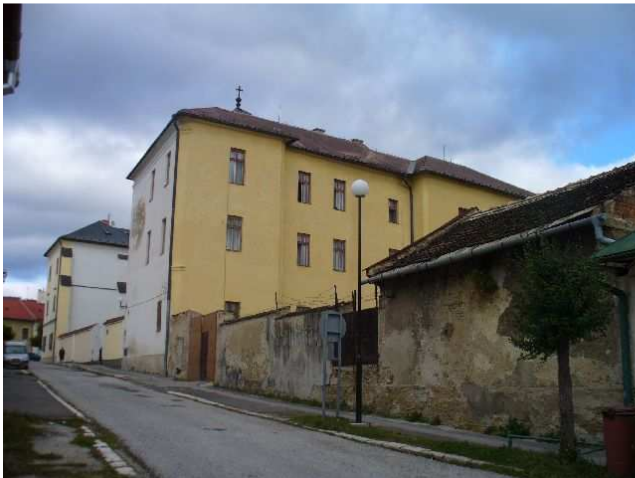
Špitálska - kláštor a jeho oplotenie v SV ukončení ulice
