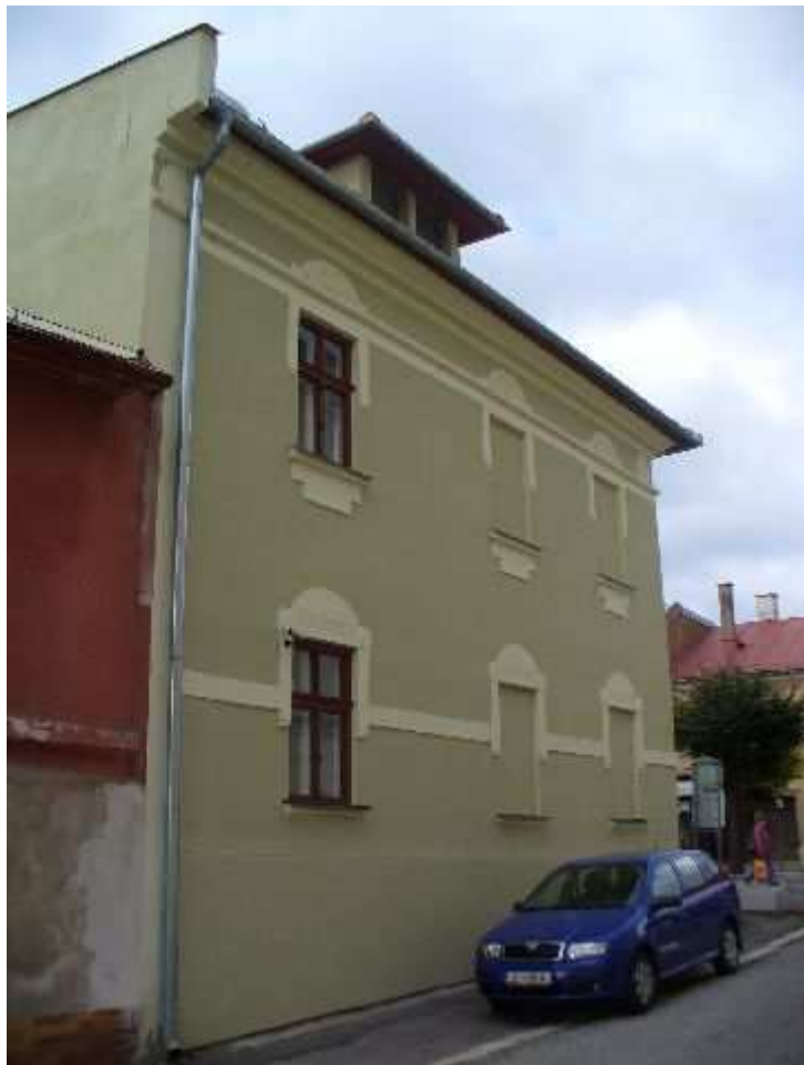
Špitálska fasáda Košická 3 v SZ ukončení ulice
