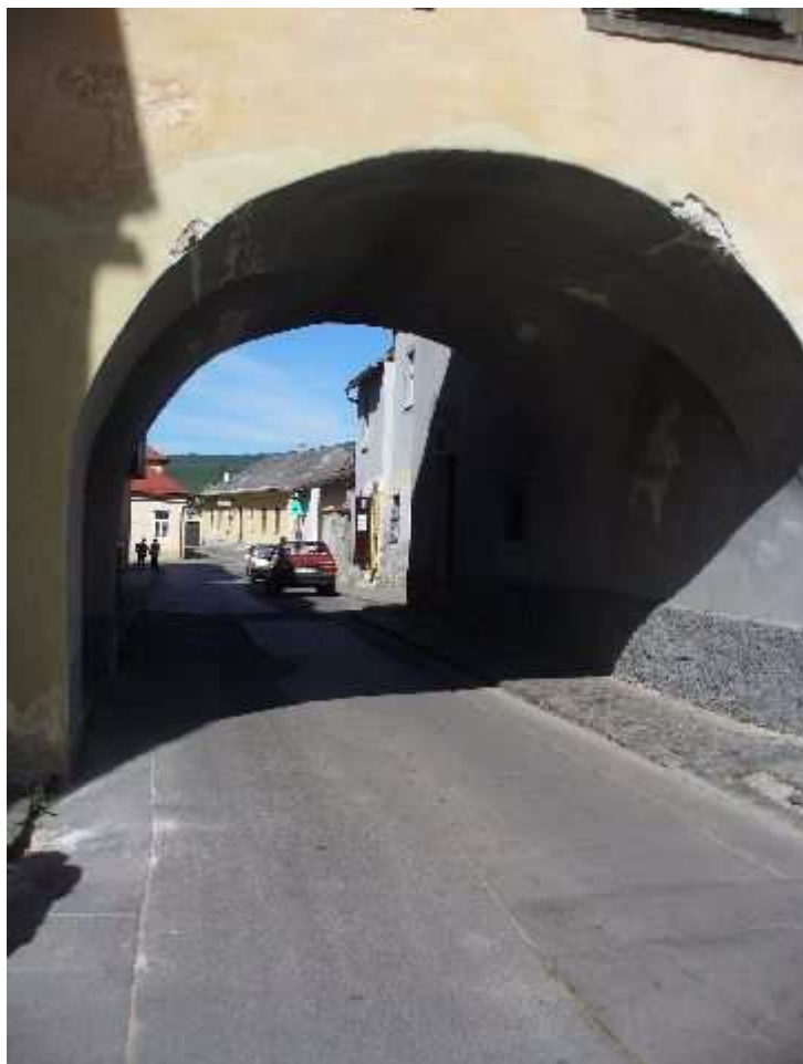
Uhoľná ul. - podchod
