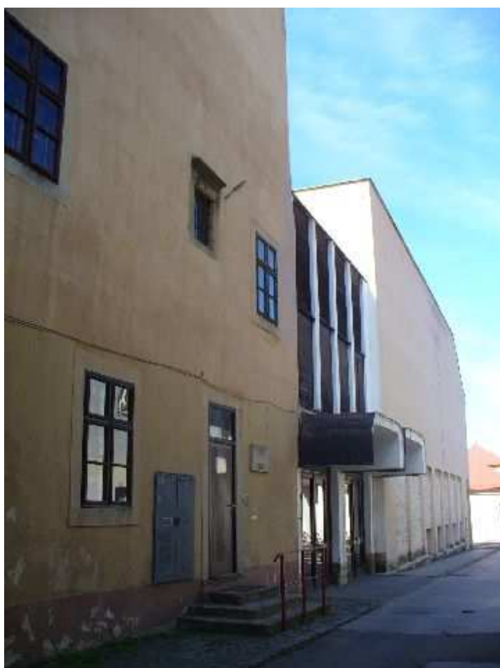
Uhoľná ul. - južná strana
