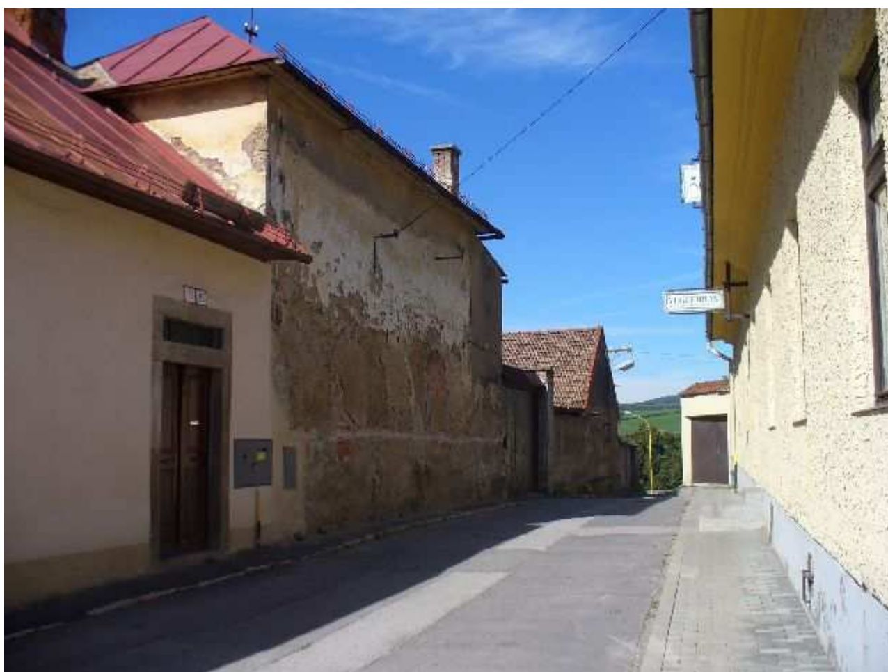
Uhoľná ul. - pohľad od východu na západnú časť
