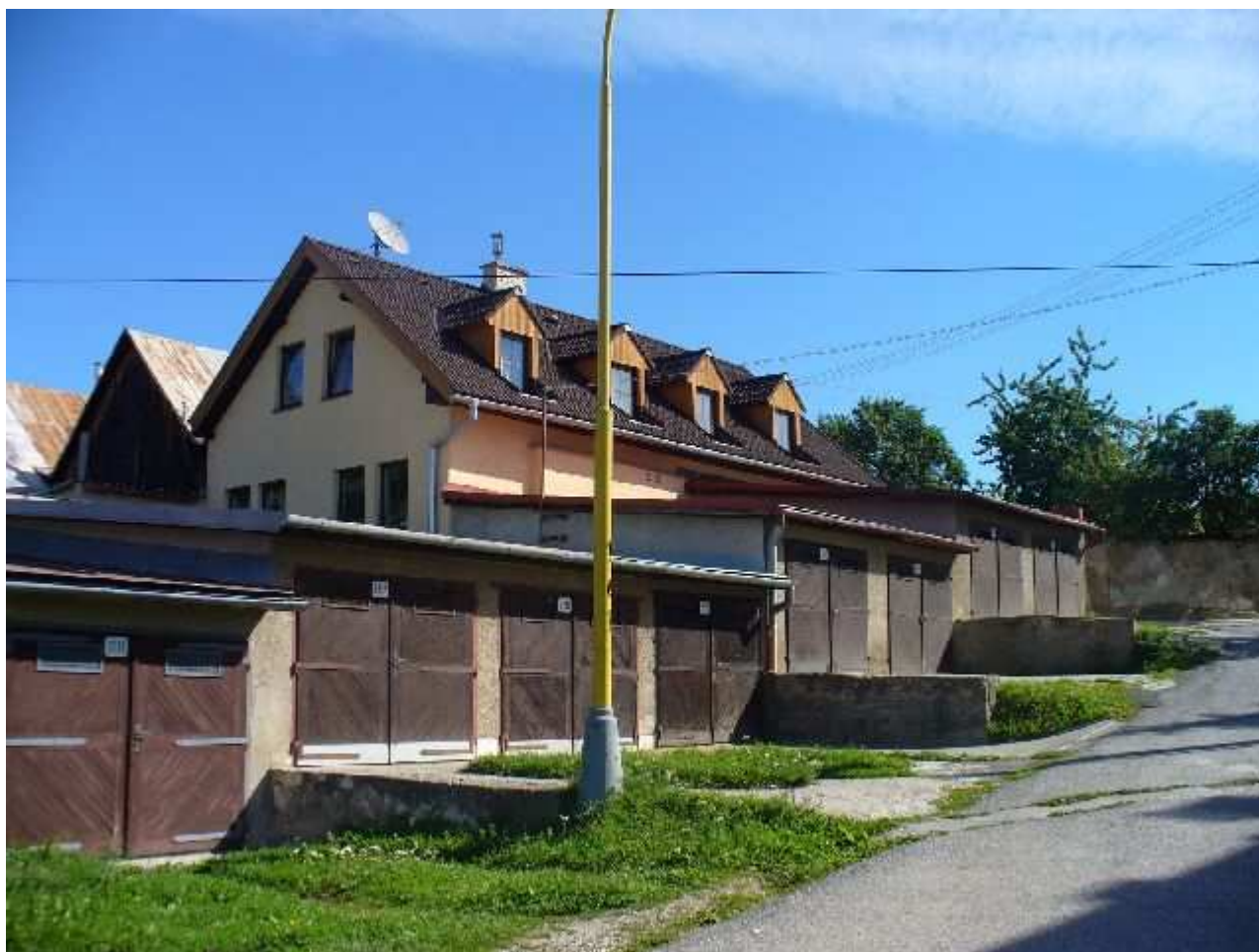
Uhoľná - garáže v ukončení
