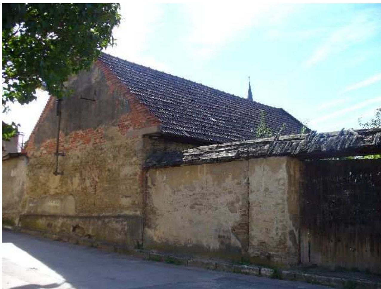
Uhoľná 21 - hosp. stavba a oplotenie
