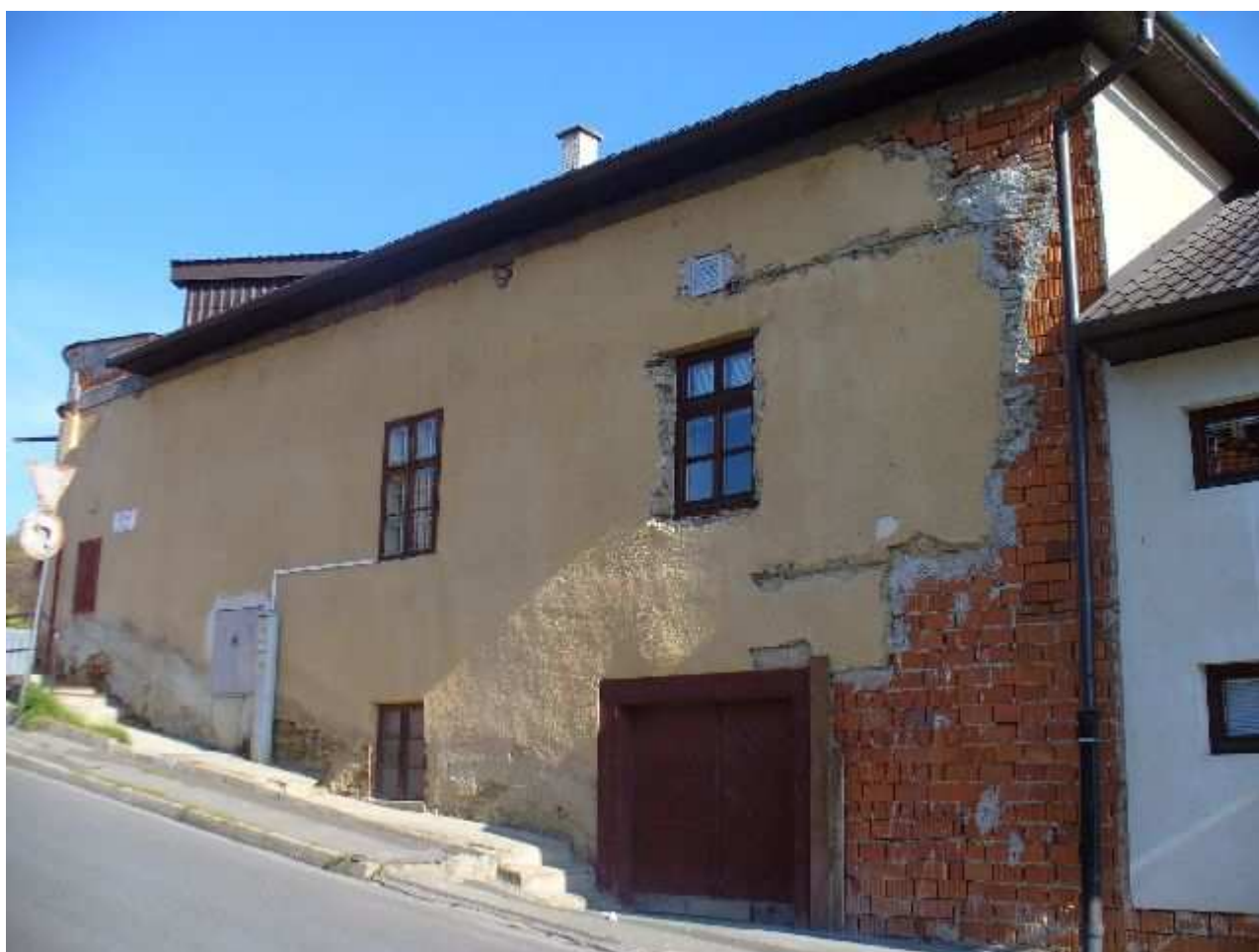
Žiacka - bočná fasáda domu Vysoká 23
