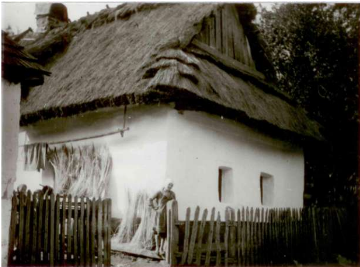
Fotografie staršieho, dnes už nezachovaného, typu ľudového domu z 2. pol. 19. stor., s jednoduchými nezdobenými fasádami a so slamenou strechou.
