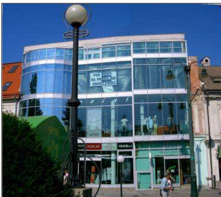
77 - Novostavba na mieste meštianskych domov č. 107b – 109 – súčasný stav
