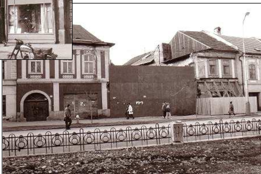
76 - Situácia po zrútení domu č. 107b – stav z roku 1994
