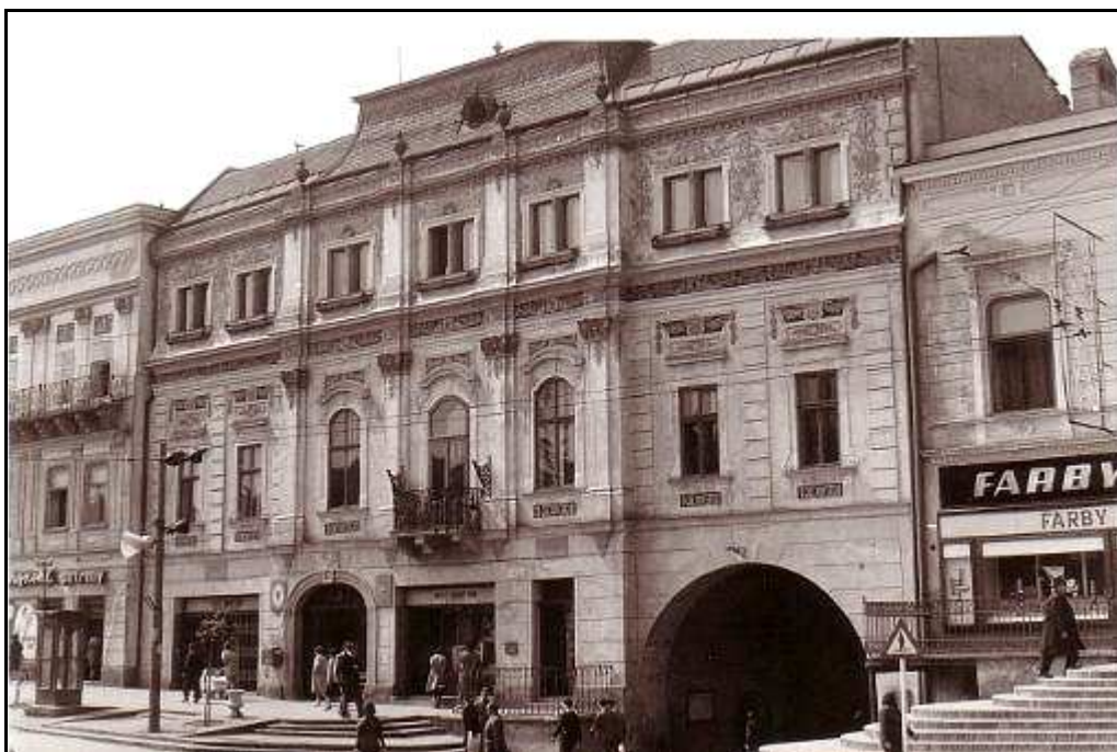
64 - Radnica na Hlavnej ulici č. 73 – stav z roku 1994
