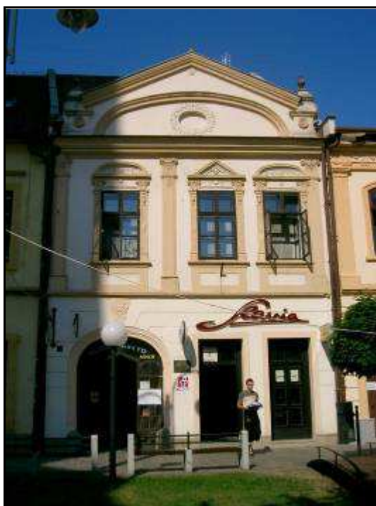
74 - Meštiansky dom na Hlavnej ulici č. 85, stav z roku 1994
