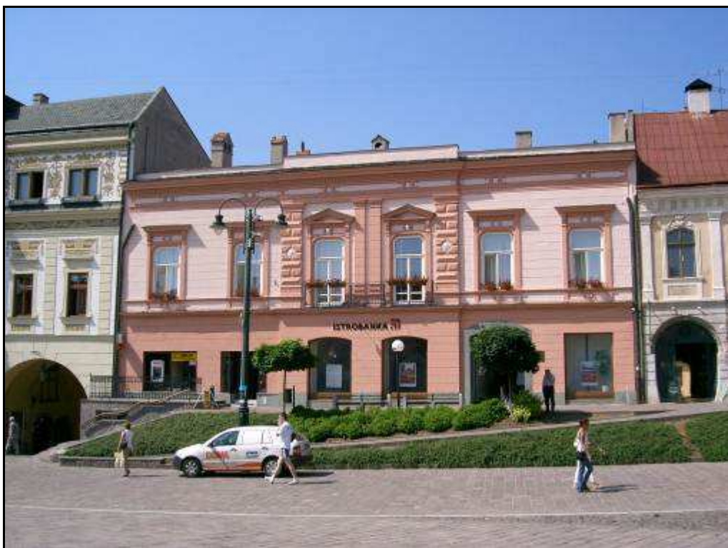
52 - Hlavná ul. – meštiansky dom č. 75 – súčasný stav
