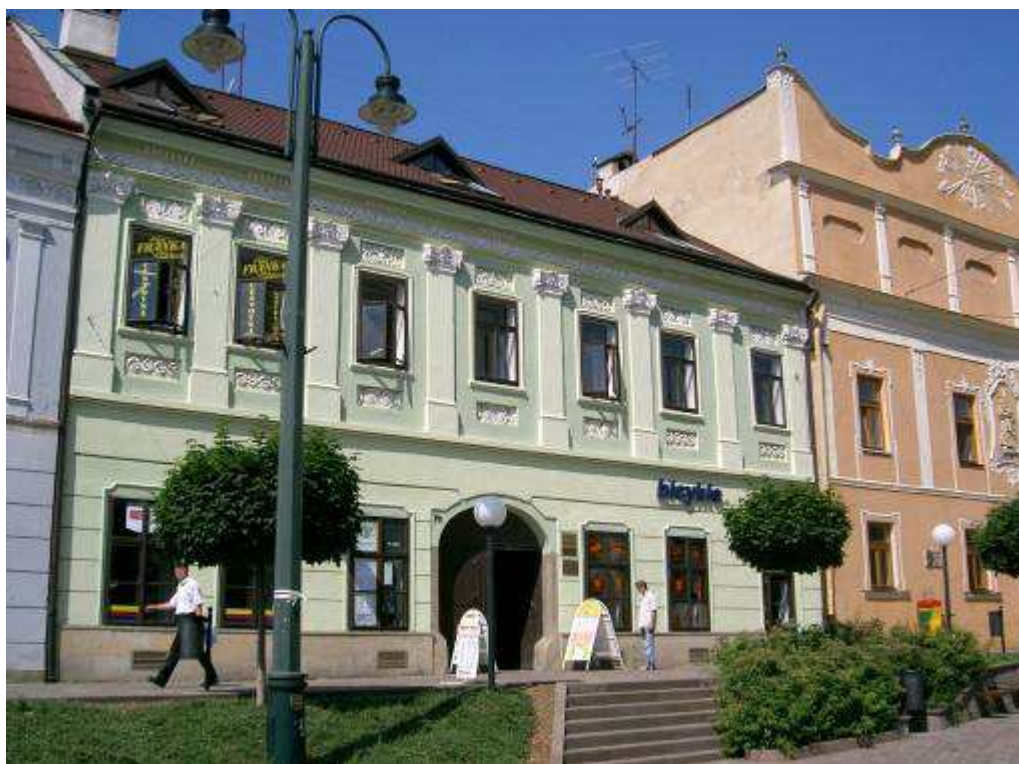
53 - Hlavná ul. – meštiansky dom č. 79 – súčasný stav
