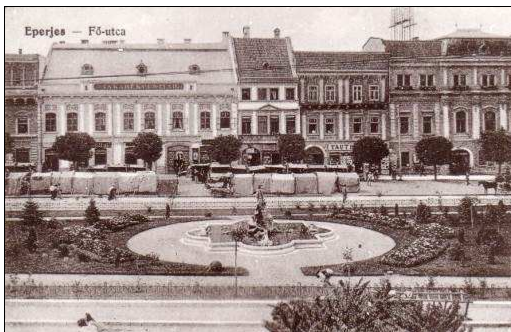
21 - Neptúnova fontána v secesnom parčíku a časť meštianskych domov v západnom uličnom fronte – 20-te roky 20. storočia
