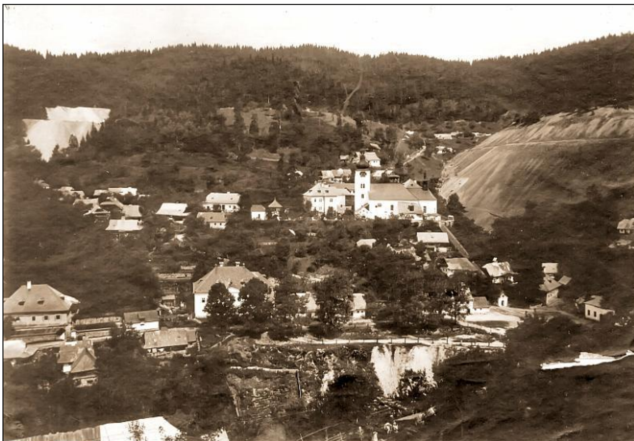
HF3. Pohľad z južnej strany smerom na námestie, v popredí pod budovou Obecného úradu halda prekrývajúca usadzovacie nádrže, v pozadí s r. k. kostol Premenenia Pána, vpravo halda Maximilián. Fotografia zo začiatku 20. storočia. Zbierkový fond Stredoslovenského múzea, ev. č. 12F.
