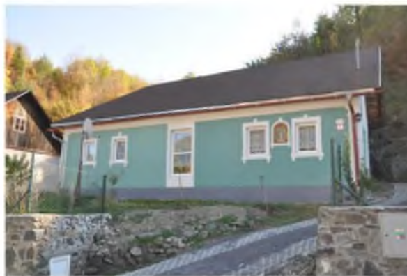
Nevhodné materiálové riešenie a nevhodná farebnosť objektu
