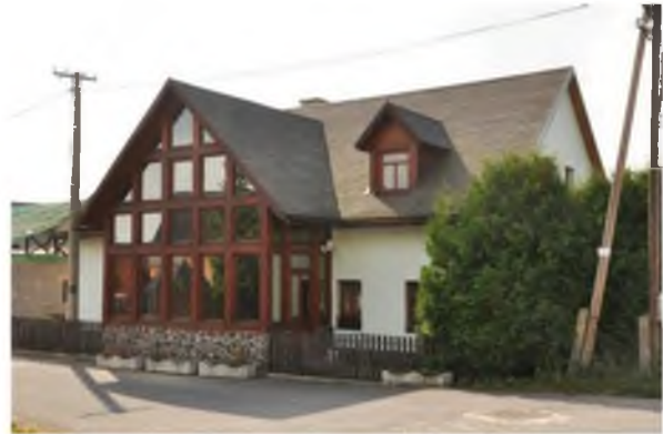
Objekt s neprimeraným hmotovým a architektonickým riešením verandy a nevhodným materiálovým riešením
