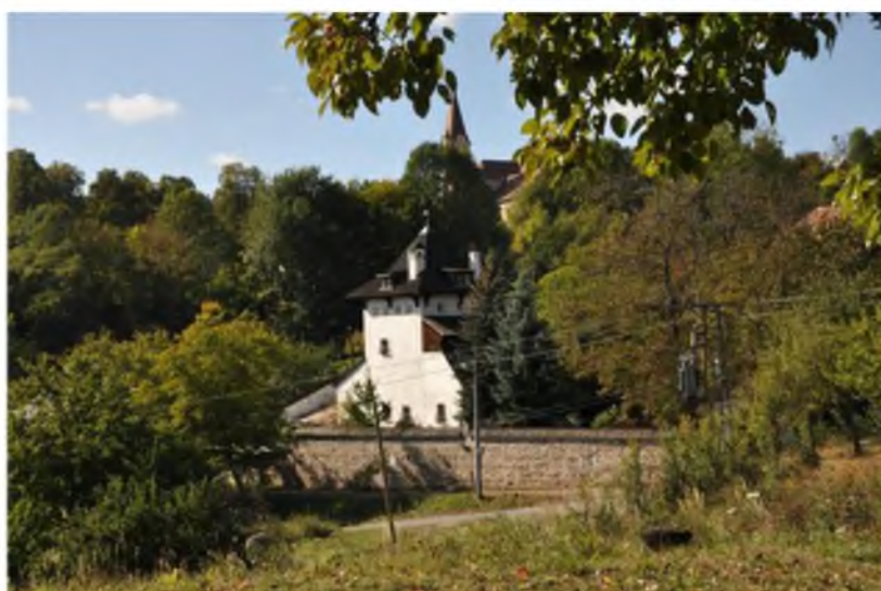
Vnútoraná brána opevnenia, parc. č. 60.
