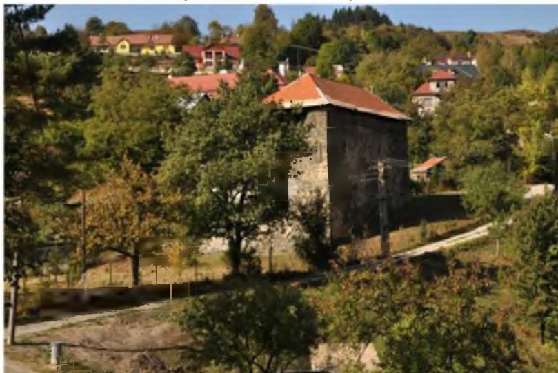
Strojovňa šachty Špitáľ, parc. č. 1466/1.
