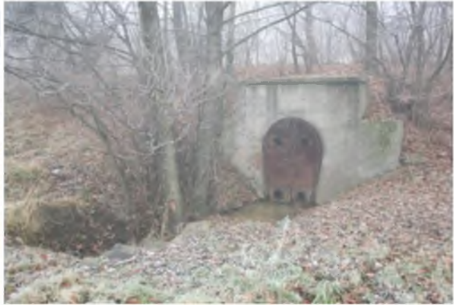
Ústie štôľne Colorado – Stankaiho vodná štôľňa
