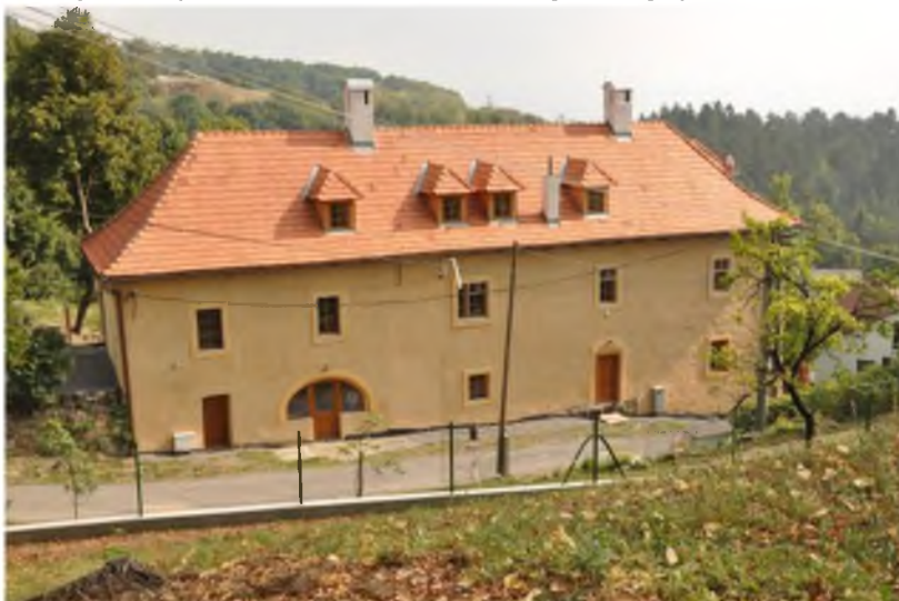
Budova banskej správy pri šachte Leopold, parc. č. 82/4.
