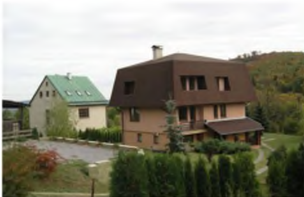
Nevhodný tvar strechy a materiálové riešenie stavby
