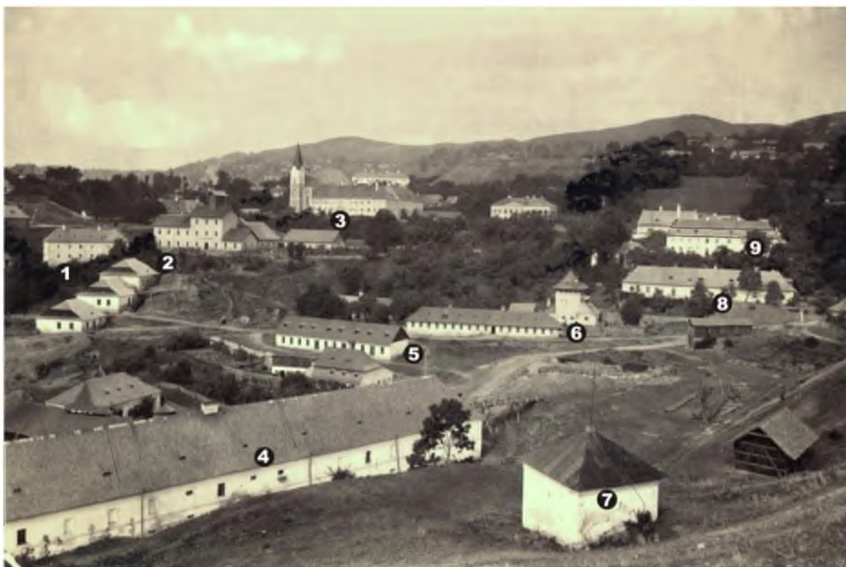
Obr. 2 - Pohľad na zástavbu pod kostolom a kláštorom: 1 – správna budova banského závodu Leopold, 2 – Leopold šachta a stupy, 3 – kostol a kláštor, 4, 5, 8 – stupy, 6 – vnútorná brána opevnenia, 9 – objekt zememeračstva
