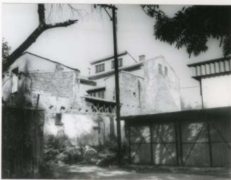
82. Pohľad z ulice Na priekope smerom k trhovisku. Príklady vytvorené asanáciou niektorých častí bloku len zvýšili chaos v rôznorodnej zástavbe. Pre novú zástavbu sú podmienky určené v rámci R 27/Z
