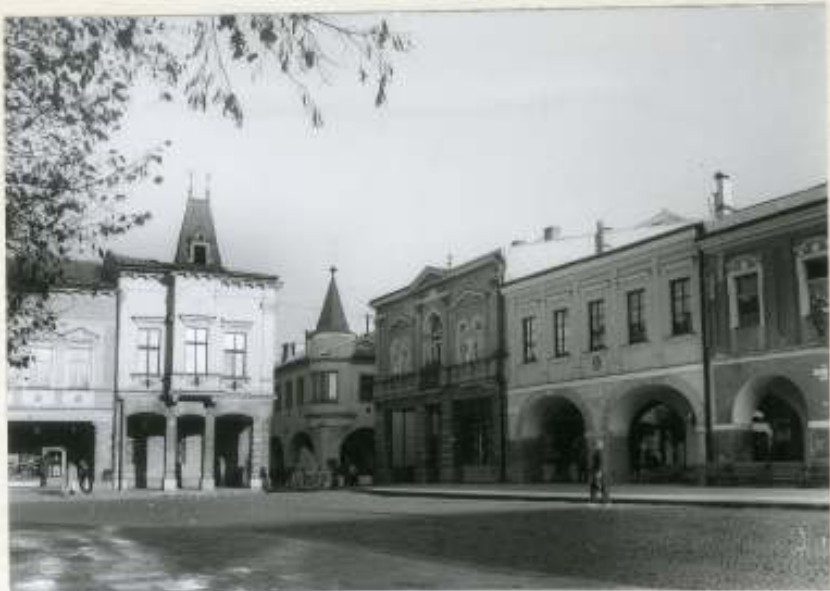
23. Časť priestoru nám. Dukly. Obnovené objekty radnica č.l. a obj.č.31. V pozadí objekt s vežičkou obnovený pre účely SZM. Záber prezentuje vyváženosť architektúr /až na riešenie striech/ v priestore, kde nebola realizovaná žiadna neprimeraná dostavba. foto Jurík 1988
