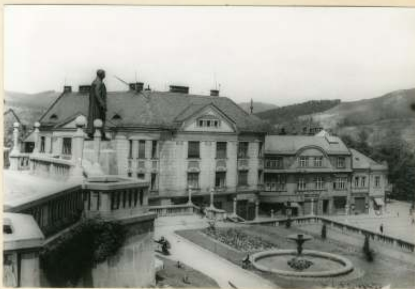
18. Detailný záber na balustrádu pred úpravou koncom 30-tych rokov nášho storočia. Vpravo dole zástavba dnes nahradená OD Priorom. Archív ŠUPS č.neg. 62 844
