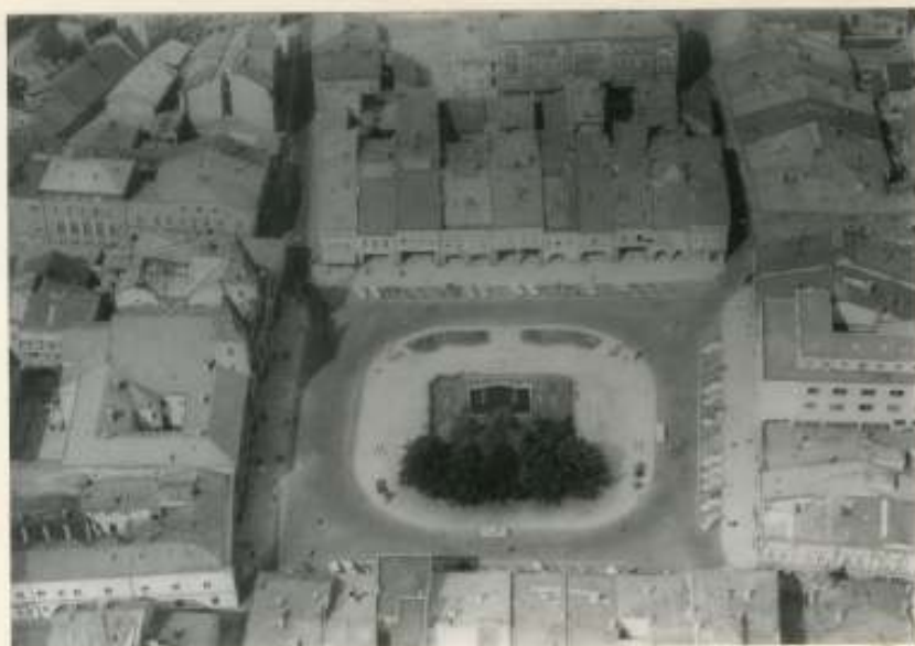
15. Letecký pohľad na námestie Dukla s charakteristickou skladbou objektov drobnej meštianskej architektúry a vidlicovite rozvetvenými ulicami v rohoch námestia. Archív ŠÚPS č.neg. 71 806
