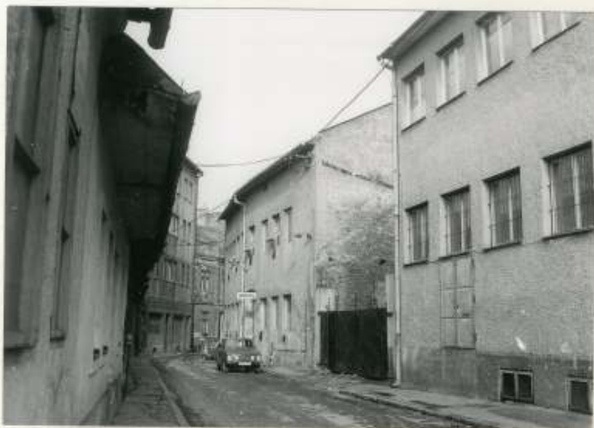
48. Ulica Dolný val. Vľavo časť R 22/P vpravo v prelúke R 25/R. V pozadí dom č.32, ktorý svojou výškou nepriaznivo presahuje pomerne vyrovnané zosonovanie ostatných objektov. foto Jurík 1988
