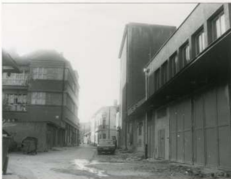
50. Makovického ulica, pohľad do ulice Horný val. Charakteristika ako záber č. 49. Vpravo nevhodná novostavba bývalej pekárne. Pri regenerácii MPR je žiadúca zmena funkčnej náplne a architektonizovanie objektu v súlade s okolitou zástavbou. foto Jurík 1988
