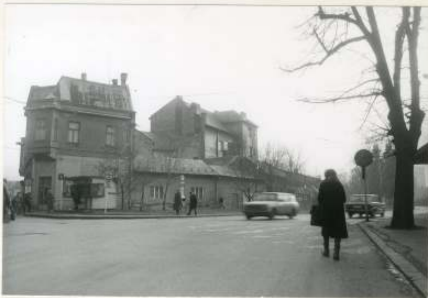
47. Pohľad z Kuzmányho ulice smerom k bloku P. Prízemnú zástavbu v tejto polohe MPR odporúčame v rámci R 22/P prestavať, pričom k domu č.15 na ulici Na priekope je možný výškový prechod od prízemnej úrovne ostatnej časti územia do jednoposchodovej s podkrovím. foto Jurík 1988
