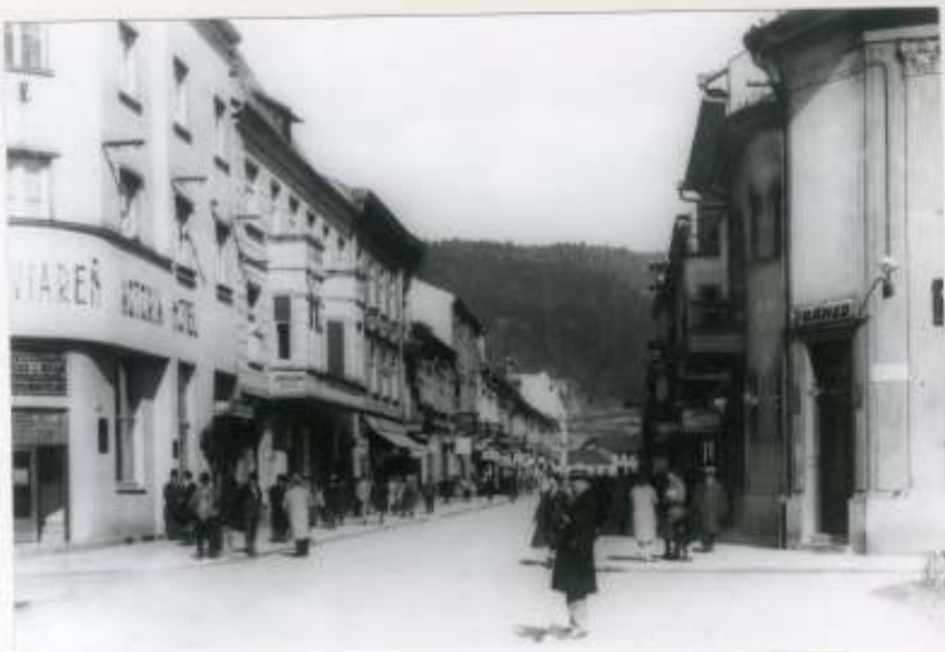
85. Ulica SNP pohľad od MPR ku stanici ČSD. Foto z 30-tych rokov. Archív SUPS č.neg. 23 930
