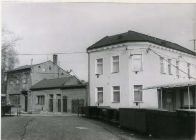
63. Lehotakého ulica, nárožie s Horným valom. Objekt bufetu s garážou tvorí R 11/P - rezervnú plochu. Nová zástavba na nej by mala výškovo siahť po korunné rímse okolitých objektov. foto Jurík 1988
