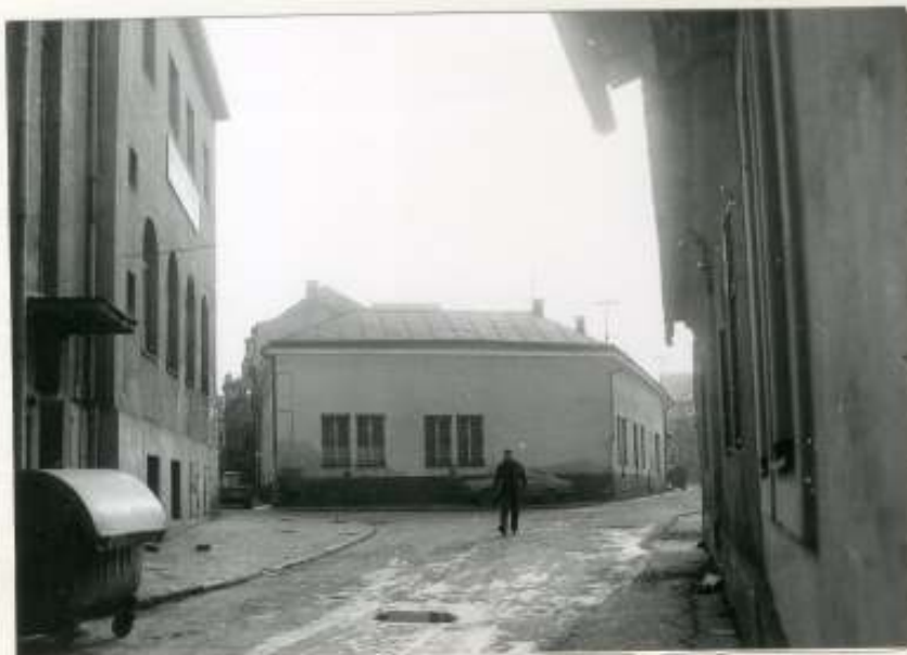
56. Pohľad na nárožie bloku E z Dolného valu. Stojaci objekt si vyžaduje úpravu fasád a preriešenie strechy - v nadväznosti na adekvátne využitie. foto Jurík 1988
