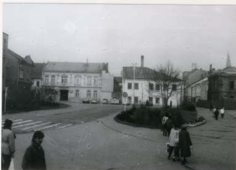
37. Nástup do MPR cez ulicu Na bráne od Leninovho nám. Cezúru medzi objektami č.22 a 24 odporúčame doplniť novostavbou s využitým podkrovím. Priestor vstupu do MPR je nutné architektonizovať a doplniť vhodnými prvkami mestnej malej architektúry. foto Jurík 1987
