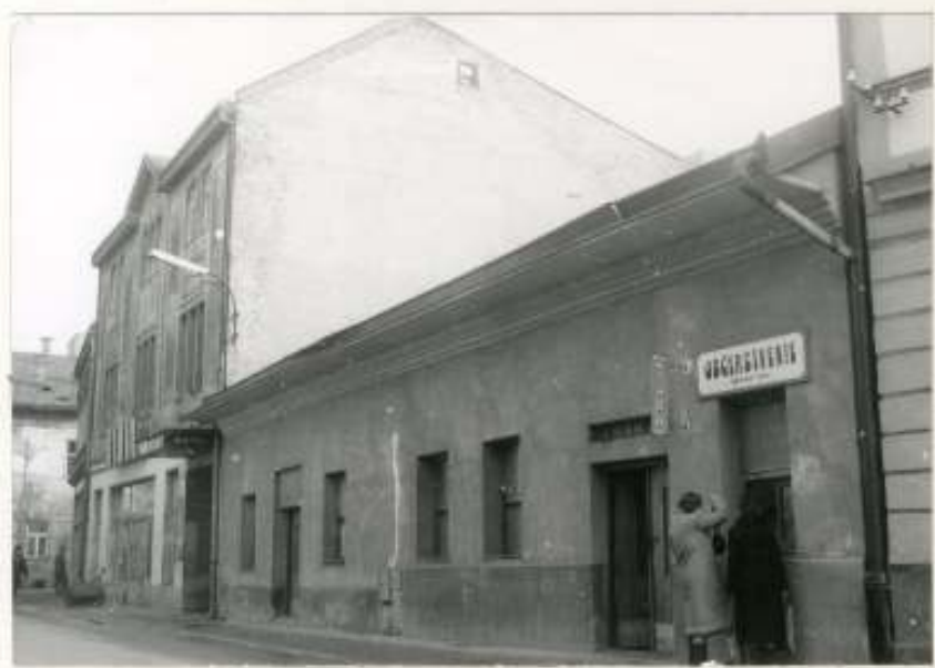
68. Pohľad na dom č.5 na Dimitrovovej ul., ktorý je potrebné výškovo vyrovnat voči susedným objektom a architektonizovať jeho parter, rezervná plocha R 12/P. foto Jurík 1987
