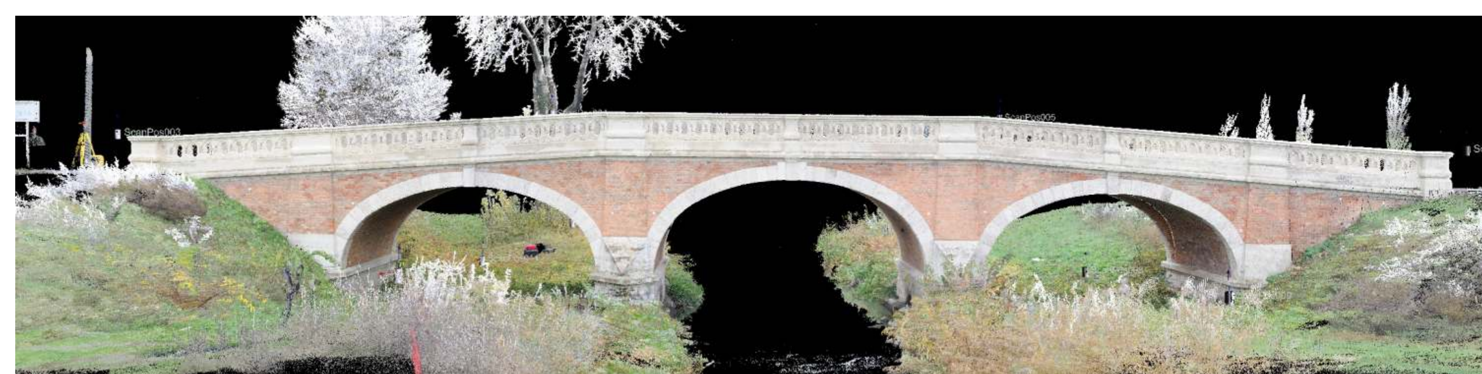
Figure f. Kráľová pri Senci, baroque bridge, pointcloud
