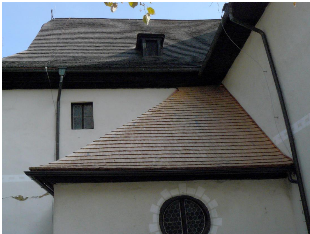
Obr. 4.1. Nová strešná krytina (zatiaľ bez náteru) na strieške severozápadného rohu
