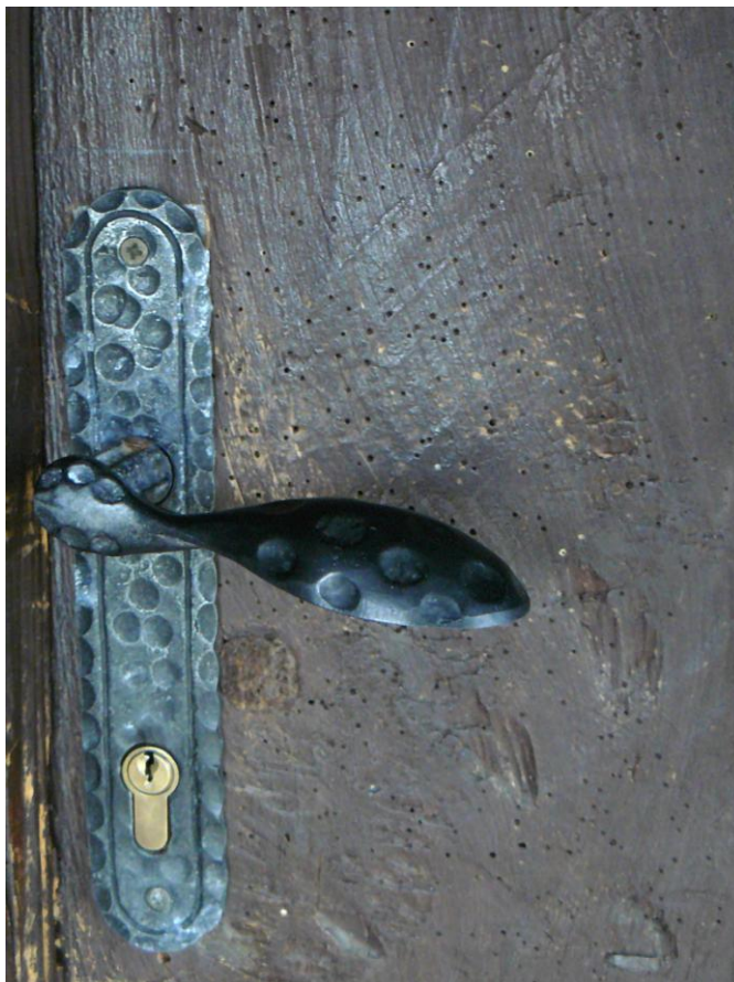
Obr. 2.2. Rozsiahly výskyt výletových otvorov drevokazného hmyzu v okolí kľučky vstupných dverí
