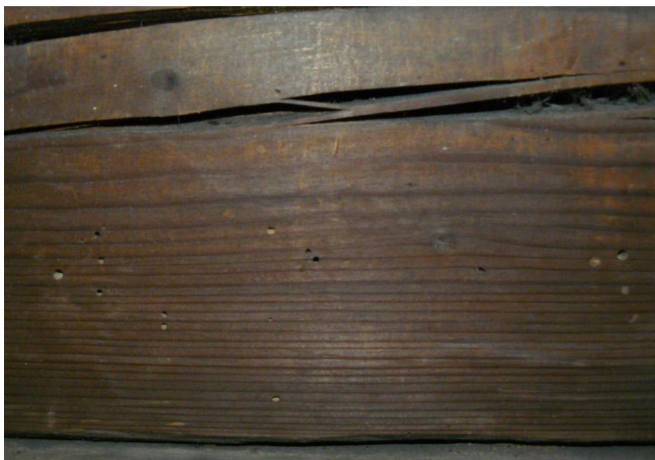
Obr. 1.1. Výletové otvory po drevokaznom hmyze na zadnej strane ikonostasu
