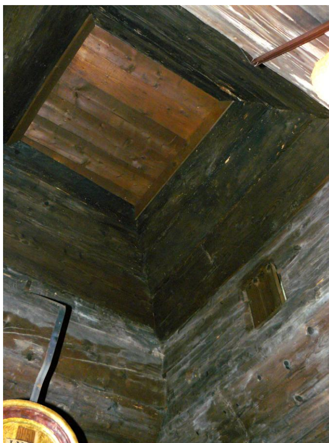
Obr. 1.3. Odstránenie papierového prekrytia stropu a vyčisteniu stropu presbytéria, v porovnaní s minulým rokom
