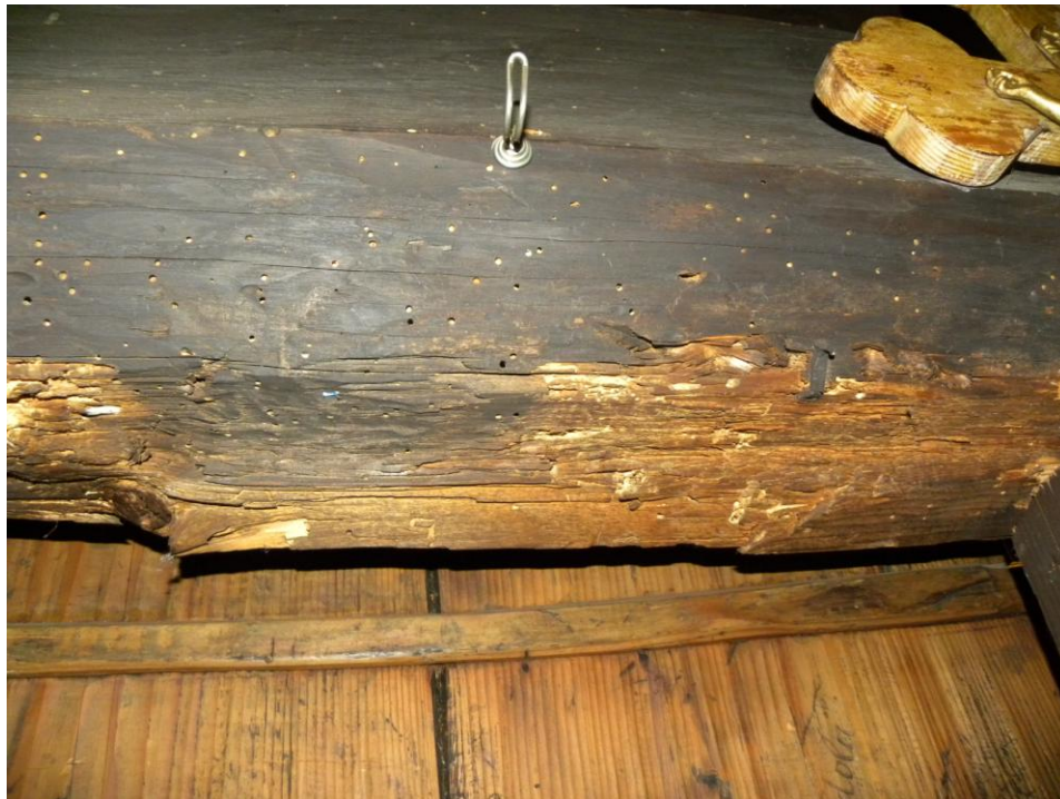
Obr. 5.4. Nosný trám za ikonostasom vykazuje vysoký stupeň biodegradácie – detail s výletovými otvormi po drevokaznom hmyze
