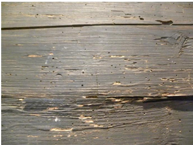
Obr. 5.2-3. Poškodenie drevnej hmoty zrubu v presbytériu, porovnanie so stavom z roku 2012. K výrazným zmenám v priebehu roku nedošlo.
