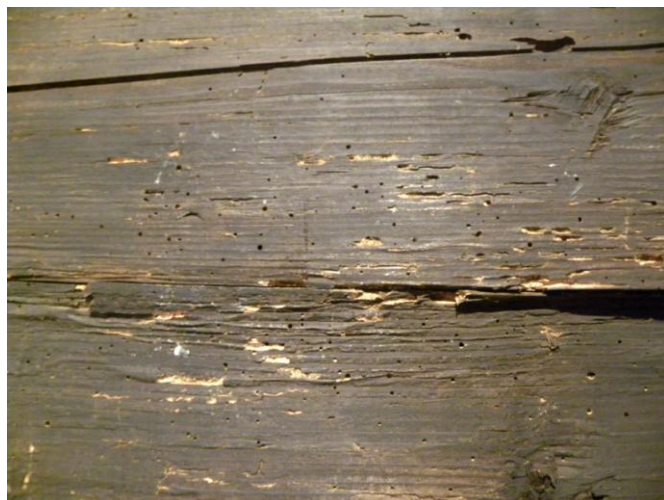
Obr. 5.2-3. Poškodenie drevnej hmoty zrubu v presbytériu, porovnanie so stavom z roku 2012. K výrazným zmenám v priebehu roku nedošlo.
