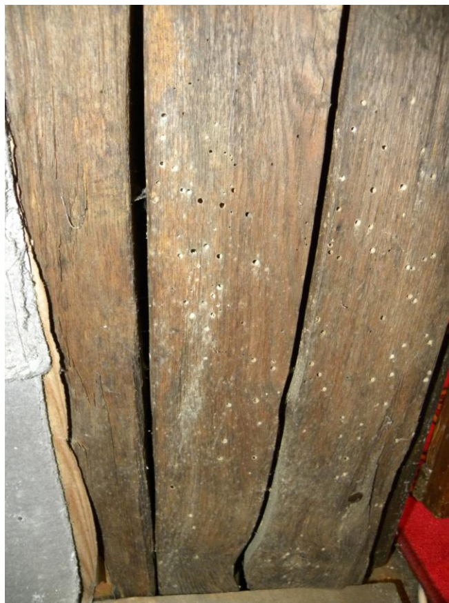
Obr. 7.5. Zadná strana ikonostasu - rozsiahly výskyt otvorov po drevokaznom hmyze
