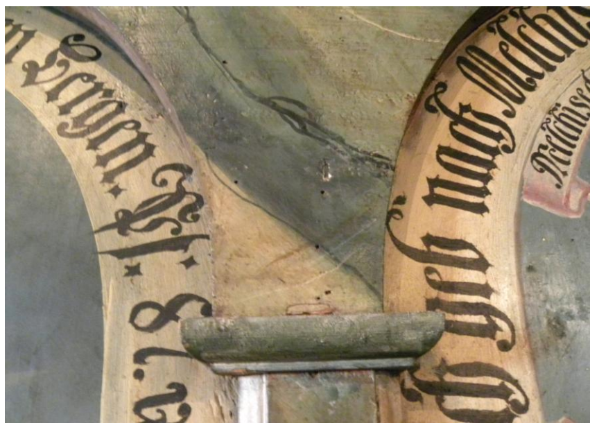
Obr. 4.6. Maľované obloženie stien za oltárom, výletové otvory po drevokaznom hmyze sa vyskytujú len ojedinele
