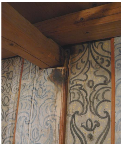
Obr. 6.6-7. Čierne fľaky na južnej stene, pravdepodobne staršieho pôvodu
