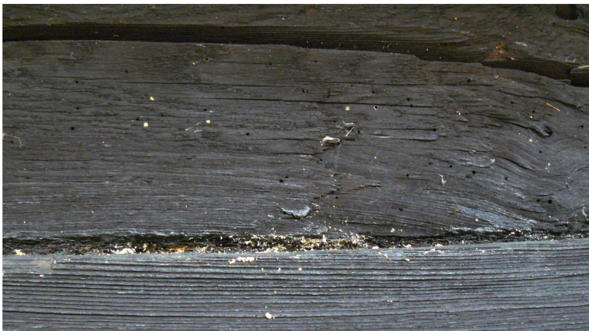
Obr. 7.3. Výletové otvory drevokazného hmyzu južnej aj severnej steny (exteriér) - aj s požerkami
