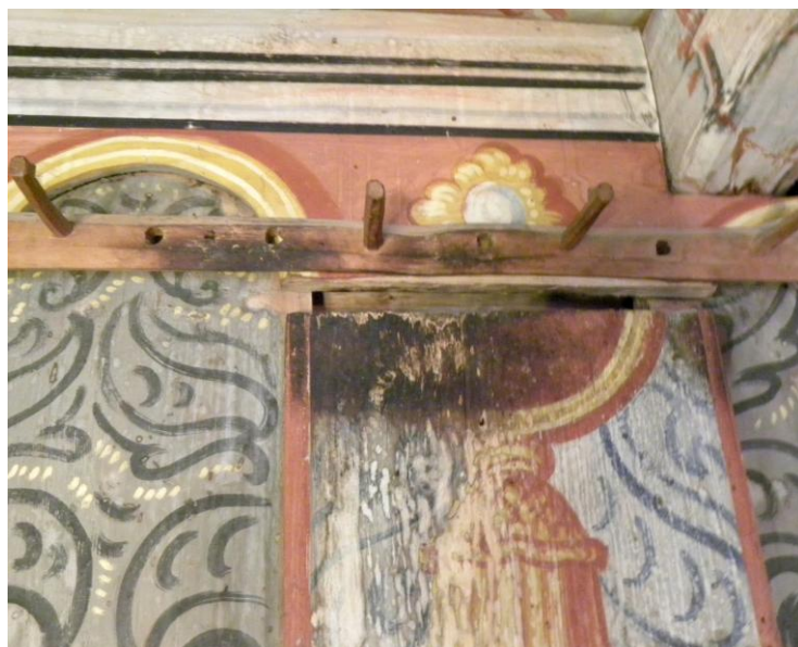
Obr. 6.6-7. Čierne fľaky na južnej stene, pravdepodobne staršieho pôvodu
