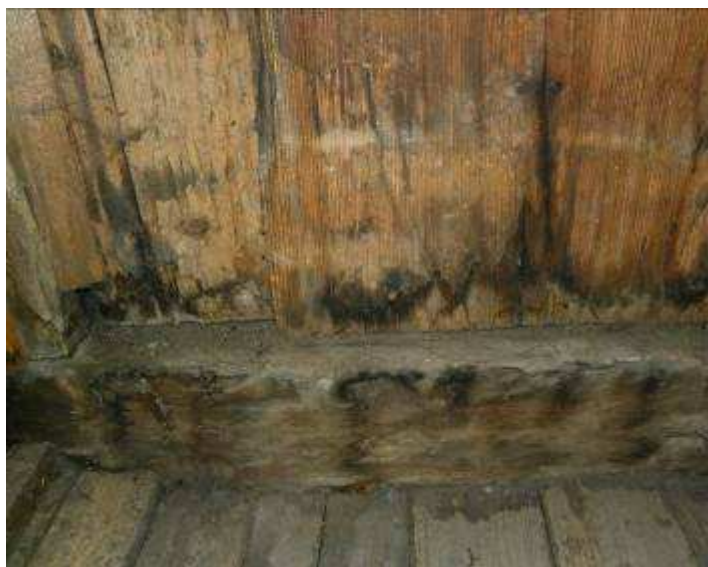
Obr. 3.8-9. Poškodenie stien a mobiliáru ako dôsledok zavlhania v minulosti.
