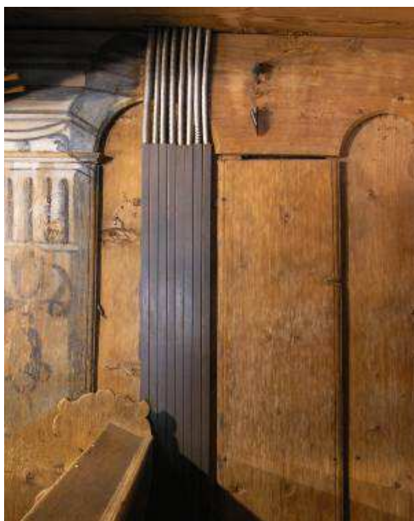
Obr. 6.9. Nové elektrické rozvody v objekte.
