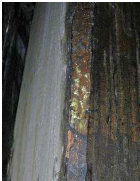
Obr. 4.5-6. Biely a žltý povlak na severovýchodnom stĺpe – pravdepodobne ide o neaktívne mycélium.
