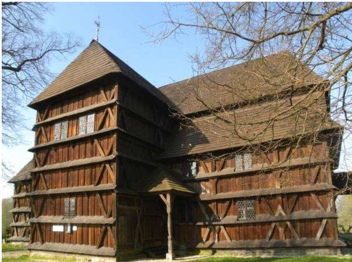
Obr. 3.1. Drevený artikulárny evanjelický kostol v Hronseku. Architektúra kostola sa vyznačuje jedinečnou hrazdenou konštrukciou.
