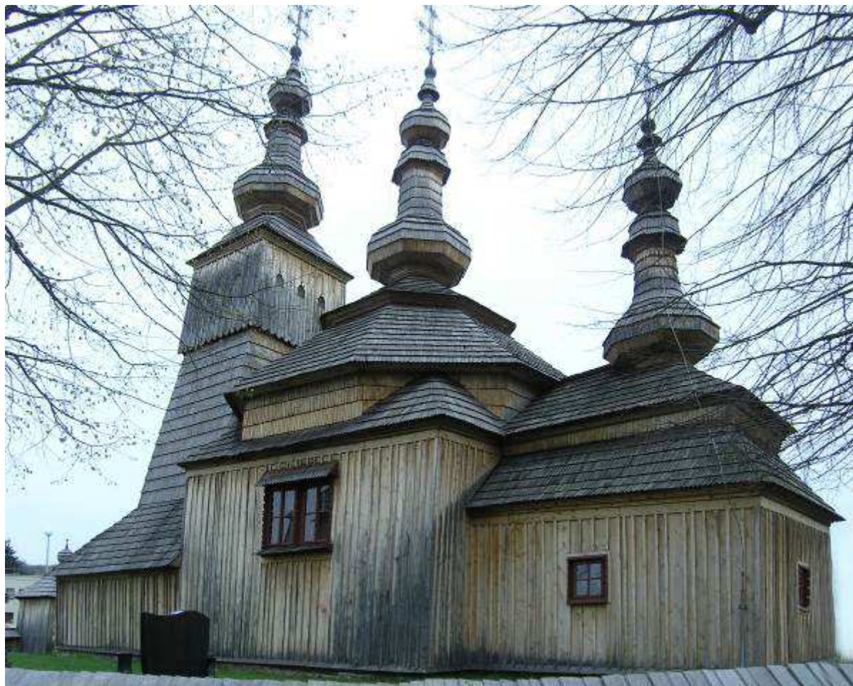
Obr. 5.1. Grécko-katolícky kostol sv. Michala Archanjela v Ladomírovej.
