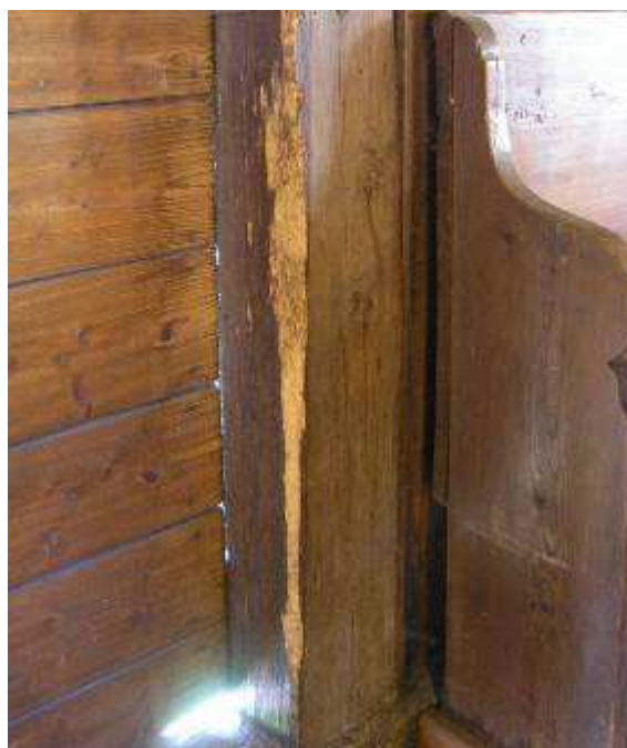
Obr. 3.5-6. Detail stĺpu na severnej strane a stĺpu na juhovýchodnej strane za oltárom – poškodenie drevokazným hmyzom.
