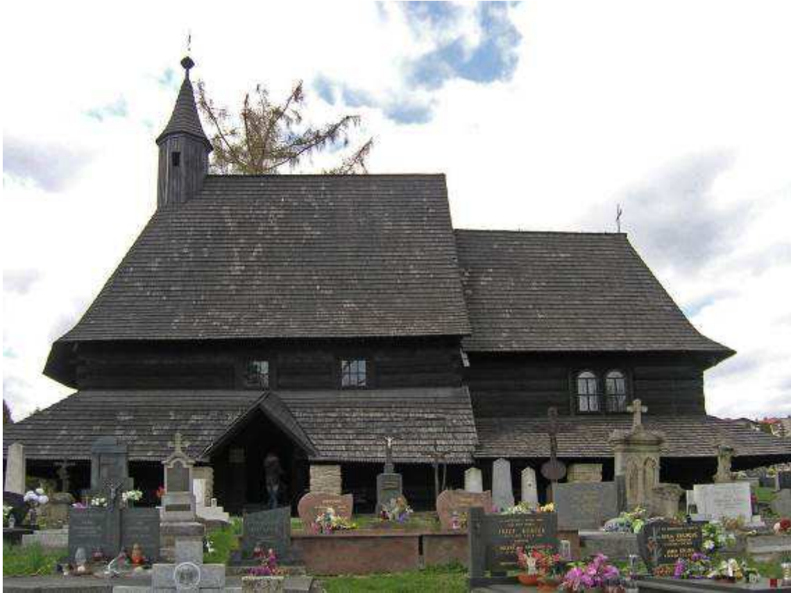
Obr. 8.1. Drevený rímsko-katolícky kostol v Tvrdošíne s ochodzou, ktorá vznikla po zastrešení spodnej časti kostola. V bezprostrednej blízkosti kostola sa nachádza cintorín.
