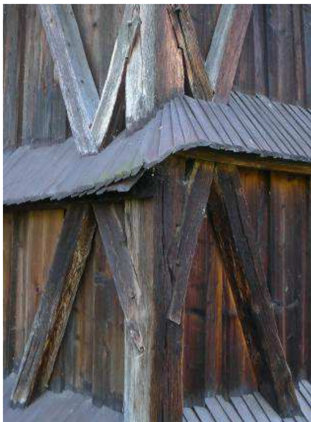
Obr. 3.2-3. Vľavo: degradované prvky hrazdenej konštrukcie. Vpravo: Znečistenie vtáčim trusom pod oknom na západnej strane objektu.
