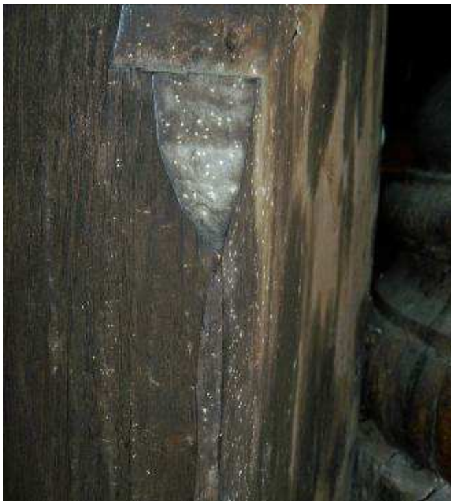
Obr. 4.5-6. Biely a žltý povlak na severovýchodnom stĺpe – pravdepodobne ide o neaktívne mycélium.
