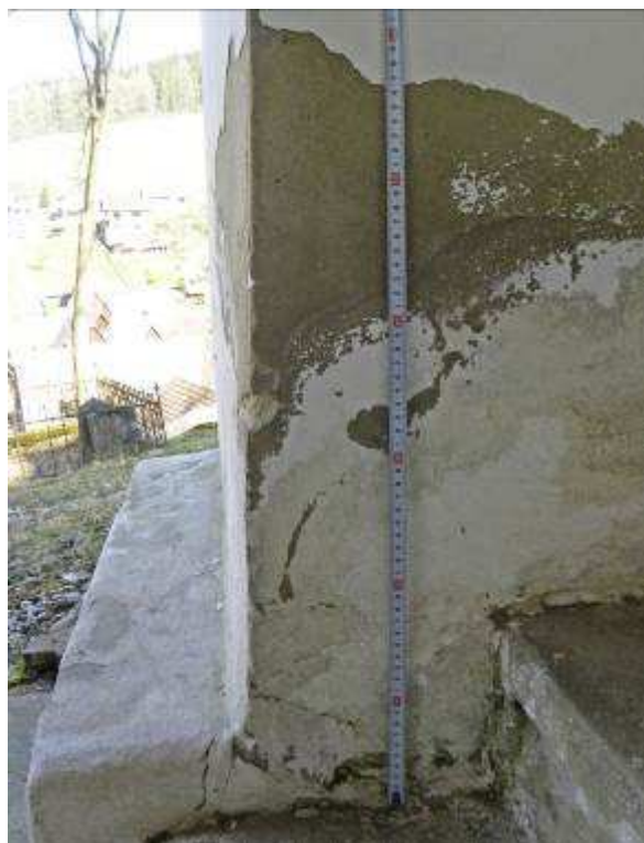
Obr. 6.2-3. Vlhkostné fľaky a opadaná omietka ľavého múra schodiska (až do výšky 60 cm) a na severozápadnom rohu.
