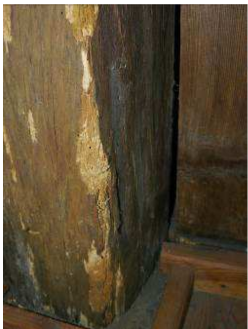
Obr. 3.5-6. Detail stĺpu na severnej strane a stĺpu na juhovýchodnej strane za oltárom – poškodenie drevokazným hmyzom.
