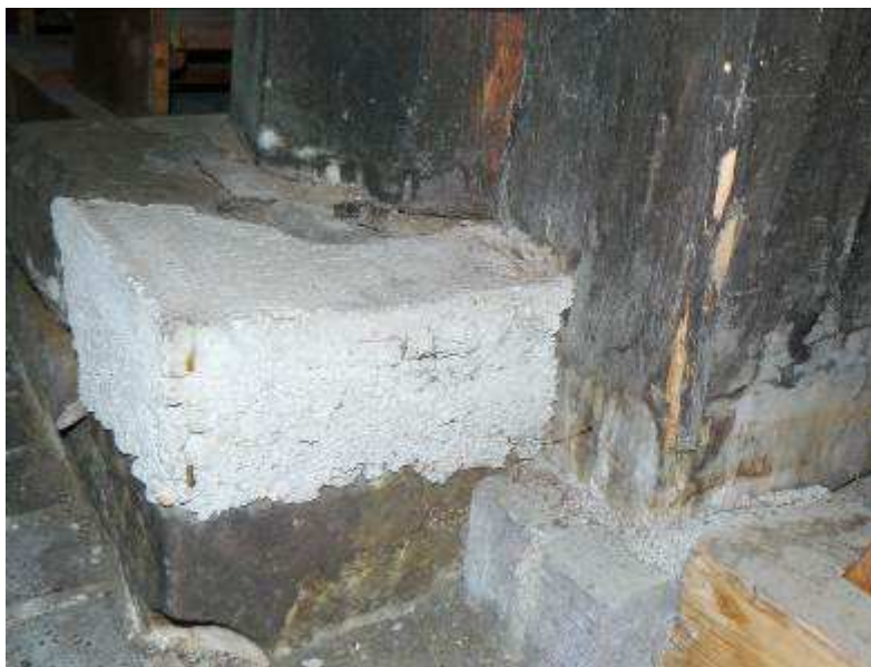
Obr. 4.7-8. Vľavo: pätky stĺpu na juhozápadnej strane nadstavaná betónovým obkladom. Vpravo: chumáčiky tmavej srsti, pravdepodobne pochádzajúce z kupy.
