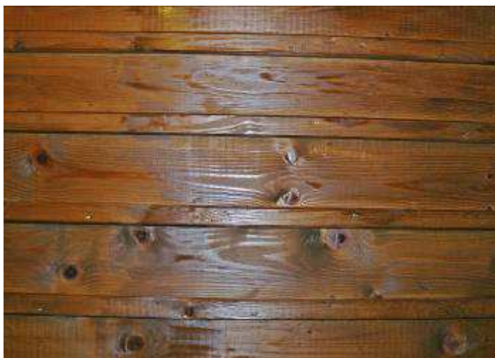
Obr. 7.5. Drevené obloženie stropu lode – prítomnosť tmavších línií naznačuje zavíhanie.
