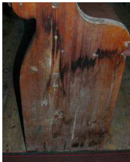
Obr. 3.8-9. Poškodenie stien a mobiliáru ako dôsledok zavlhania v minulosti.
