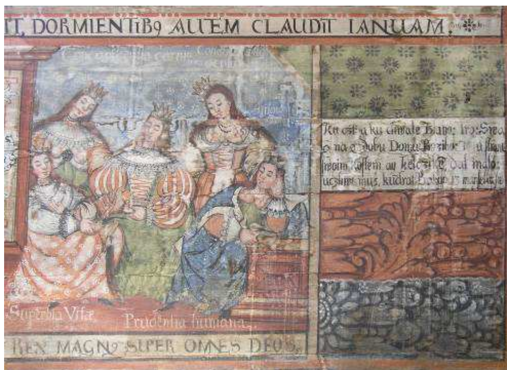
Obr. 2.7. Bohatá výzdoba severnej a južnej steny v hlavnej lodi je značne poškodená vplyvom zatekania a navíhania z minulosti.
