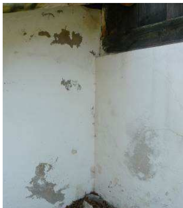
Obr. 6.2-3. Vlhkostné fľaky a opadaná omietka ľavého múra schodiska (až do výšky 60 cm) a na severozápadnom rohu.
