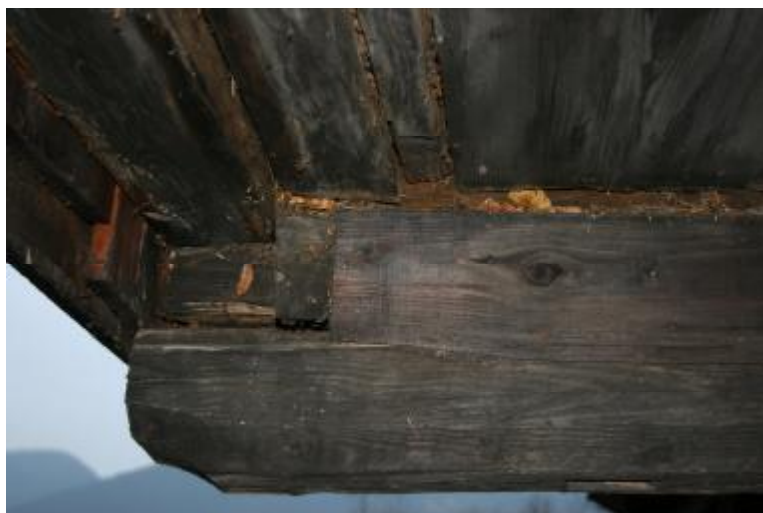
Postupná výmena krytiny, vyrezanie ohrozujúcich stromov, poškodenie prístupovej terasy biotickými škodcami – potreba ošetrovania.
