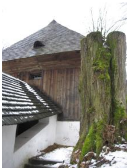
Postupná výmena krytiny, vyrezanie ohrozujúcich stromov, poškodenie prístupovej terasy biotickými škodcami – potreba ošetrovania.
