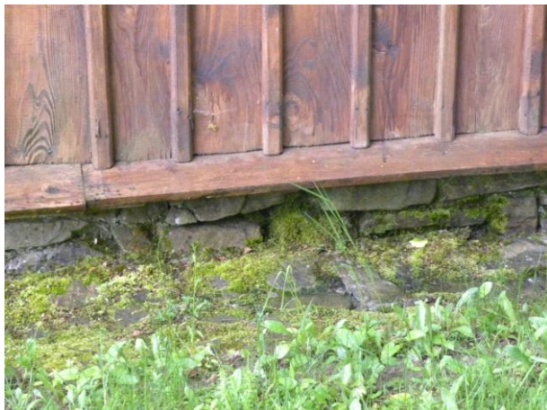
Obr. 2 Machom obrastený sokel kostola.
