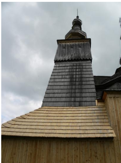
Obr. 49 Vymenené strešné šindľe nad predsieňou.
