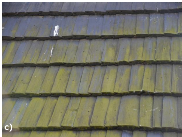
Obr. 94 a – c) Machom obrastené šindle na vstupnej bránke.
