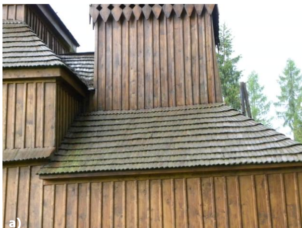
Obr. 4 a – b) Machom obrastené šindle na severnej strane kostola.
