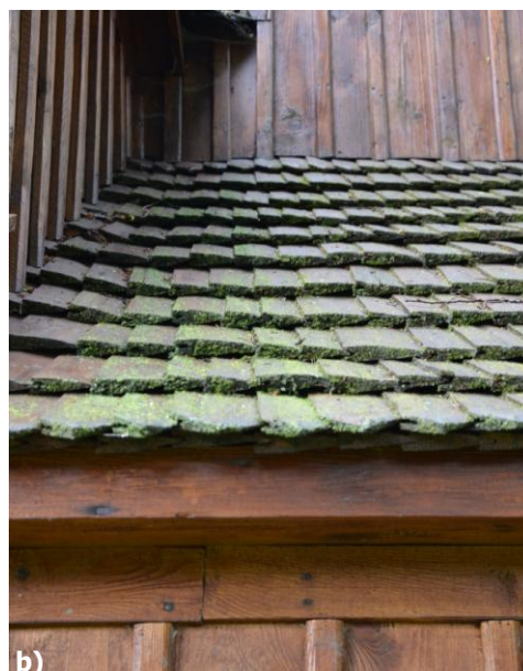
Obr. 3 Slnkom vyblednuté, ojedinele popraskané, rozštiepené strešné šindle.
