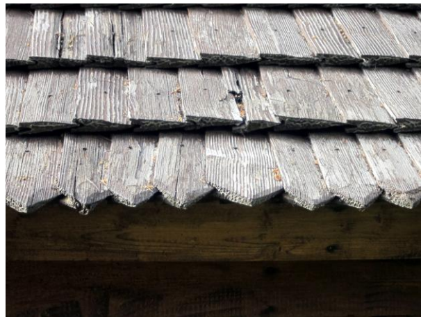
Obr. 3 Slnkom vyblednuté, ojedinele popraskané, rozštiepené strešné šindle.
