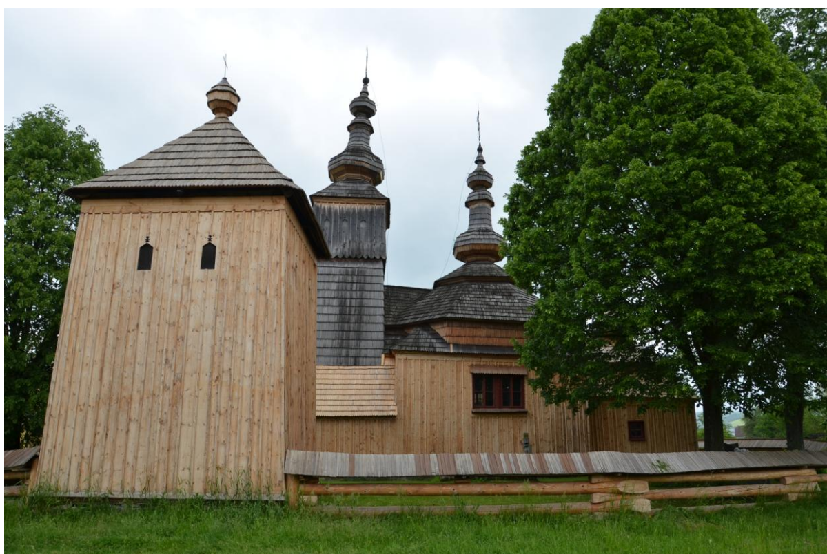
Obr. 47 Grécko-katolícky Kostol sv. Michala Archanjela v Ladomírovej, vymenené strešné šindle, stav máj 2016.
