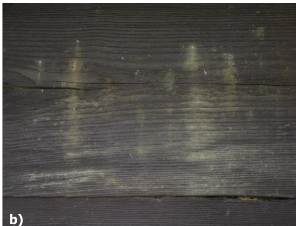
Obr. 78 a – b) Výletové otvory drevokazného hmyzu v trámoch zrubu severnej steny (exteriér) aj s požerkami.
