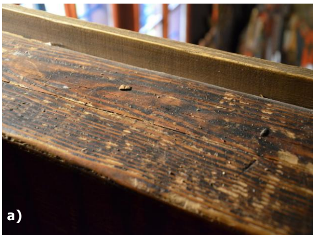
Obr. 55 a – b) Stopy po drewnokaznom hmyze a ich požerky na empore.
