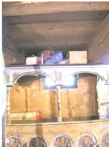
Obr. 73 Priestor v sakristii, na laviciach uskladnené krabice, zrolované koberce, epedy, ktoré zadržiavajú vlhkosť.
