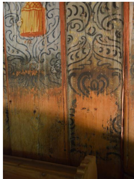
Obr. 72 Poškodenie maliarskej výzdoby na doskovom obložení vplyvom zavlhania a zatekania z minulosti – v niektorých miestach došlo k úplnému vymytiu farebnej vrstvy.
