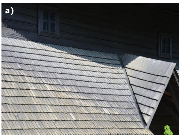
Obr. 95 a – b) Strešná krytina na severnej strane kostola obrastená nižšími rastlinami.
