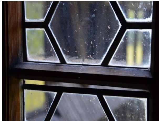
Obr. 25 Nepriliehajúce a netesniace okenné kazety.
