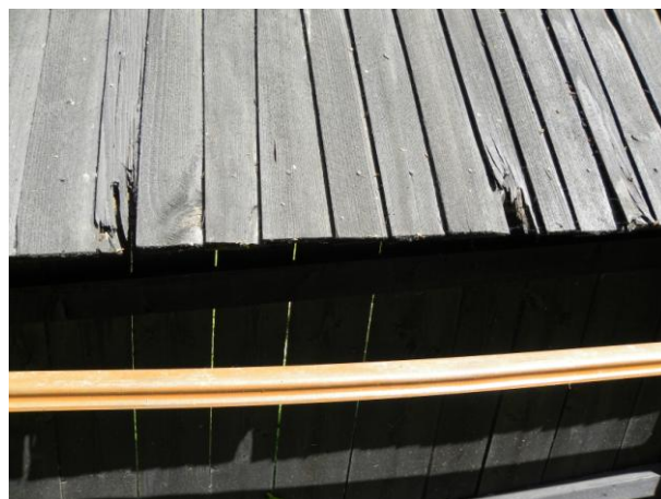
Obr. 66 Rozštiepené šindle oplatenia na južnej strane kostola.
