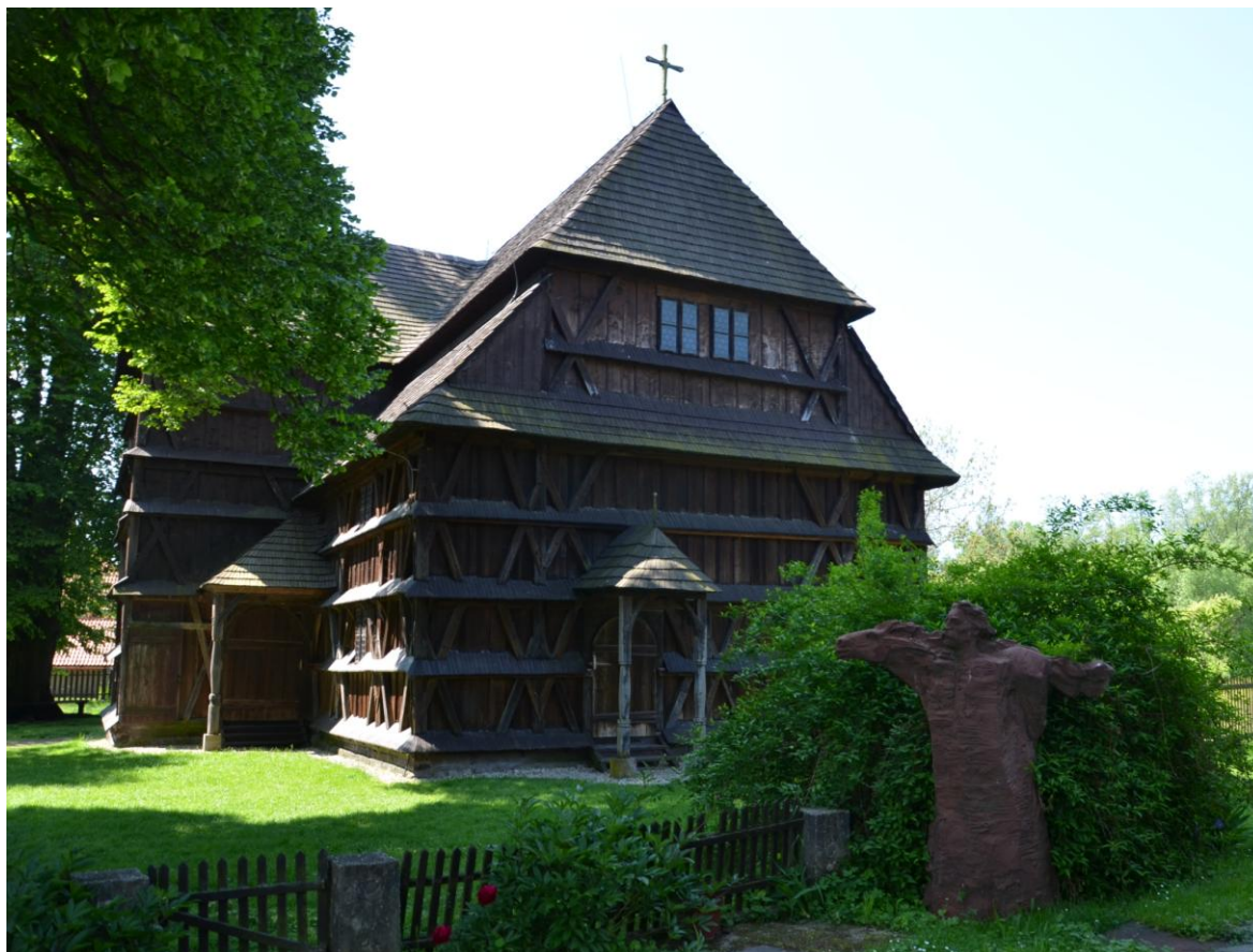
Obr. 19 Drevený artikulárny evanjelický kostol v Hronseku. Architektúra kostola sa vyznačuje jedinečnou tzv. hrazdenou konštrukciou.
