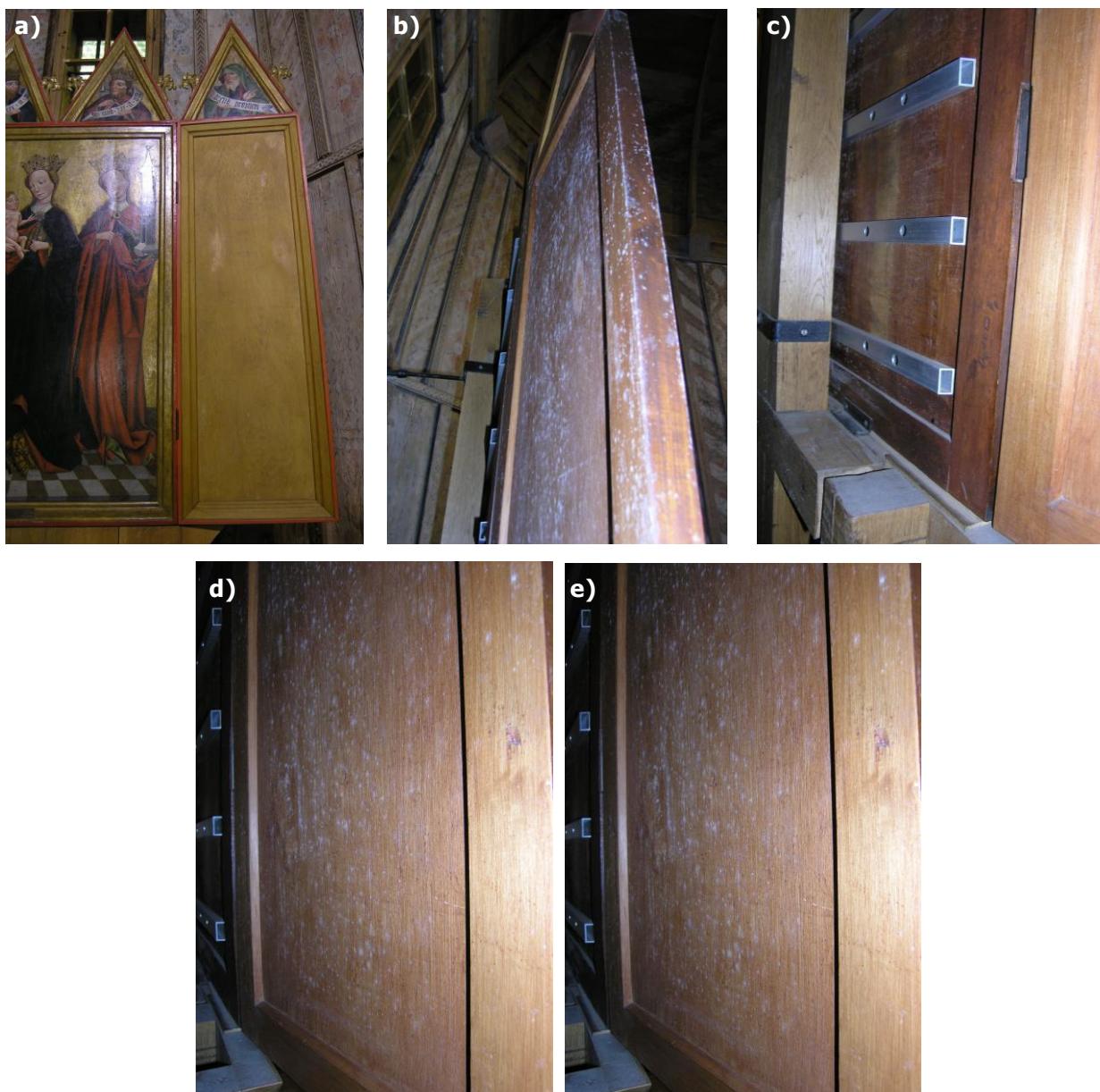
Obr. 18 Hlavný oltár napadnutý aktívnou plesňou.
