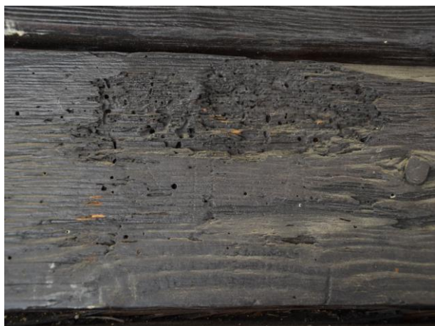
Obr. 97 Výletové otvory drevokazného hmyzu.
