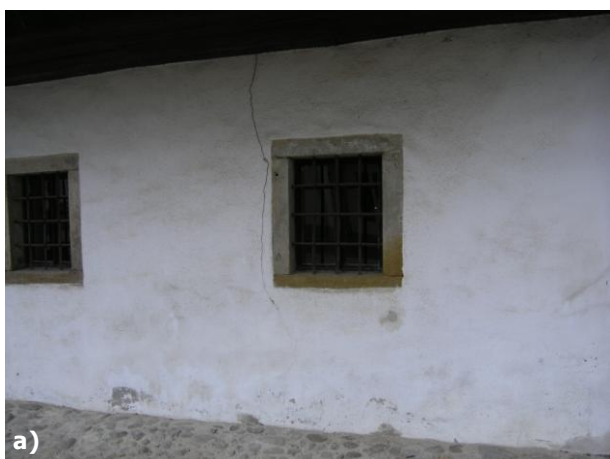
Obr. 35 a – b) Trhliny a opadanie bieleho náteru z omietky nad úrovňou dlažby na východnej stene.
