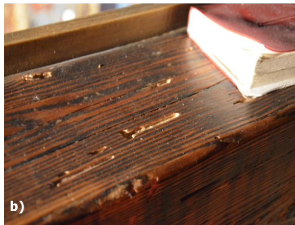
Obr. 55 a – b) Stopy po drewnokaznom hmyze a ich požerky na empore.
