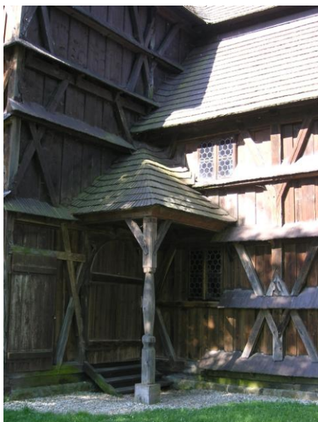
Obr. 20 Machom obrastené šindle a sokel.
