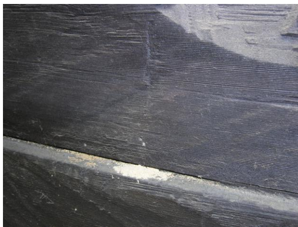
Obr. 98 Požerky po drevokaznom hmyze.
