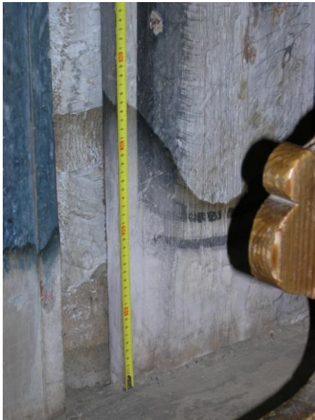
Obr. 69 Aktuálne zavlhávanie, vlhkostne fláky siahajúce do výšky 40 cm lavica, južná strana.
