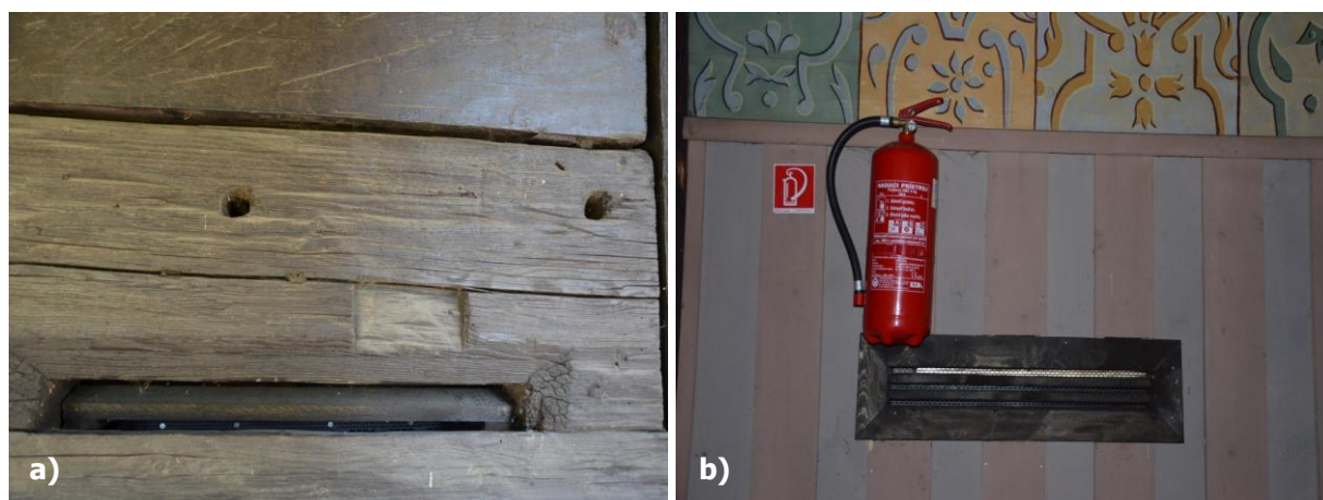
Obr. 100 a) Vetracie otvory z vonkajšej časti kostola na západnej strane, b) vetracie otvory z vnútornej časti kostola na západnej strane.
