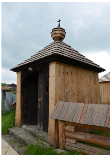
Obr. 48 Vymenené laty na vstupnej bránke.
