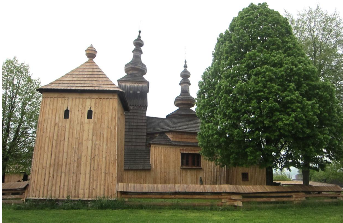
Obr. 46 Grécko-katolícky Kostol sv. Michala Archanjela v Ladomírovej, očistené oplatenie a opláštenie kostola a zvonice, stav máj 2015.
