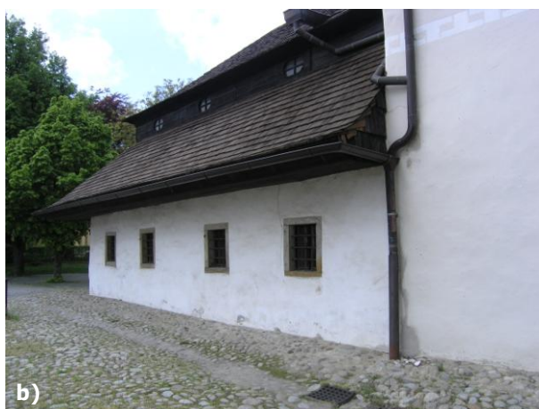
Obr. 35 a – b) Trhliny a opadanie bieleho náteru z omietky nad úrovňou dlažby na východnej stene.
