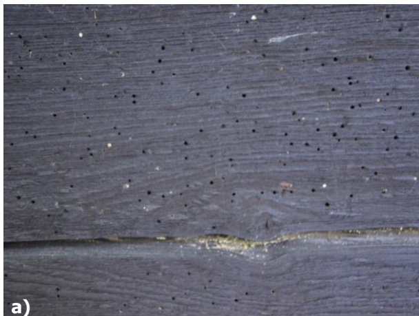
Obr. 78 a – b) Výletové otvory drevokazného hmyzu v trámoch zrubu severnej steny (exteriér) aj s požerkami.
