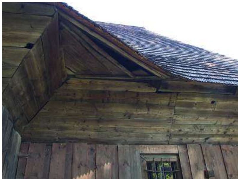
Obr. 6.3. Na spodnej strane strechy miestami chýbajú niektoré dosky.
