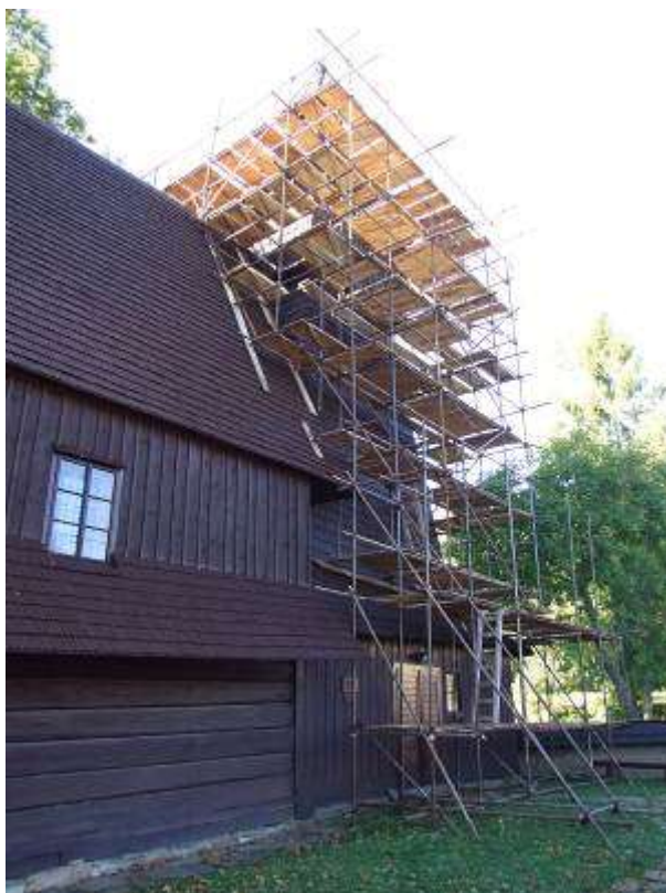
Obr. 2.2. Pohľad na severozápadnú časť kostola s lešením. Počas monitoringu stavu drevej hmoty kostola žiadne rekonštrukčné práce neprebiehali.
