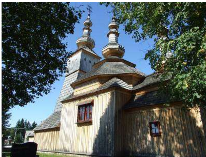
Obr. 5.1. Grécko-katolícky chrám sv. Michala Archanjela v Ladomirovej, opláštenie zrubovej konštrukcie ako aj šindľová krytina sú vymenené.
