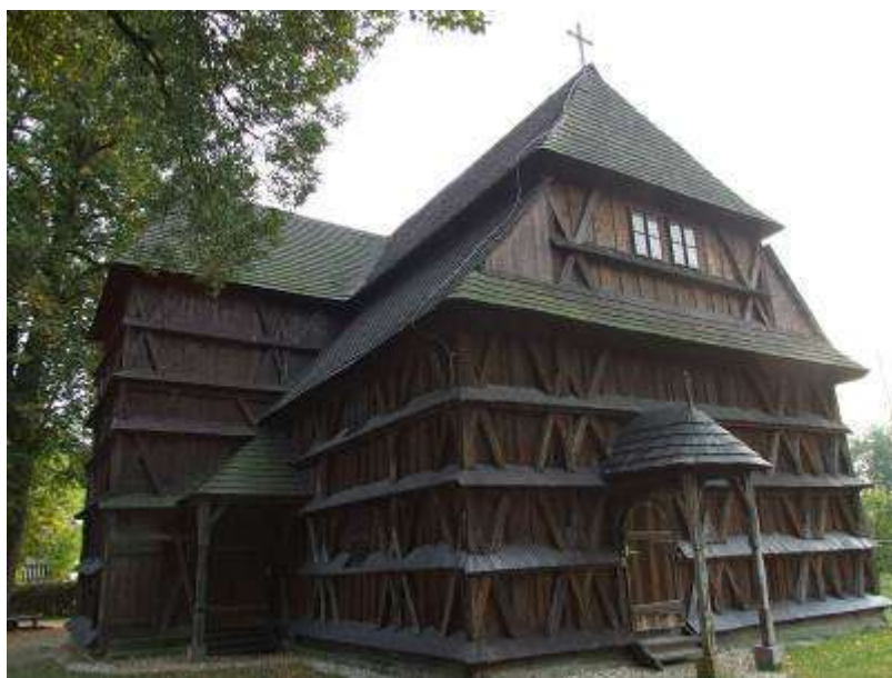
Obr. 3.1. Celkový pohľad na drevený artikulárny evanjelický kostol v Hronseku. Architektúra kostola sa vyznačuje jedinečnou hrazdenou konštrukciou.
