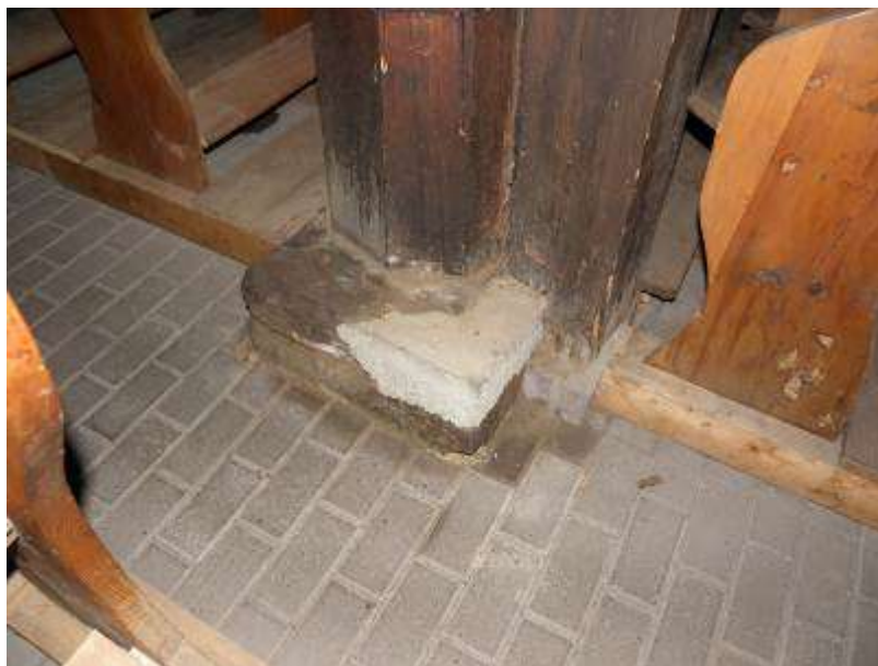
Obr. 4.5. Detail pieskovcovej pätky ozdobného stĺpu dorobenej betónom. Podporný stĺp je umiestnený na pätke zo zámkovej dlažby.
