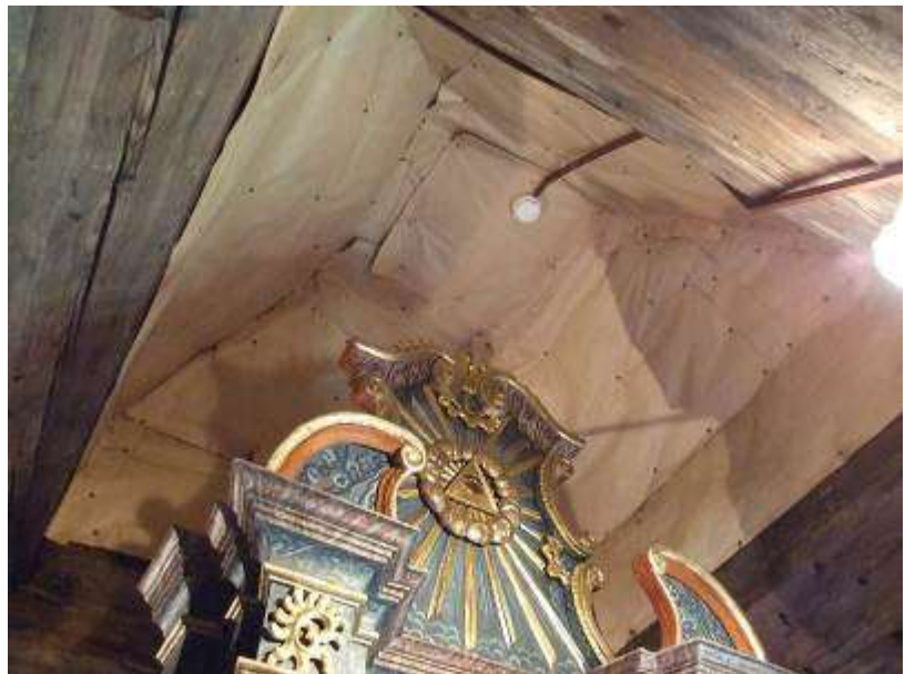
Obr. 1.3. Prekrytie stropu presbytéria papierovým obalom
