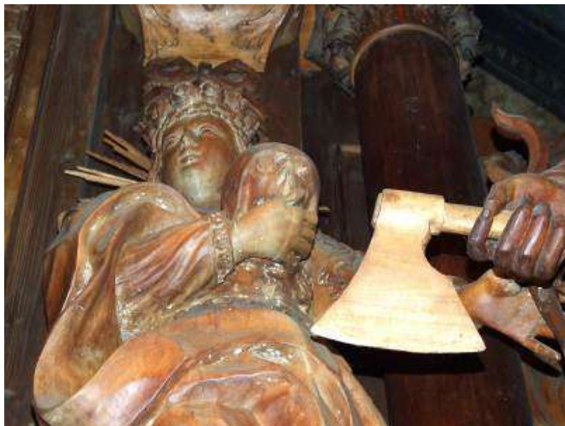
Obr. 8.5. Neskorobarokový oltár je rozsiahle napadnutý plesňami. Plesne sa vyskytujú na sochách, aj na architektonických článkoch oltára (detail sochy s výskytom plesní najmä v záhyboch šiat).
