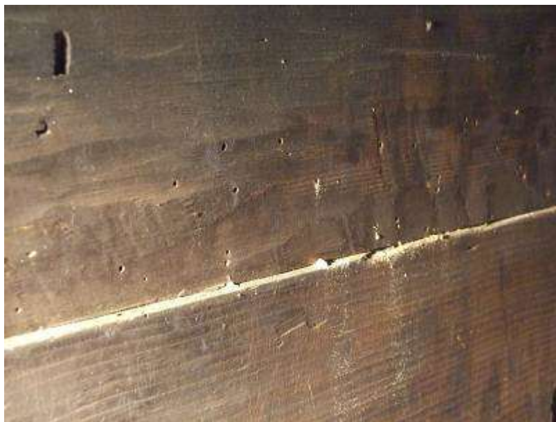
Obr. 5.3. Pozorované čerstvé výletové otvory a požerky zodpovedajú aktívnemu drevokaznému hmyzu.
