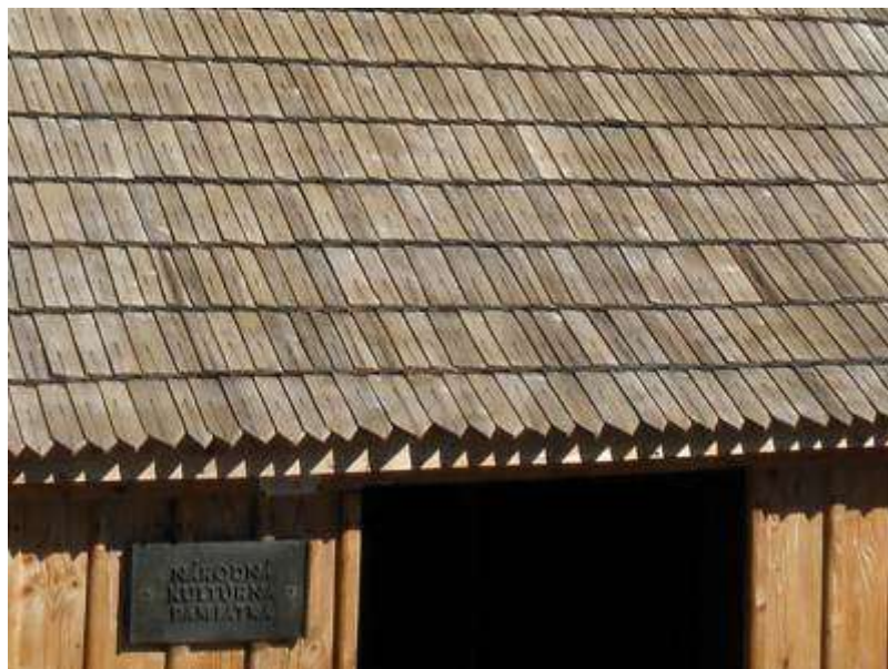
Obr. 1.2. Detailný pohľad na západnú časť kostola pri vchode s novými vertikálnymi doskami z jedľového dreva. Rovnako je nový aj šindel.
