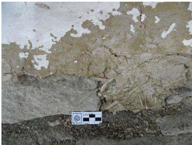
Obr. 2.3. Detail kamenného sokla kostola omietnutého hlinenou mazanicou so zvyškami vápenného náteru. V častiach nad zemou je omietka poškodená a opadáva.
