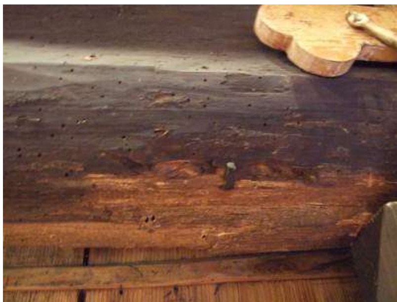
Obr. 5.5. Rozsiahly výskyt výletových otvorov drevokazného hmyzu v nosnom tráme ikonostas.
