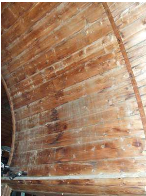
Obr. 3.5. Stopy po zatekaní boli pozorované aj na klenbe kostola, pochádzajú z minulosti.
