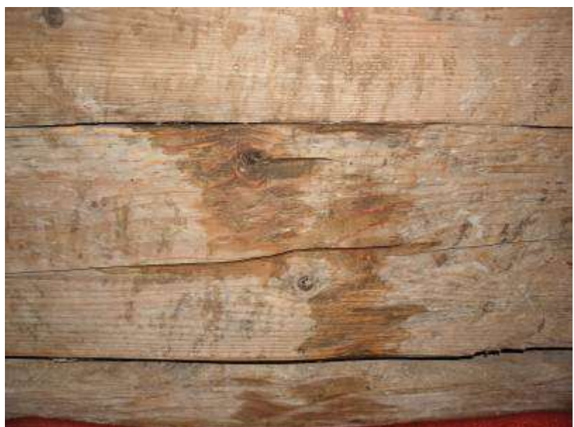
Obr. 1.5. Presaky na južnej stene presbytéria, ktoré tiež súvisia s čistením opláštenia v exteriéri
