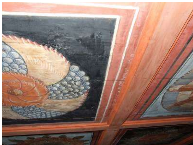
Obr. 8.7. Plesne boli pozorované aj na kazetovom strope v lodi.
