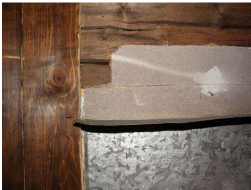
Obr. 7.4. Pozinkovaný plech podložený kartónom zo zadnej strany ikonostasu. Navlhnutý kartón môže byť potenciálnym rizikom napadnutia drevokaznými hubami.
