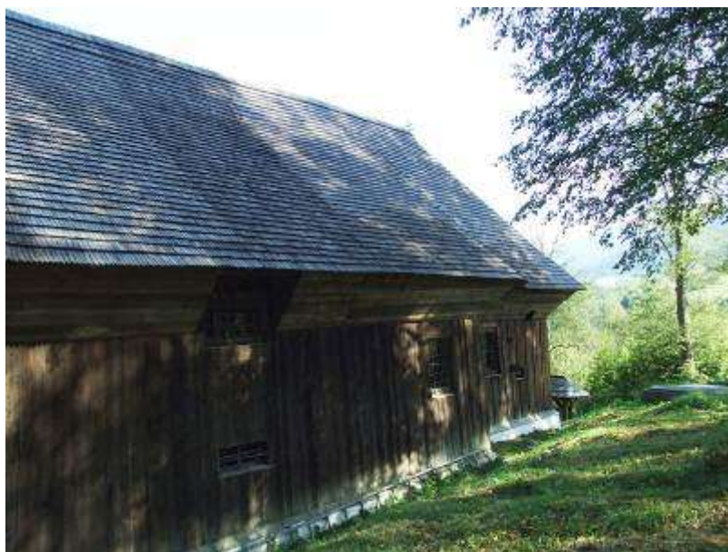
Obr. 6.1. Pohľad na južnú stranu kostola, kde je sokel priamo zasadený do svahu, čím sa vyrovnávajú veľké terénne nerovnosti.
