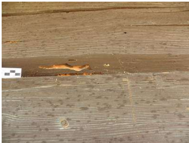
Obr. 2.4. Stopy po aktívnom drevokaznom hmyze boli v exteriéri pozorované prevažne na južnej a juhovýchodnej strane zrubovej konštrukcie.
