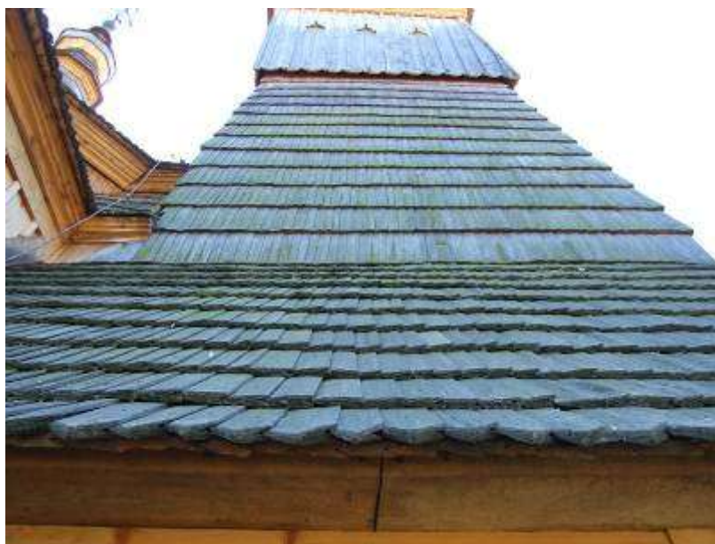
Obr. 5.2. Na severnej strane je šindel porastený nižšími rastlinami – machmi. Inak je krytina kompaktná, v dobrom stave.
