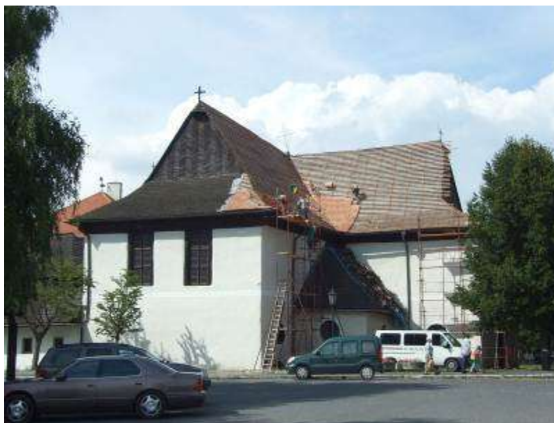
Obr. 4.1. Pohľad na východné priečelie evanjelického kostola. V súčasnosti prebieha výmena strešnej krytiny.
