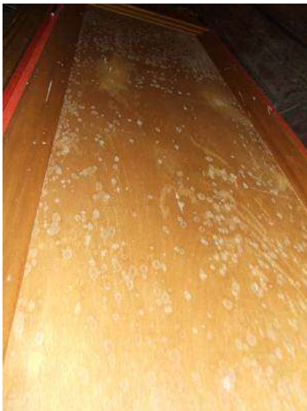
Obr. 2.7. Detail výplne bočného krídla hlavného oltára napadnutej plesňami
