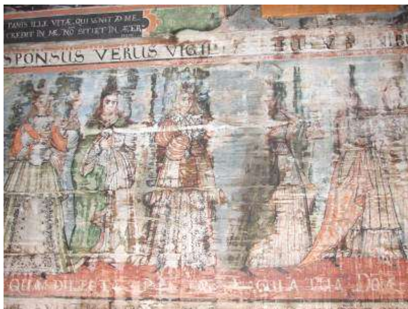
Obr. 2.5. Bohatá výzdoba severnej a južnej steny v hlavnej lodi je značne poškodená vplyvom zatekania a navlhania.
