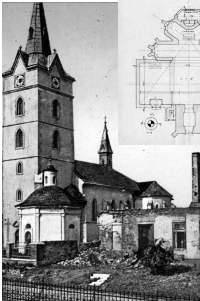
Farský Kostol sv. Margity Antiochijskej a Kaplnka sv. Anny. Vedľa budova školy zničená v roku 1915. Archív PÚ SR.
