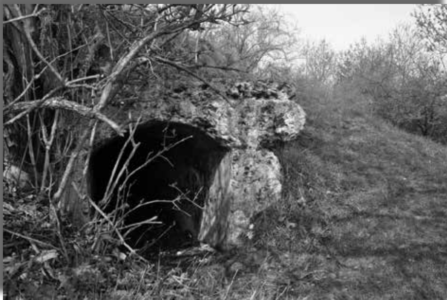
Dúbravka, kaverna č. 1, vstupný portál, stav v roku 2013. Foto: Ľ. Vodička.
