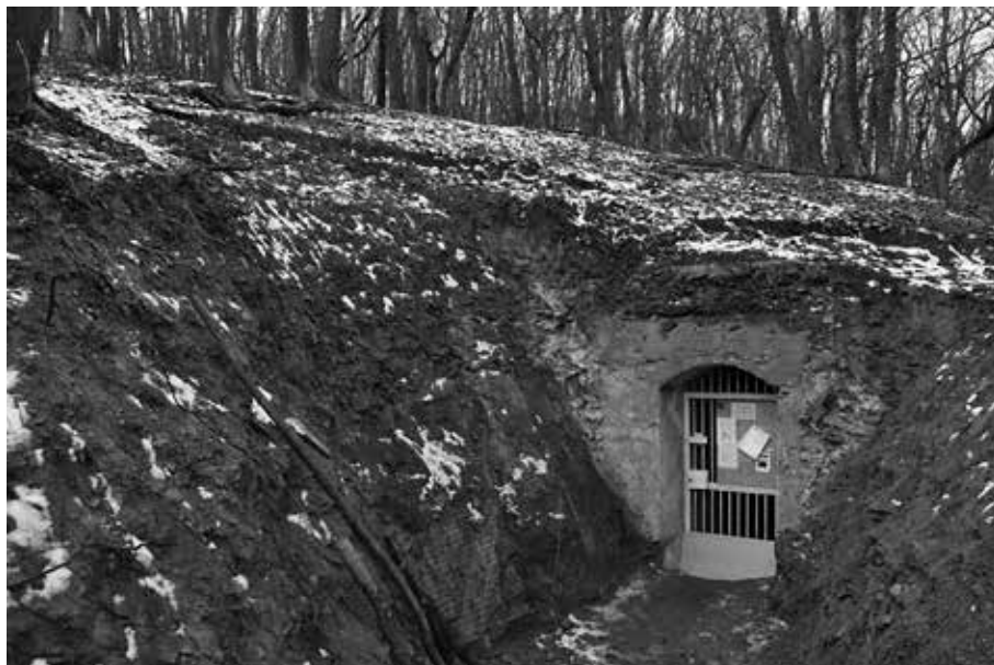
Dúbravka, kaverna č. 2, stav po obnove, február 2014. Foto: Ľ. Vodička.
