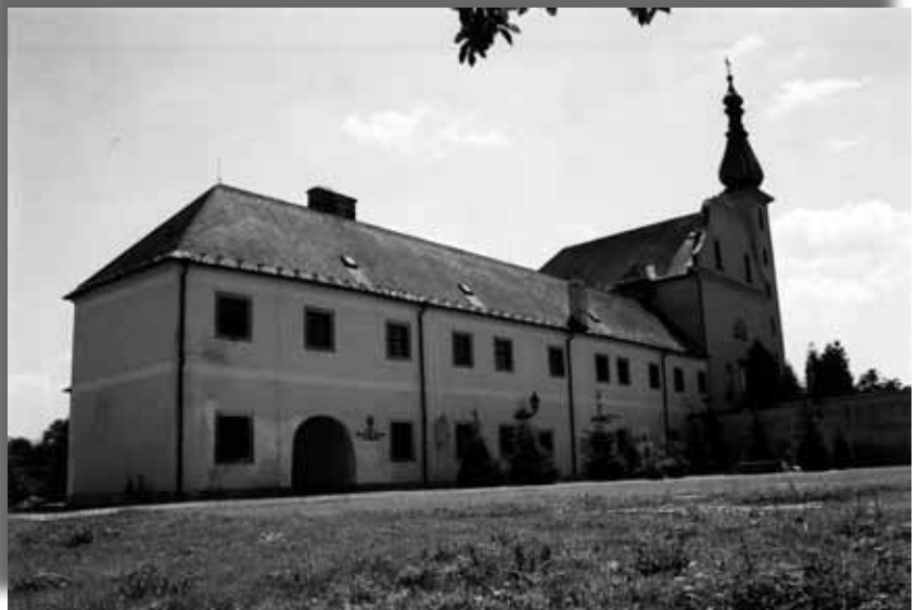
Kostol a kláštor františkánov v Nižnej Šebastovej. Foto: Archív PÚ SR.
