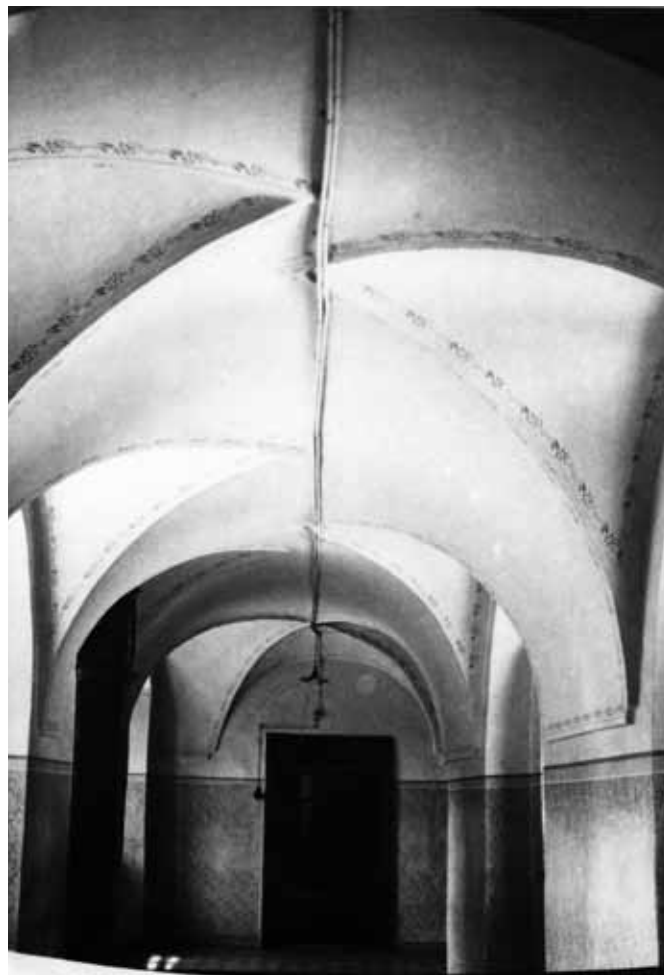
Chodba v kláštore františkánov v Bardejove. Foto: Archív PÚ SR, 1951.
