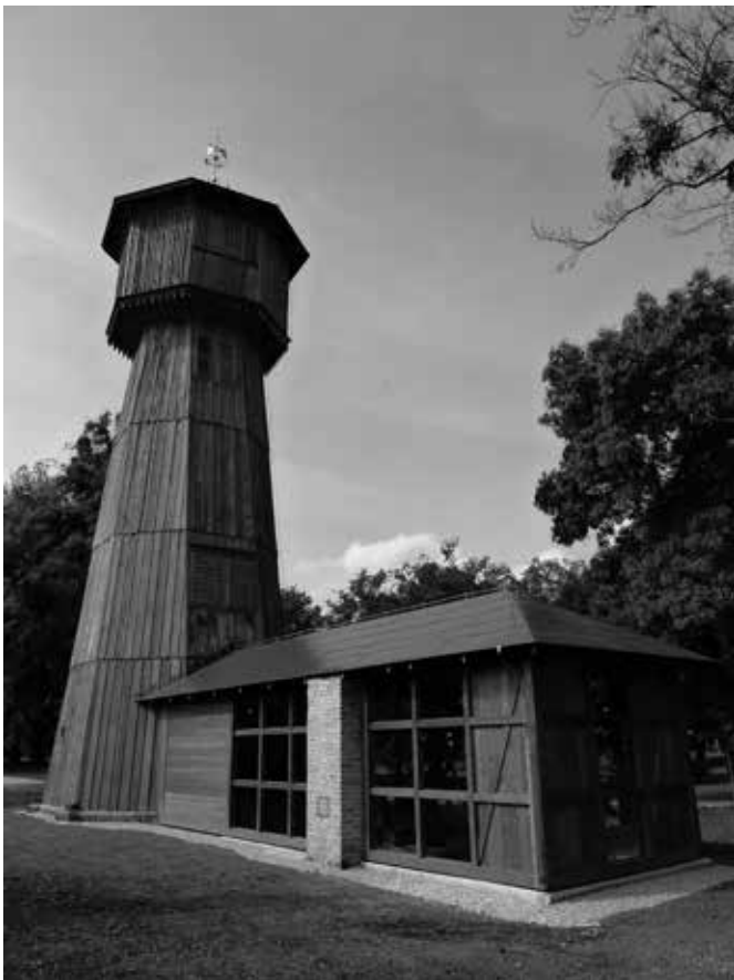
Celodrevená vodárenská veža v Palárikove po obnove. Foto: I. Tóth.
