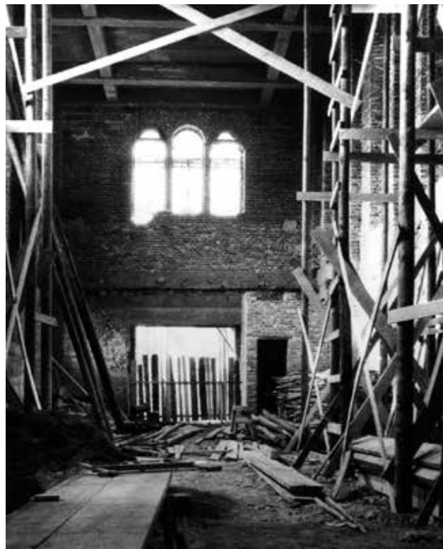
Interiér kostola počas rekonštrukcie v roku 1953. Foto: Ľ. Zelms, Archív PÚ SR.
