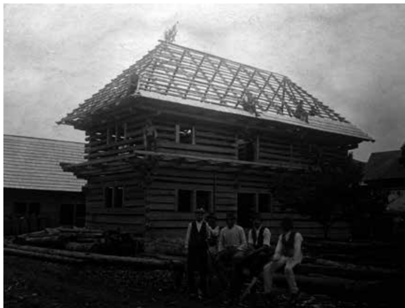
Stavba Radenovho domu v roku 1924. Foto: Archív PÚ SR.
