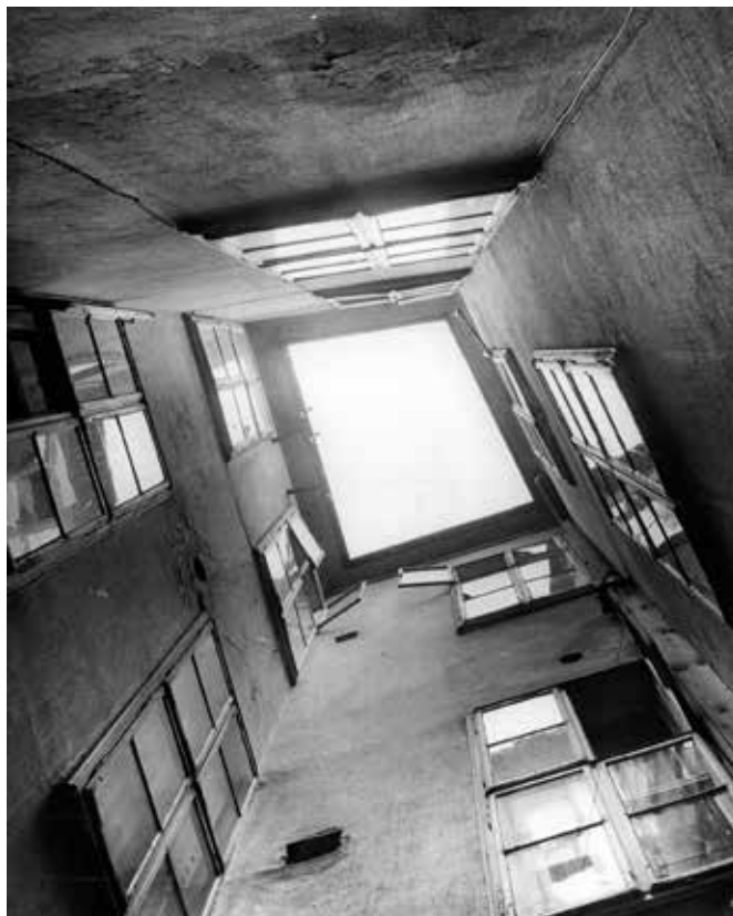
Dvorové fasády na Zámocníkovej 5, blok č. 3. Archív PÚ SR, sign. T 915/2.
