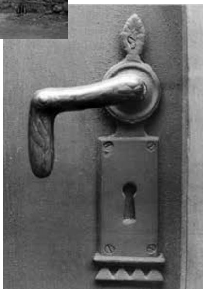
Kľučka vstupnej brány na Ventúrskej 11, blok č. 15. Archív PÚ SR, sign. T 5014/6.
