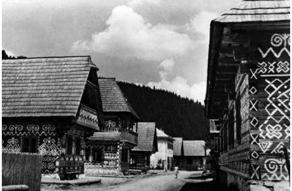
Hlavná ulica s radovou zástavbou po obnove dolného konca. Zdroj: Album fotografií ľudového staviteľstva v Čičmanoch, uložený na Obecnom úrade Čičmany.
