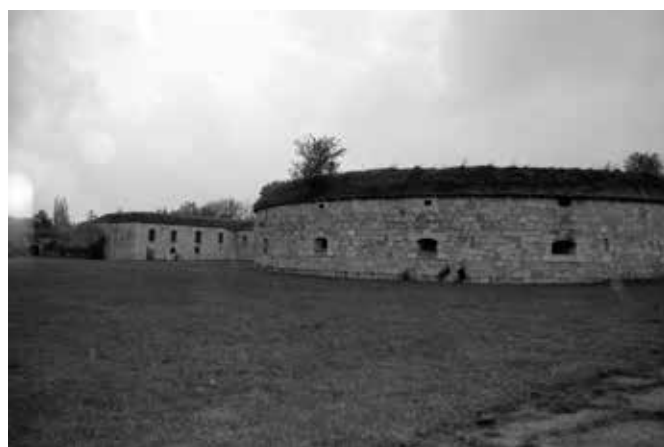
Rondel bastiónu II., ktorého jadrové murivo je obložené kameňom v polygonálnej skladbe. Foto: A. Németh, 2014.
