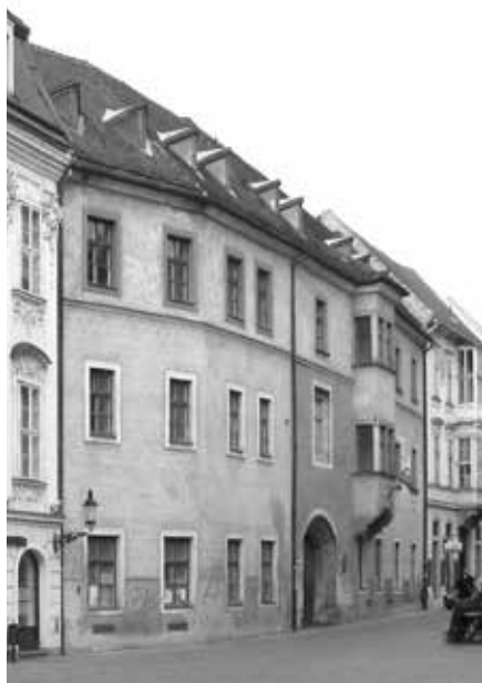
Bratislava, budova Academie Istropolitany. Foto: Archív PÚ SR, P. Fratrič, 2003.
