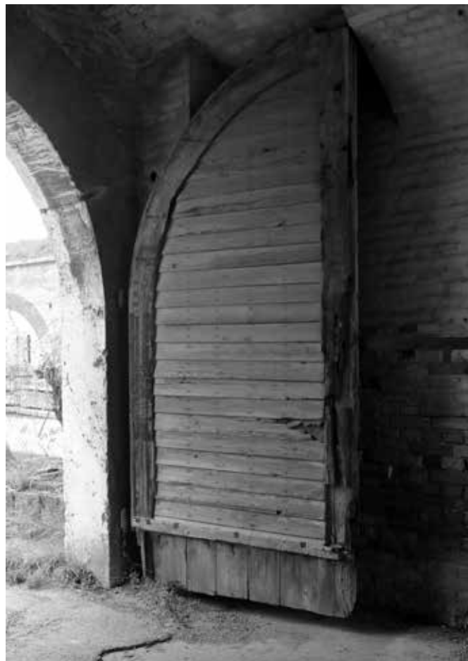
Jedna z mála pôvodných brán zachovaná v bastióne III. Napriek na prvý pohľad žalostnému stavu je bránu možné opraviť a mohla by slúžiť ako vzor na rekonštrukciu ostatných brán Palatínskej línii. Foto: autor, 2014.
