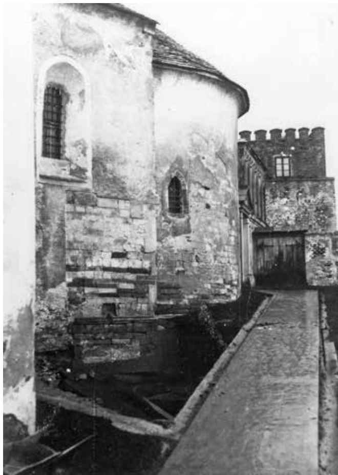
Juhozápadný pohľad na Kaplnku sv. Emeráma. Foto: Archív PÚ SR, 1931.
