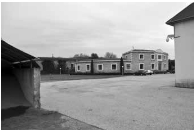
Neobvyklý novodobý zásah do Palatínskej línie výstavbou novej administratívnej budovy na základoch pôvodného delového rondelu v bastióne IV., ktoré sa zachovali do výšky kamenného sokla. Nutné je však uznať, že novostavba nepôsobí rušivo. Foto: Z. Bobáň, 2014.
