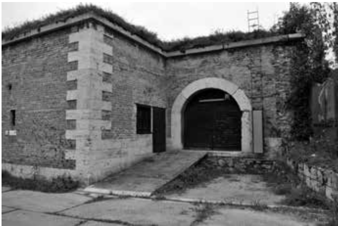
Delový rondel (reduit v dutom priestore) bastiónu III. s bránou pre dopravu kanónov. Foto: Z. Bobáň, 2014.
