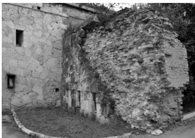
Torzo múru po asanovanej bráne pri ľavom krídle retranchementu bastiónu IV. Dobře viditeľná je skladba múru s vnútornou hmotou, vymurovanou z plných tehál pálených a krytých vrstvou kamenného polygonálneho muriva. Foto: Z. Bobáň, 2014.
