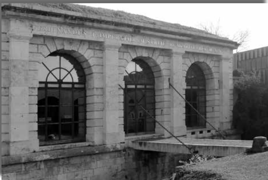
Bratislavská brána s naznačeným padacím mostom, pohľad zvonka pevnosti smerom od Bratislavy. Foto: autor, 2014.
