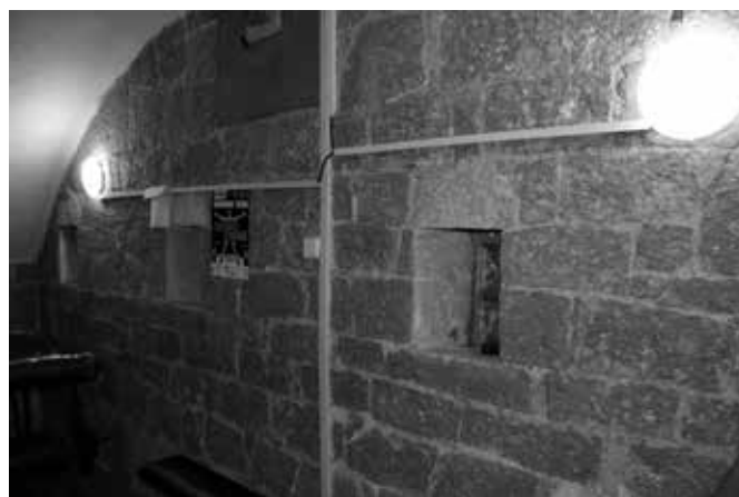
Kvádrikové murivo – lícová strana múru streleckej galérie medzi bastiónmi I. a II. Tri viditeľné otvory predstavujú strielne, t. č. uzatvorené luxfermi. Foto: A. Németh, 2014.
