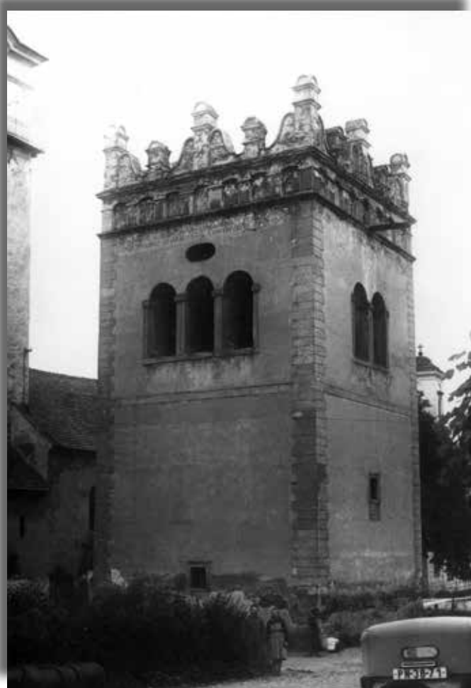
Renesančná zvonica v Poprade, stav z roku 1955. Foto: Archív PÚ SR, R. Kedro.
