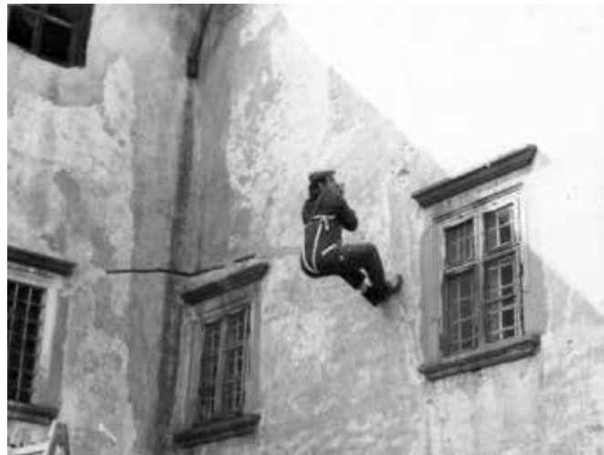
Brezovica, renesančný kaštieľ po prestavbe 1601. Podrobný výskum fasád s nálezom sgrafitovej výzdoby okna a zameranie architektonických článkov, 1979. Kolektív ateliéru pamiatkového výskumu PÚK stredisko 4 v Prešove. Foto: Ing. Kanda.
