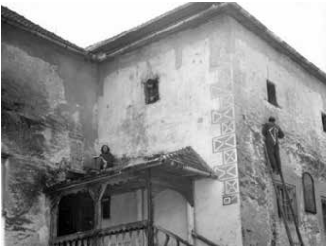
Brezovica, renesančný kaštieľ po prestavbe 1601. Podrobný výskum fasád s nálezom sgrafitovej výzdoby okna a zameranie architektonických článkov, 1979. Kolektív ateliéru pamiatkového výskumu PÚK stredisko 4 v Prešove. Foto: Ing. Kanda.
