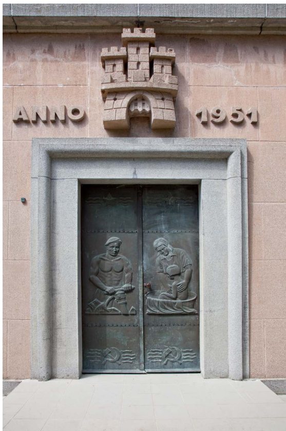
► Obr. 7. Vodojemy s areálom č. ÚZPF 12158/1-10, Bratislava.
