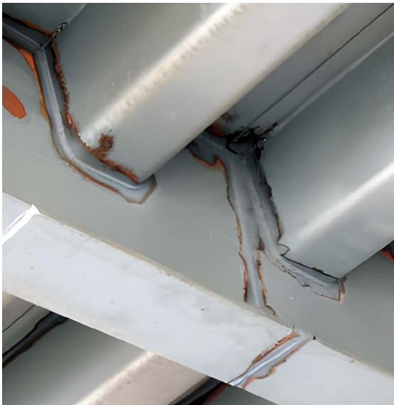
► Obr. 15. Čistenie povrchu pred kontrolami trhlín, Bratislava.
