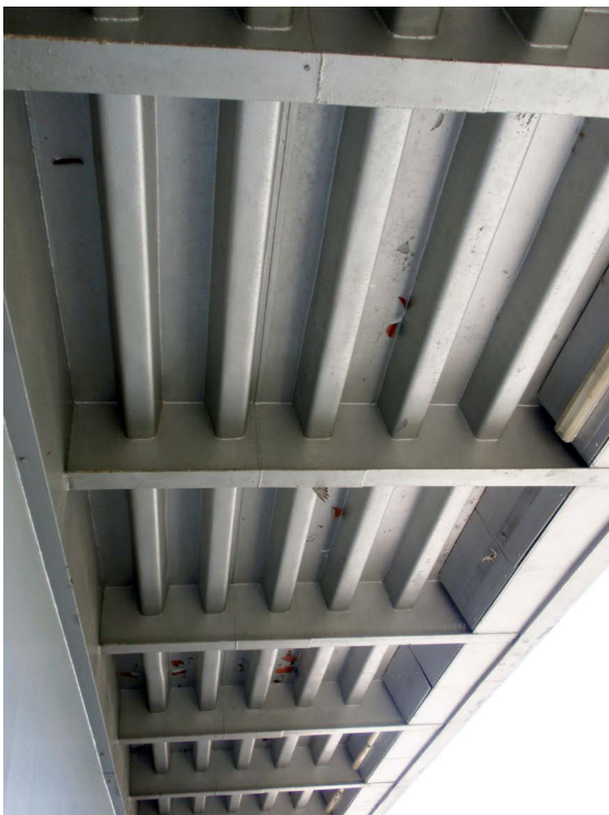
► Obr. 20. Zváraná konštrukcia, Bratislava.
