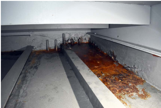
► Obr. 14. Zanesenie odvodňovacieho otvoru, Bratislava.
