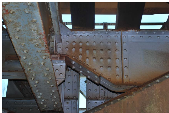
► Obr. 47. Nahradenie poškodených nitov skrutkami, Nižná Myšľa.
