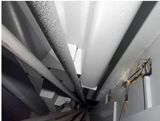
► Obr. 2. Trvalé meranie deformácií a napätia konštrukcie, Bratislava.
