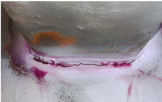
► Obr. 27. Zisťovanie trhlín penetračnou metódou, Bratislava.
