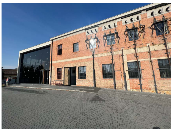
► Obr. 58. Moderná prístavba rieši slnečné tepelné zisky, s pôvodnou budovou je vykurovaná s využitím suterénu, na plochej streche sú doplnené fotovoltaické panely.
