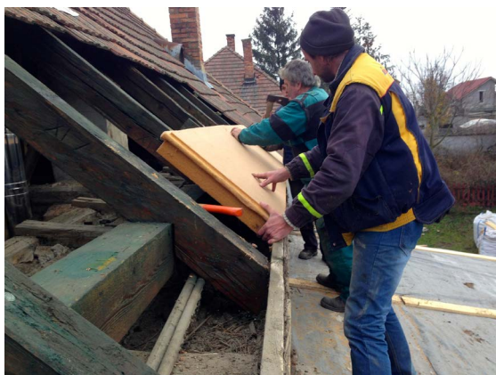
► Obr. 25. Zateplenie podkrovia nad úrovňou krokví difúzne otvorenou drevovláknitou doskou, budova starej školy, Hrubý Šúr.
