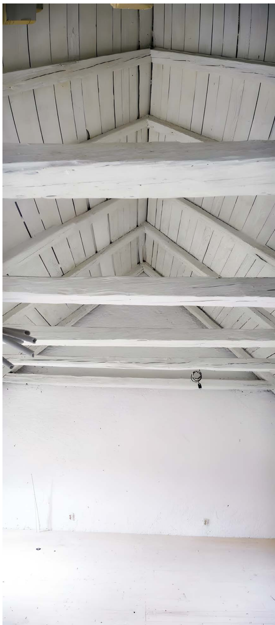
► Obr. 24. Zateplenie podkrovia nad úrovňou krokví, zachované krokví a doštenie prezentované v interiéri, Banská Štiavnica.
