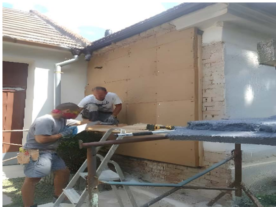
► Obr. 9. Zateplenie prírodnými materiálmi. Bočná fasáda, zateplená kontaktné drevovláknom. Objekt nie je NKP a nenachádza sa v pamiatkovom území, Višňuk.
