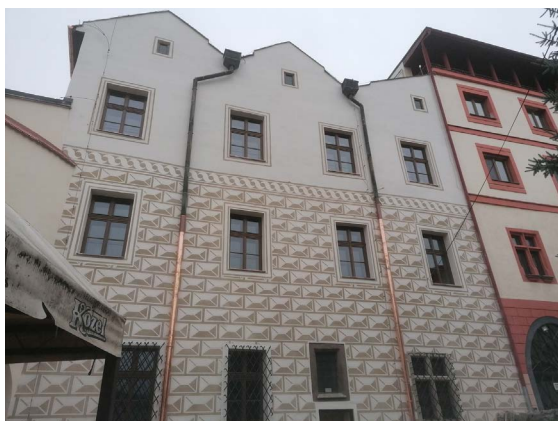
► Obr. 13, 14. Exteriérová omietka obsahuje tepelnoizolačnú prísadu, Thurzov dom, Banská Bystrica.
