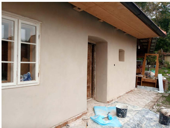
► Obr. 11, 12. Zateplenie prírodnými materiálmi. Objekt nie je NKP a nenachádza sa v pamiatkovom území, Višňuk.
