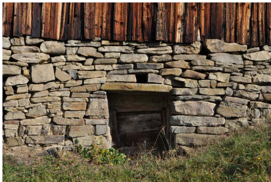
► Obr. 3. Hospodársky objekt postavený výlučne z tradičných a lokálnych materiálov.
