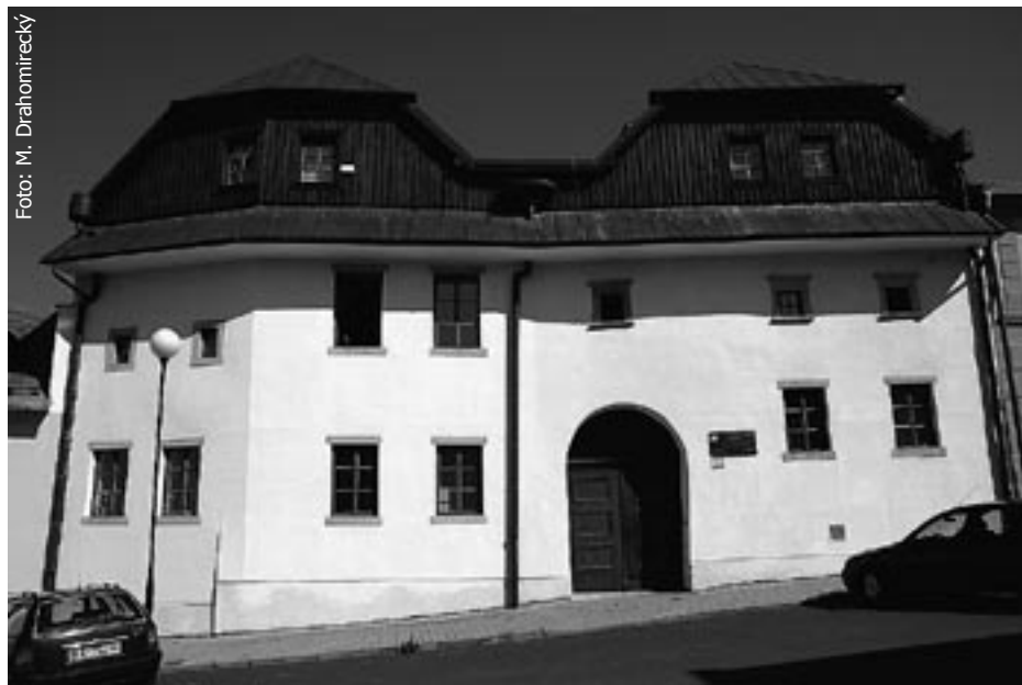
Čelný pohľad na objekt ORA Levoča na Novej ul. 55
